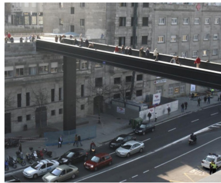
[Fig.235] Pasarela sobre Avenida de Beiramar
