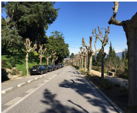
[Fig.65] Carretera sobre el tercer recinto
