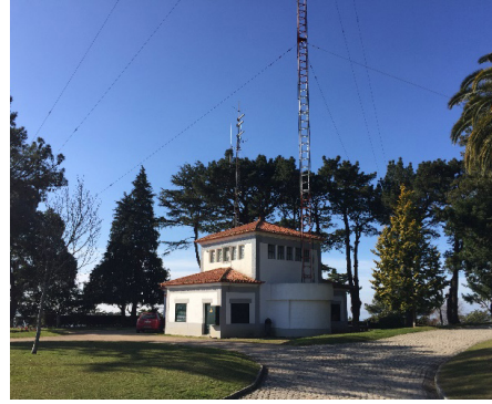
[Fig.69] Repetidor de ra- dio
