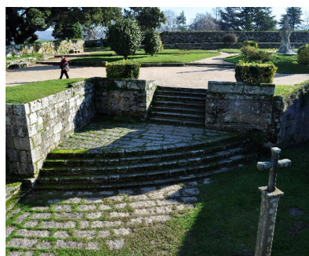
[Fig. 56] Escaleras de la puerta primitiva
