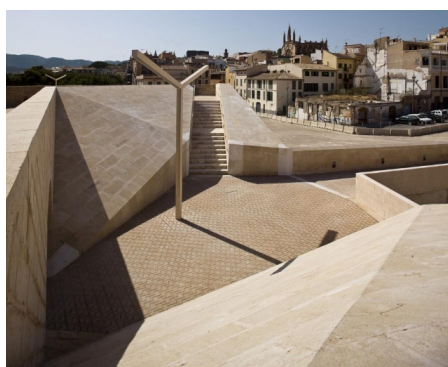
[Fig.260] Escaleras de acceso
