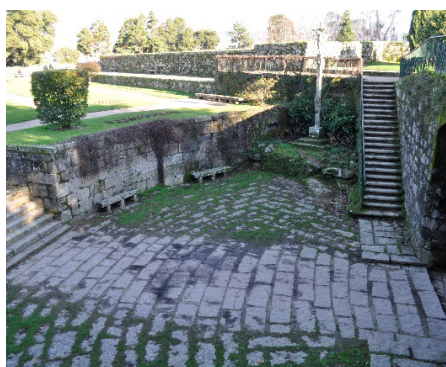
[Fig. 55] Escaleras de a puerta nueva
