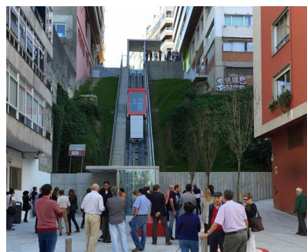
[Fig.231] Ascensor ya en funcionamiento
