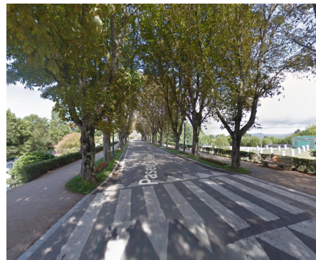
[Fig.66] Carretera sobre el camino cubierto
