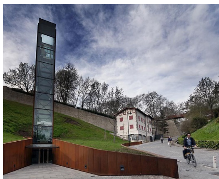
[Fig.289] Acceso inferior
