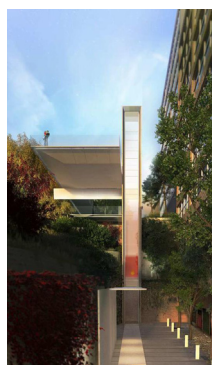
[Fig.229] Ascensor pro- yectado en Par- que
