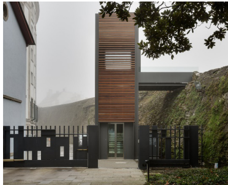
[Fig.280] Acceso inferior del ascensor
