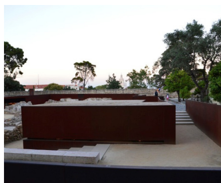
[Fig.265] Accesos y muro perimetral
