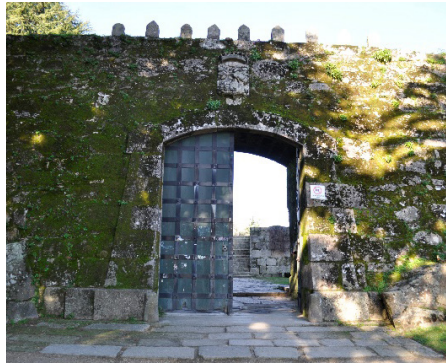
[Fig.43] Puerta nueva desde el exterior
