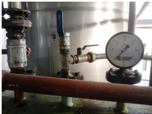
Torneiras superiores de saída de ar do filtro.
