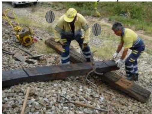
Figura 2 – Substituição manual de travessas (Fonte: REFER, 2011)
