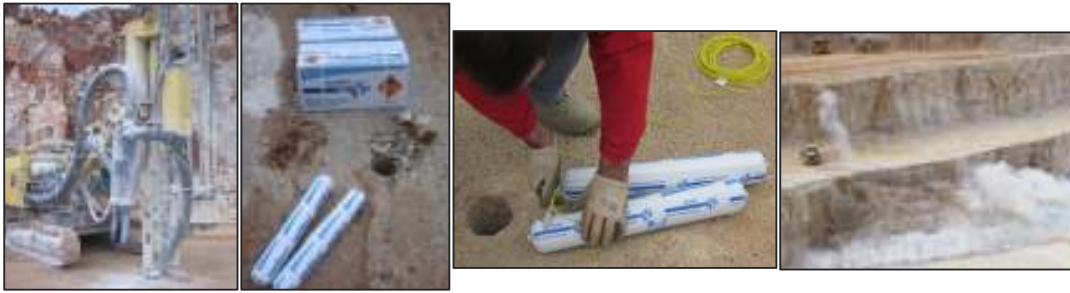
Figura 3. Perfuração, distribuição, carregamento de explosivos e acionamento
