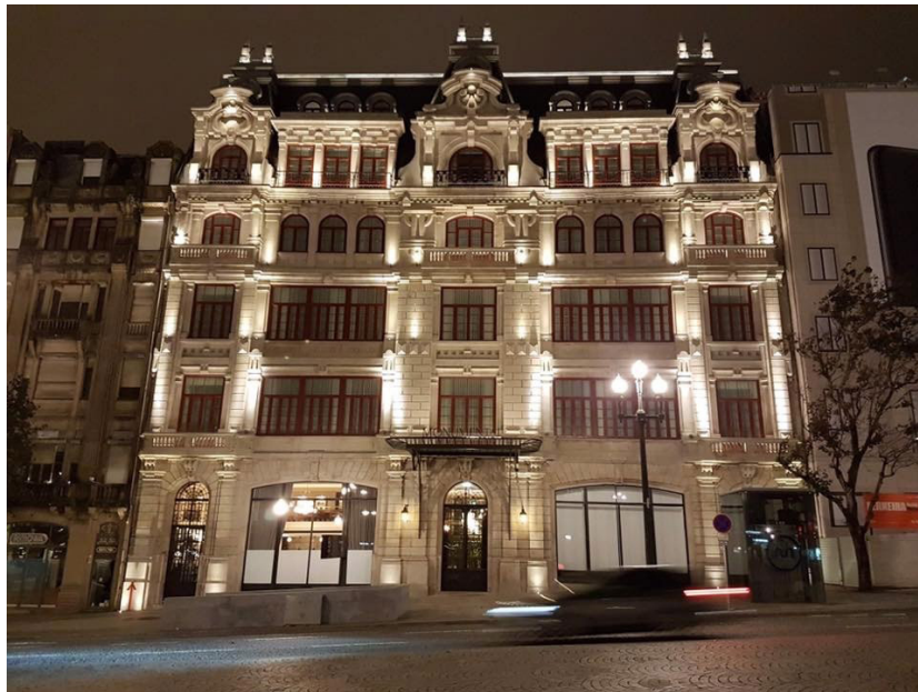
Figura 13 Fachada do hotel Le Monumental Palace
