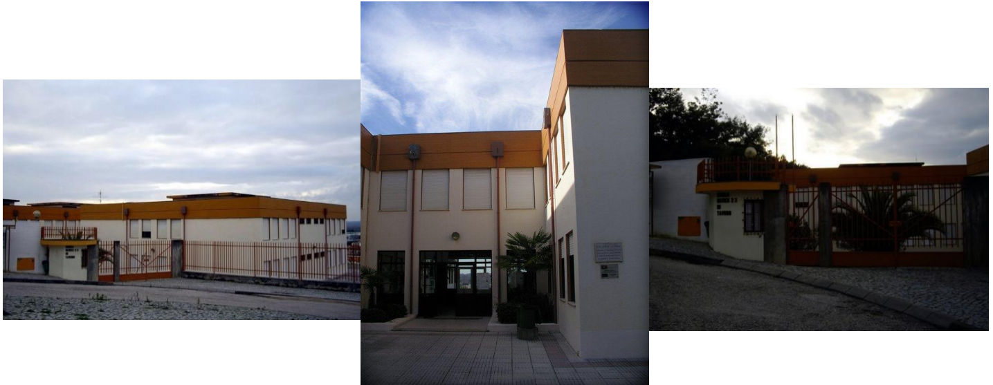
Figura 9, 24 e 25- Entradas da Escola.
