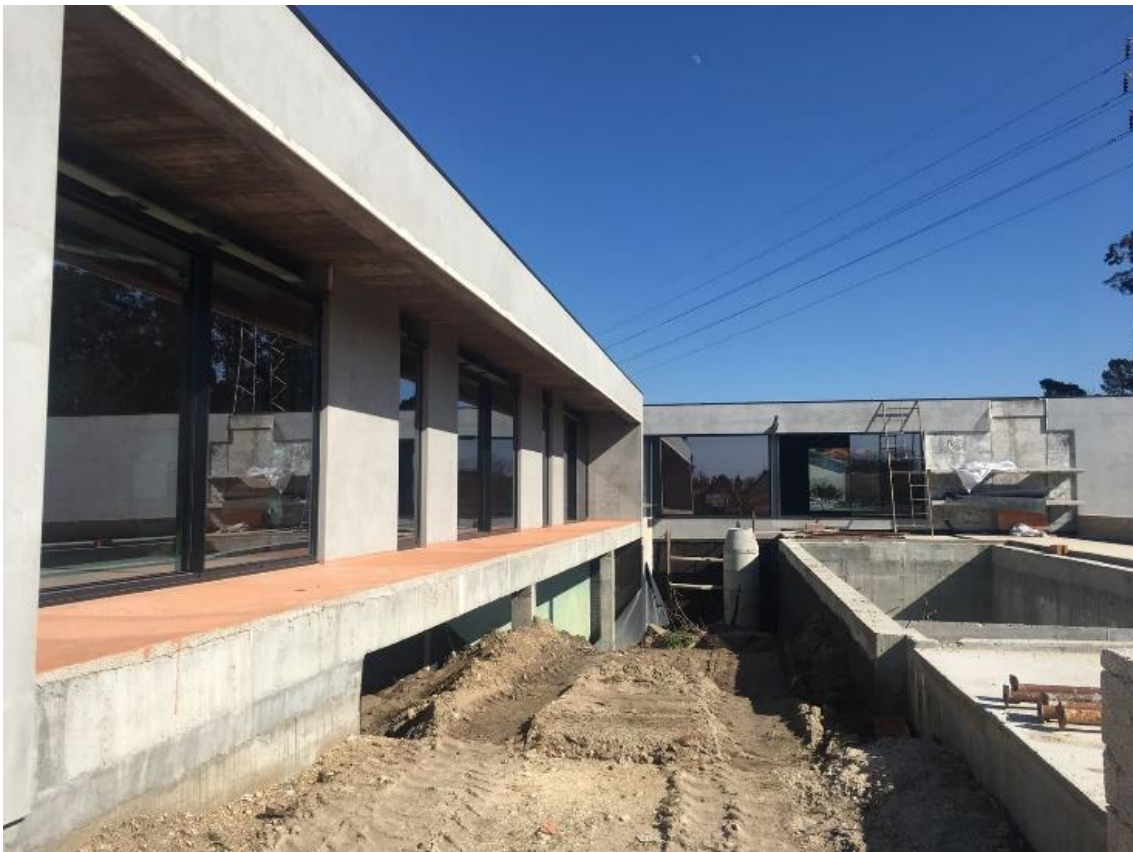
Figura 1.3 - Caixilharia de Alumínio
