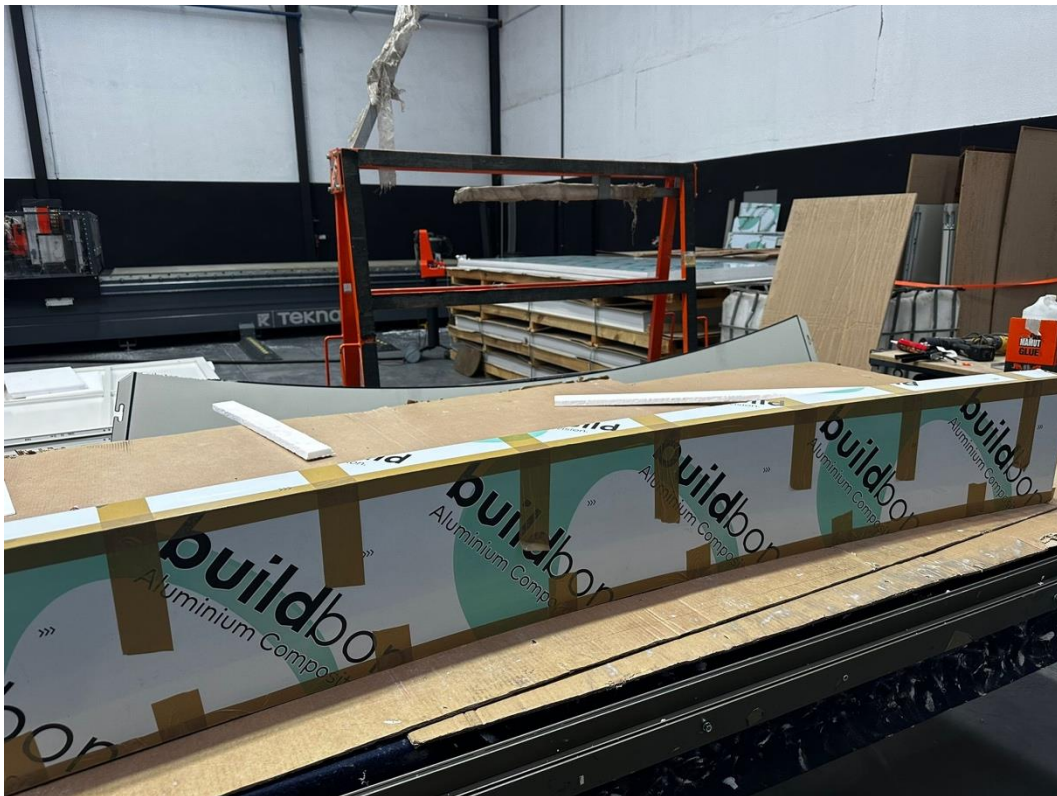
Figura 4.3 - Assemblagem de Painel Compósito de Forma Curva
