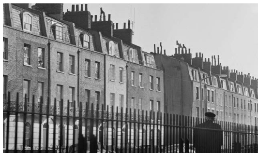
Figura 22 Terraced Houses em Londres, 1960
