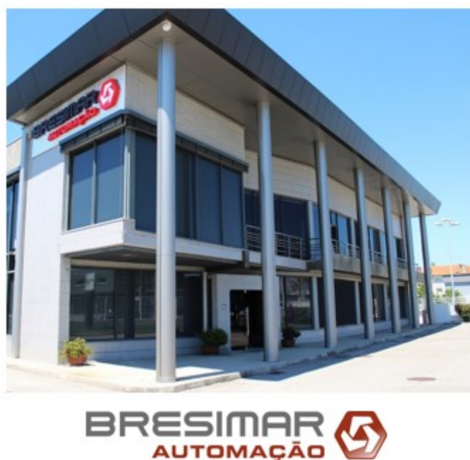
Figura 2 - Vista frontal da Bresimar Automação, S.A 2
