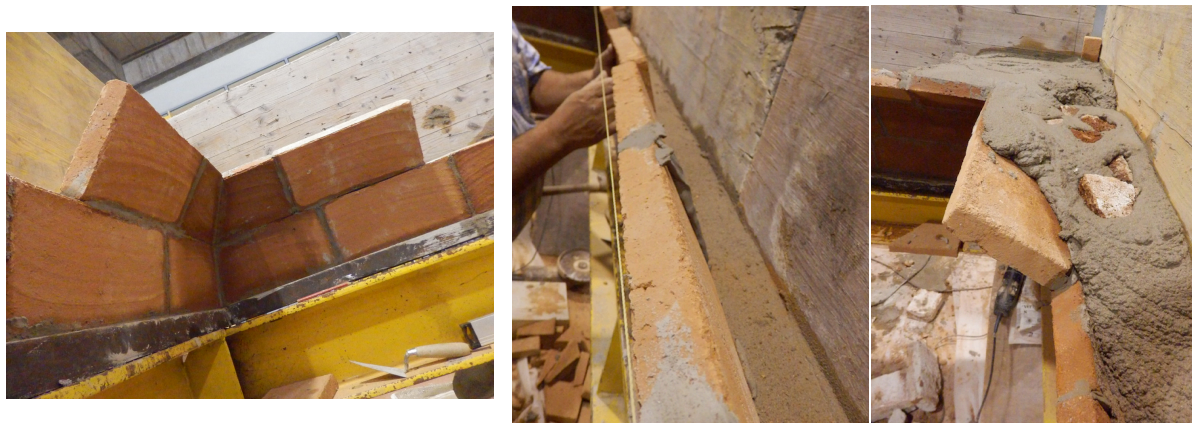
(a) Execução dos cantos
