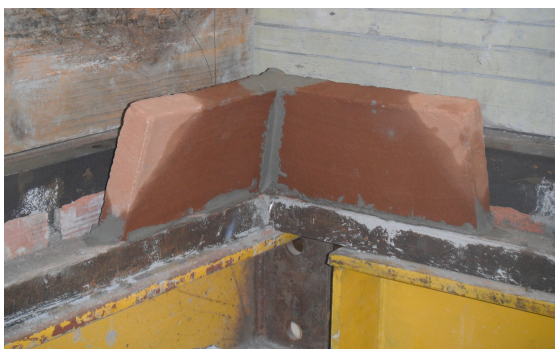
(a) Assentamento dos tijolos de canto
