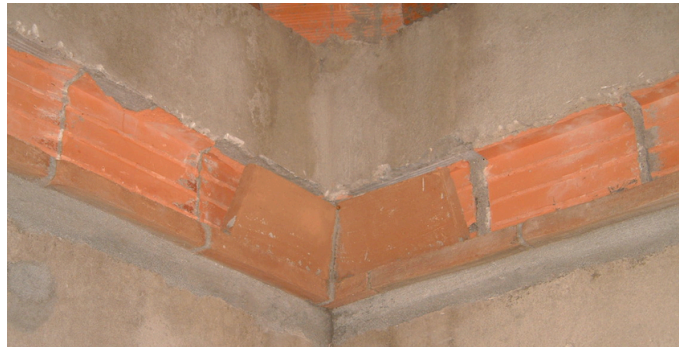
Figura 3.12 – Abertura de roços nas paredes para o apoio da abobadilha
