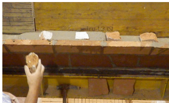
Figura 3.15 – Execução do enchimento do extradorso da abobadilha
