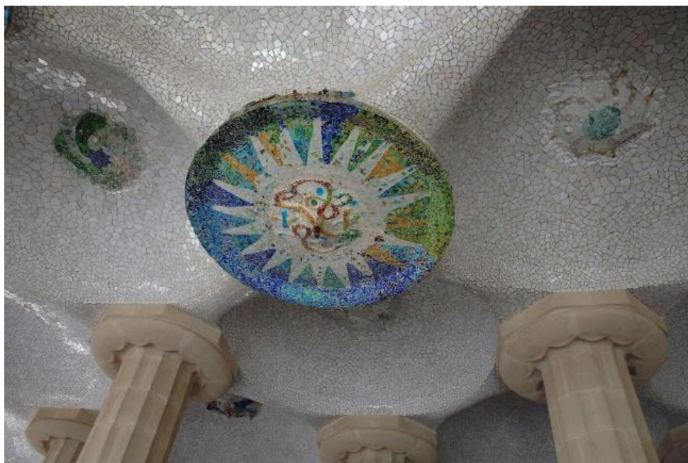
Fig. 39 - Detalhe de elemento interior revestido com cerâmica
