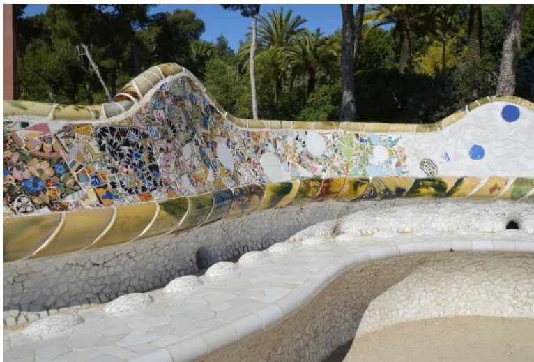
Fig. 38 - Detalhe de elemento de banco revestido com a técnica “trencadis”.
