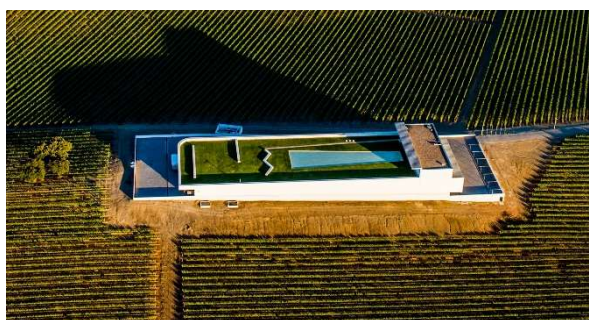
Figura 1. Adega Mayor - Arquiteto Álvaro Siza Vieira
