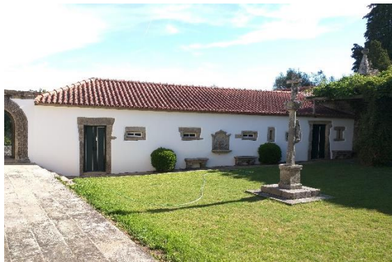
Vista Sul do jardim central do Solar
