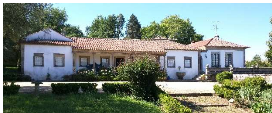
Figura 154. Fachada Norte do Solar Torre das Donas
