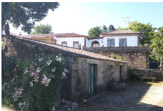
Vista Norte do Solar e edifício anexo
