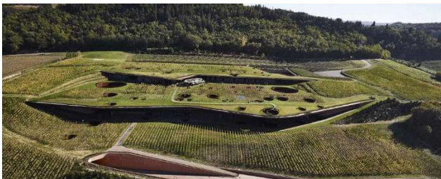
Figura 76. Antinori Winery – Fachada e coberturas
