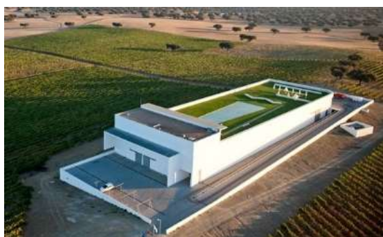
Figura 60. Adega Mayor - Arquiteto Álvaro Siza Vieira
