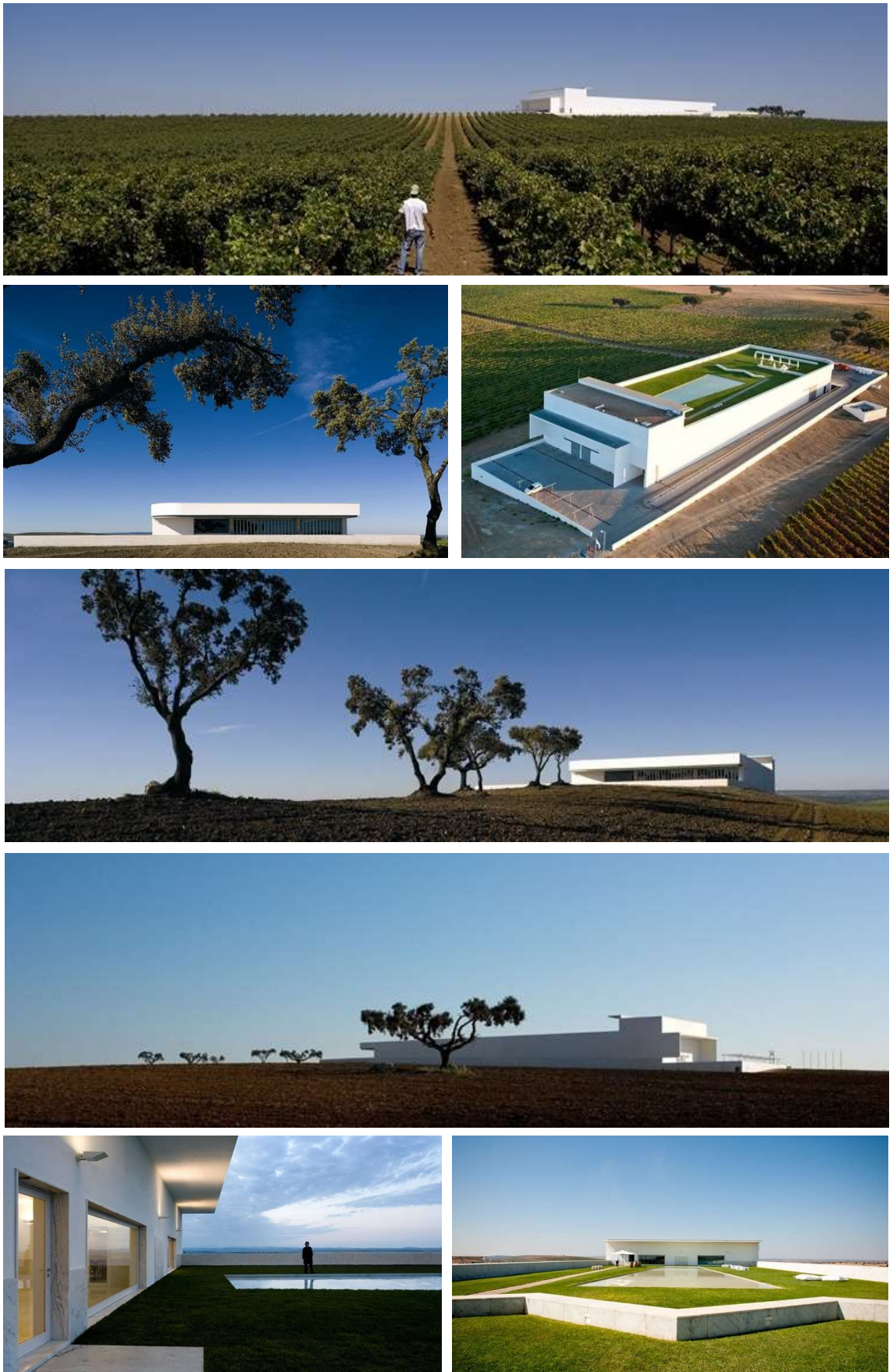
Figura 104. Quadro de Fotografias - Adega Mayor (exteriores)
