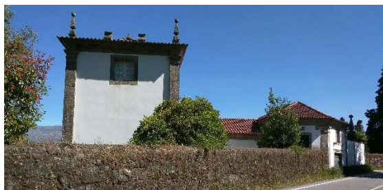
Figura 161. Vista exterior, torre de influência militar e medieval
