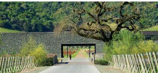
Figura 65. Dominus Winery – Percurso de acesso principal
