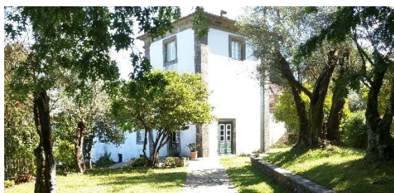
Figura 162. Vista da torre pelo interior do terreno
