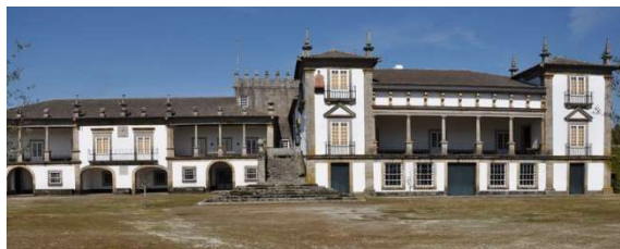
Figura 155. Fachada Sul do Solar de Bertandanos
