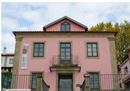
Figura 139. Arquivo Municipal de Ponte de Lima
