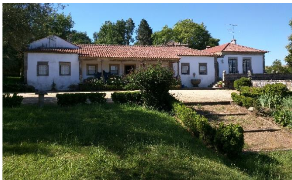
Vista Norte do Solar
