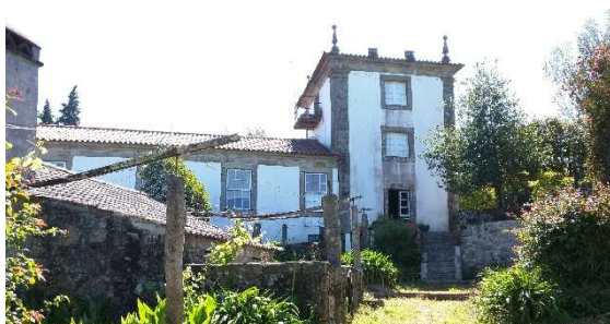
Figura 157. Corpo em "L" do século XVIII adossado à torre
