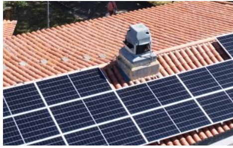
Figura 19 - Painéis solares no bairro de Telheiras em Lisboa, Portugal [34]
