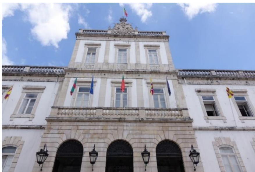
Figura 2 – Edifício da CMC (fotografia do autor)
