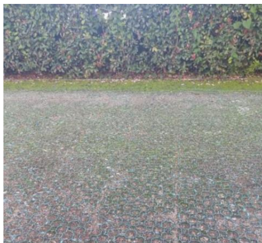
Figura 53 - Pavimento permeável no Burguer King do Vale das Flores (fotografia do autor)
