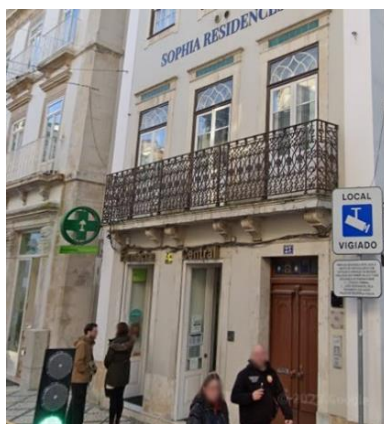
Figura 4 - Edifício do departamento de espaço público da CMC, na rua da Sofia ( Google Maps )
