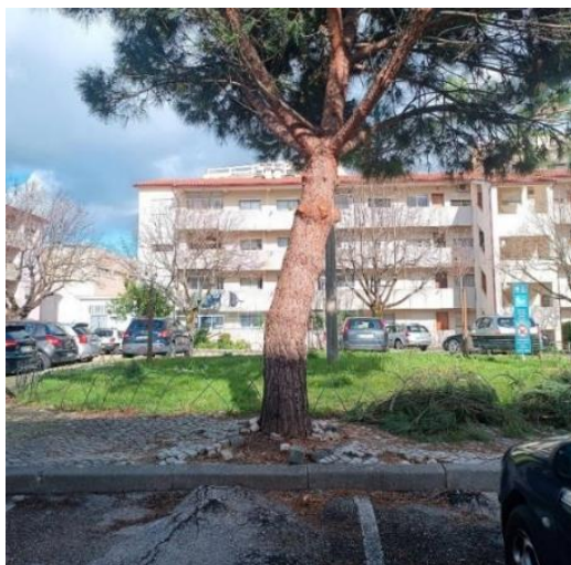
Figura 37 - Estacionamentos danificados no interior do bairro (fotografia do autor)
