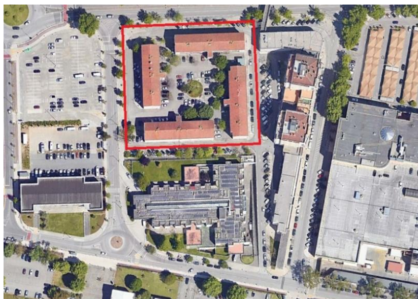
Figura 26 - Vista aérea do bairro do Vale das Flores, com o respetivo contorno a vermelho ( Google Maps )
