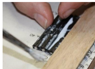
Figura 179 Pormenor da união das faces laterais dos diversos blocos com PVAC. Fonte: el. pr.
