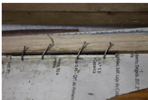
Figura 176 Agrupamento dos diversos fios, de uma forma faseada, realizando o seu aperto com pregos ao longo do seu comprimento. Fonte: el. pr.
