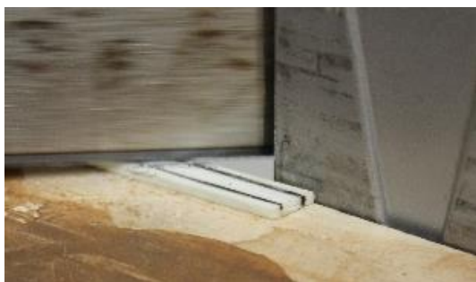
Figura 168 Utilização da serra manual de esquadria, recortando o friso produzido com o ângulo necessário. Fonte: el. pr.
