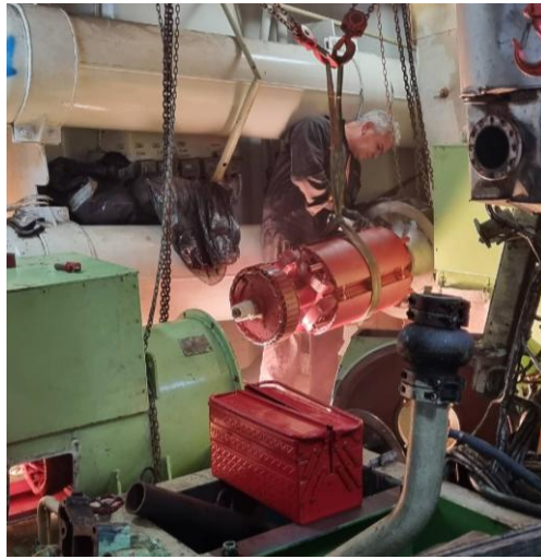
Figura 39- Envernizamento dos elementos dos alternadores.
