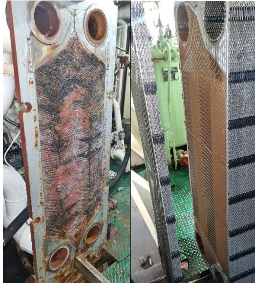
Figura 49- Desmontagem dos permutadores de placas.
