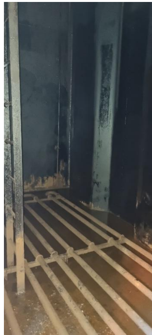
Figura 53- Limpeza de um tanque de combustível com serpentinas de aquecimento.
