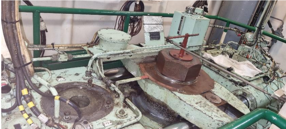
Figura 46- Máquina do leme em processo de manutenção.
