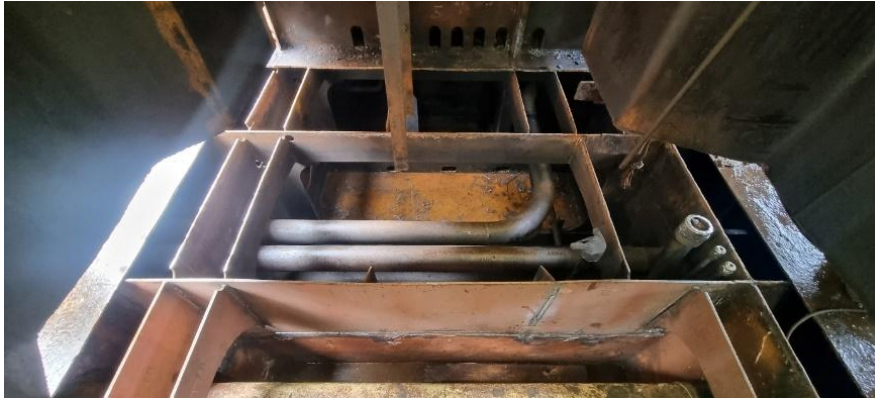
Figura 54- Trabalho de chapa num tanque de combustível.
