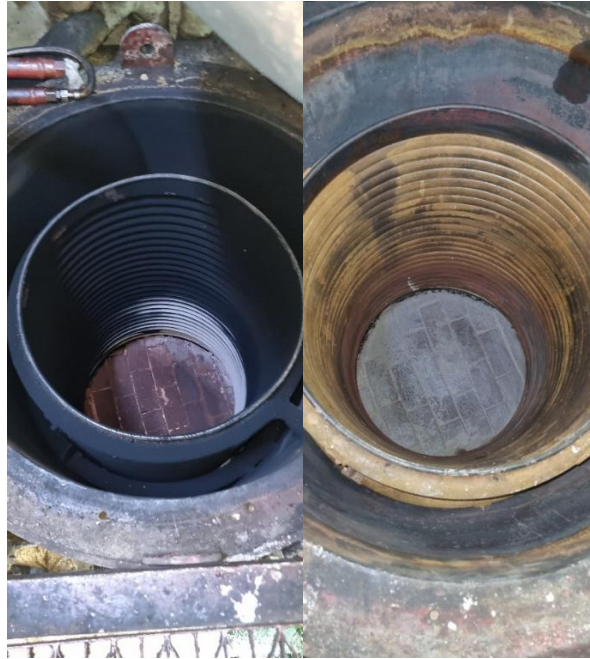
Figura 43- Caldeira auxiliar antes e depois da intervenção de limpeza.
