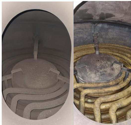
Figura 44- Caldeira recuperativa antes e após intervenção de limpeza.
