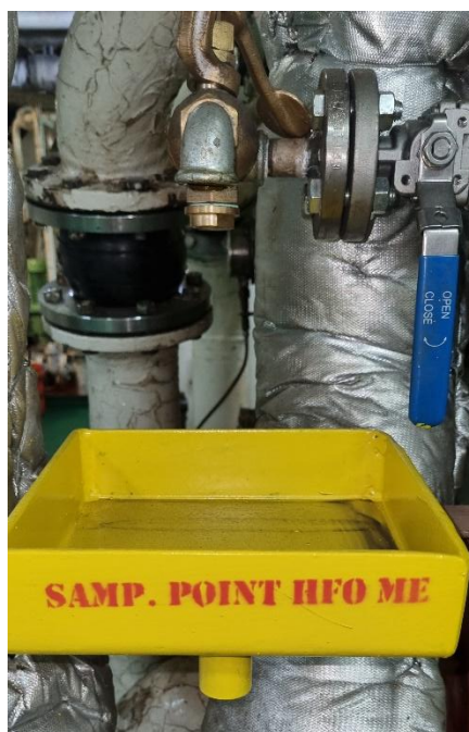
Figura 55- Ponto de recolha de amostra de combustível da máquina principal.
