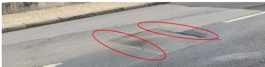
Figura 37 – Cortes na estrada (fotografia da autora)
