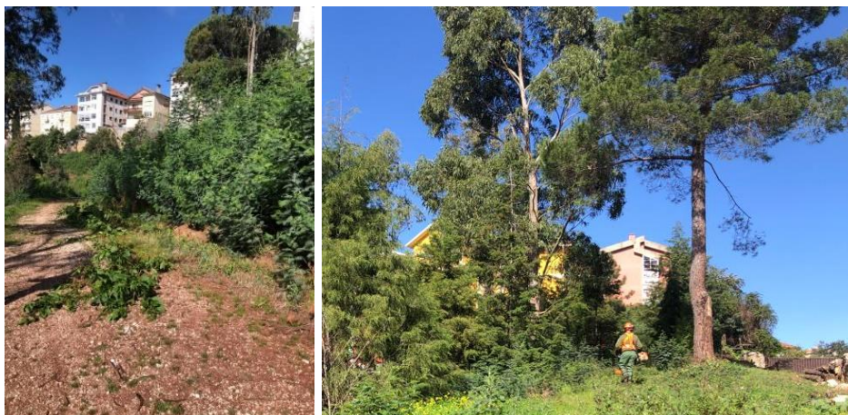
Figura 8 – Limpeza realizadas (fotografia da autora)
