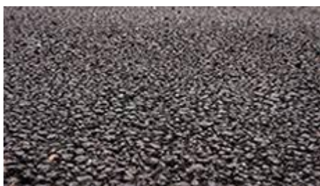
Figura 84 – Pavimento permeável ( https://shre.ink/QiHx )
