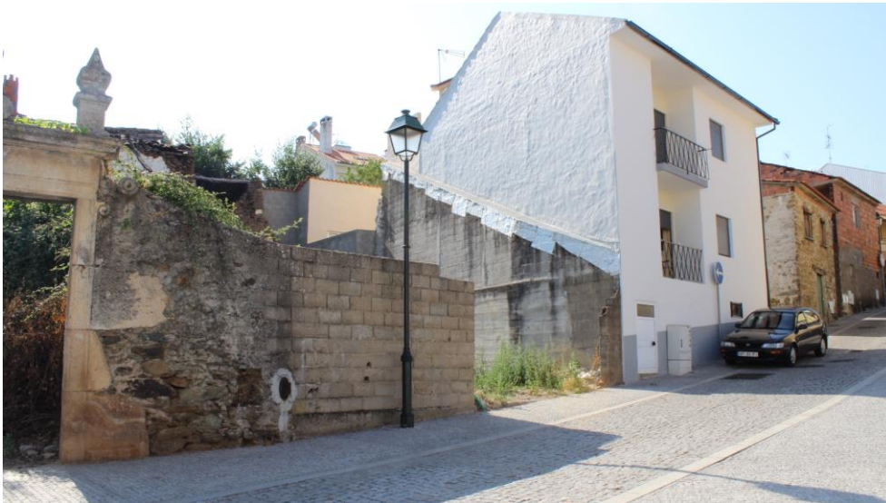
Figura 67. Requalificação dos arruamentos do Prado de Cavaleiros.
