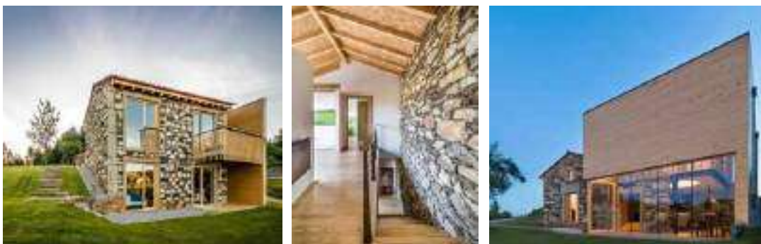
Imagem 47: Conjunto de imagens da habitação. “Quinta do Fortunato”. Reabilitação: Arq. José Luís Veloso, Meixedo, 2016.
