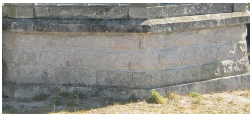
Figura 52 - Base em pedra (coreto 1 – Afife)
