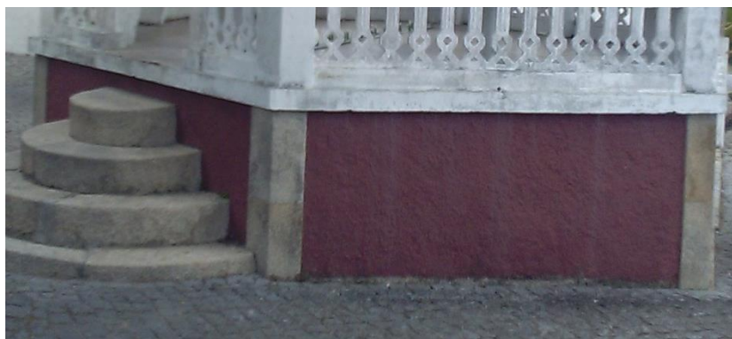
Figura 53 - Base em betão rebocado (coreto 17- Serreleis)
