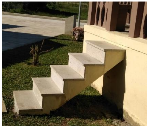
Figura 71 - Escadas em betão (coreto 11-G.L. Santa Maria 2)
