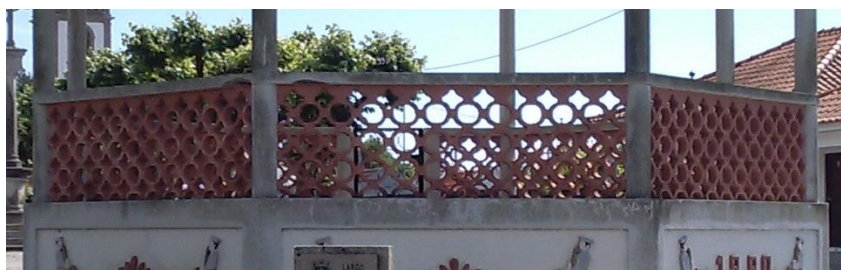
Figura 67 – Guarda/corrimão em cerâmica (coreto 15-Portela Susã)
