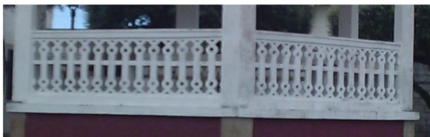
Figura 65 – Guarda/corrimão em betão rebocado (coreto 17-Serreleis)
