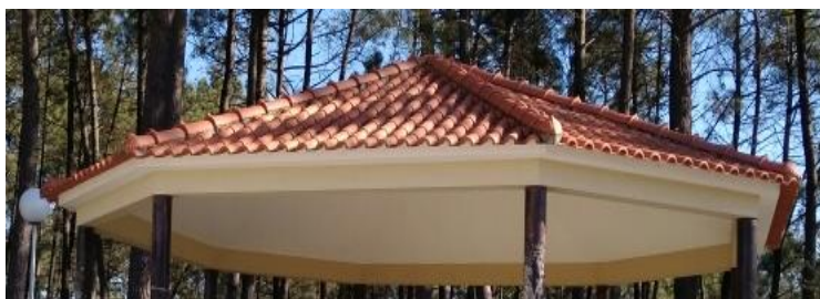
Figura 57 - Cobertura em betão forrado a telha (coreto 10- G.L. Santa Maria)
