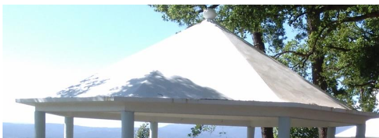
Figura 55 - Cobertura em betão rebocado (coreto 8- G.L. Santa Leocádia)
