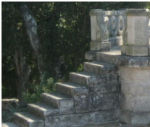
Figura 70 - Escadas em pedra (coreto 1-Afife)
