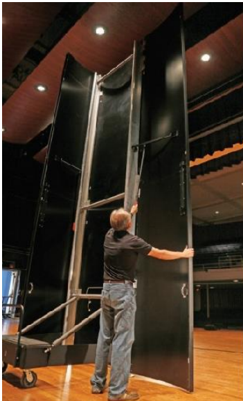
Figura 23 / 24 - Concha acústica de estrutura móvel montada no palco de uma sala de espetáculos ( Fox Cities Performing Arts Center , Appleton, Wisconsin, EUA); fase de montagem (esq.) e aspecto final (dir.).
