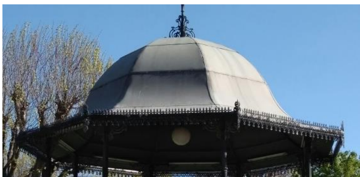
Figura 56 - Cobertura em ferro/chapa (coreto 12- Monserrate)
