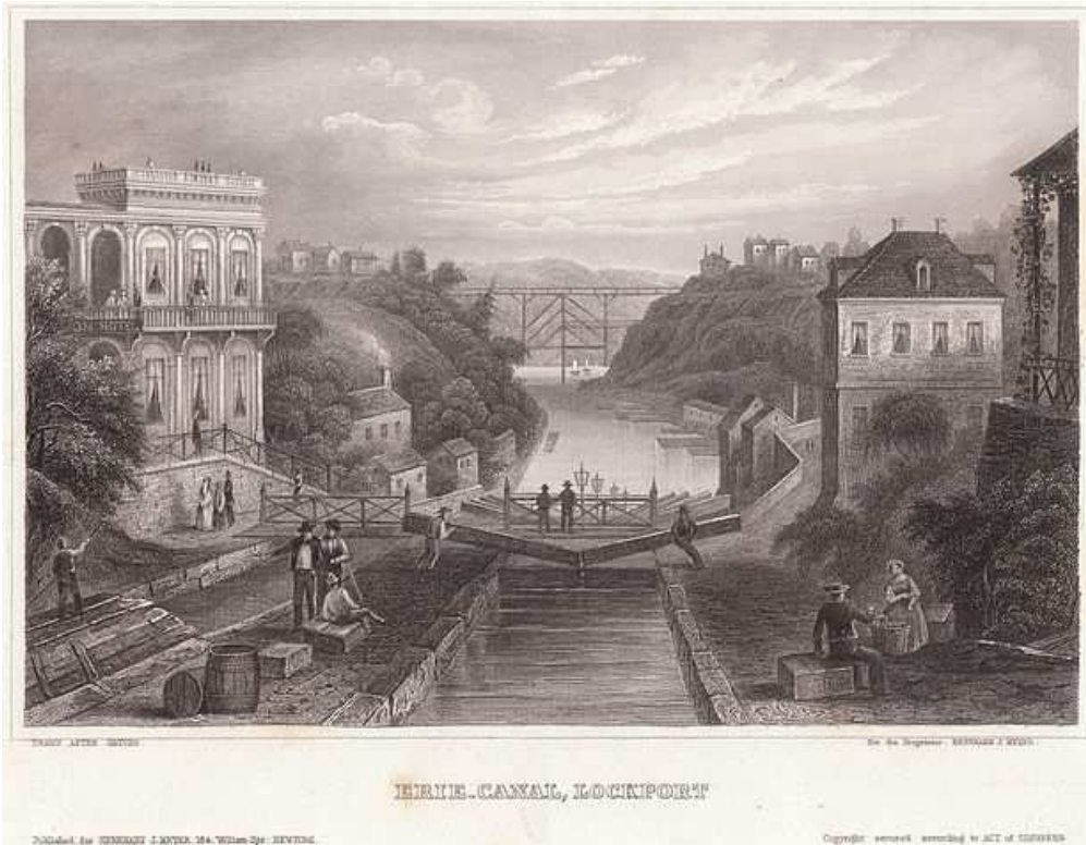
Figura 89 - Construção do Erie Canal
