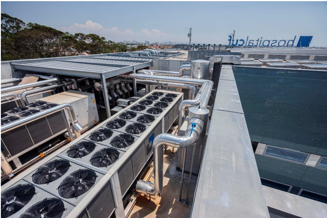
Figura 34 – Cobertura Técnica do Hospital Cuf, Porto - Ventura + Partners - 2010
