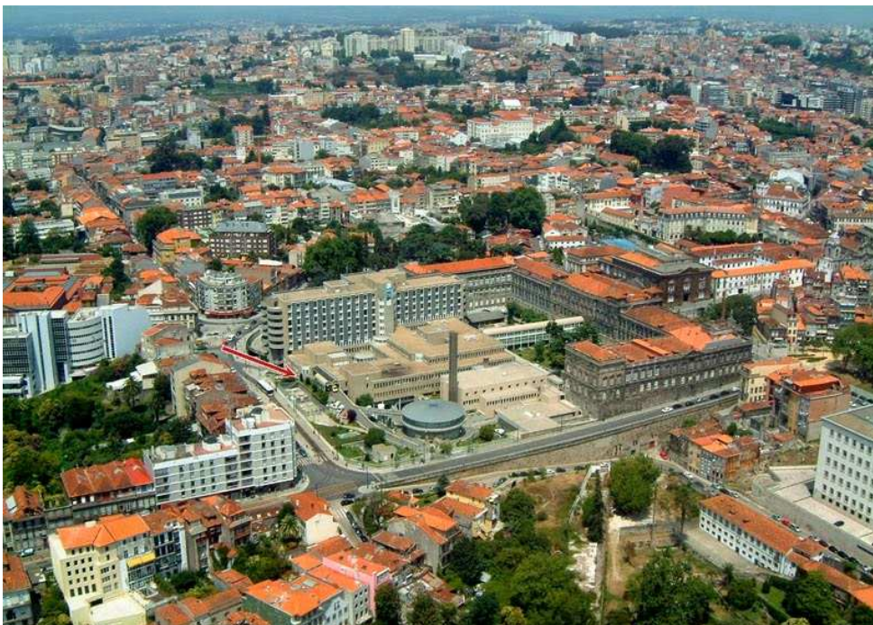
Figura 16 - Hospital de Santo António na actualidade – à direita, o Instituto de Ciências Biomédicas Abel Salazar, o Quartel do Carmo, as Igrejas dos Carmelitas e do Carmo e o Hospital do Carmo.
