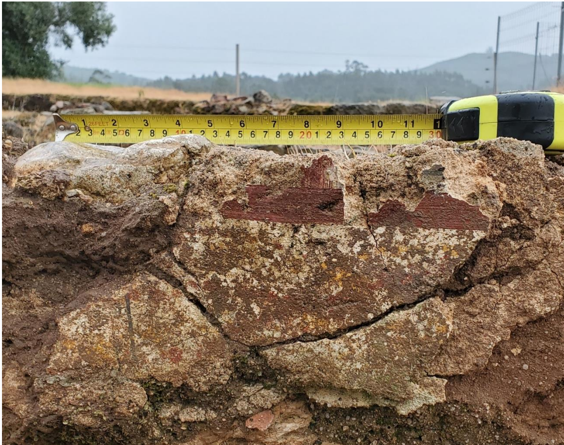
Fig. 37 – Detalhe da Zona Inferior e passagem para a Zona Média da pintura ainda in situ no lado Oeste da CTE, na divisão à direita da cozinha.
