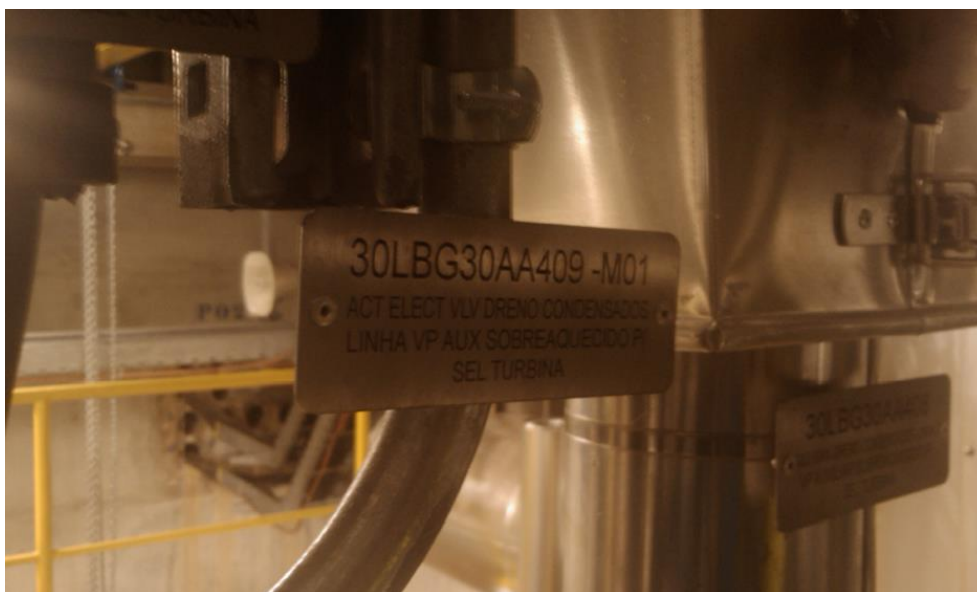
Figura 5 – KKS do Equipamento em chapa rebitada (Fonte própria).
