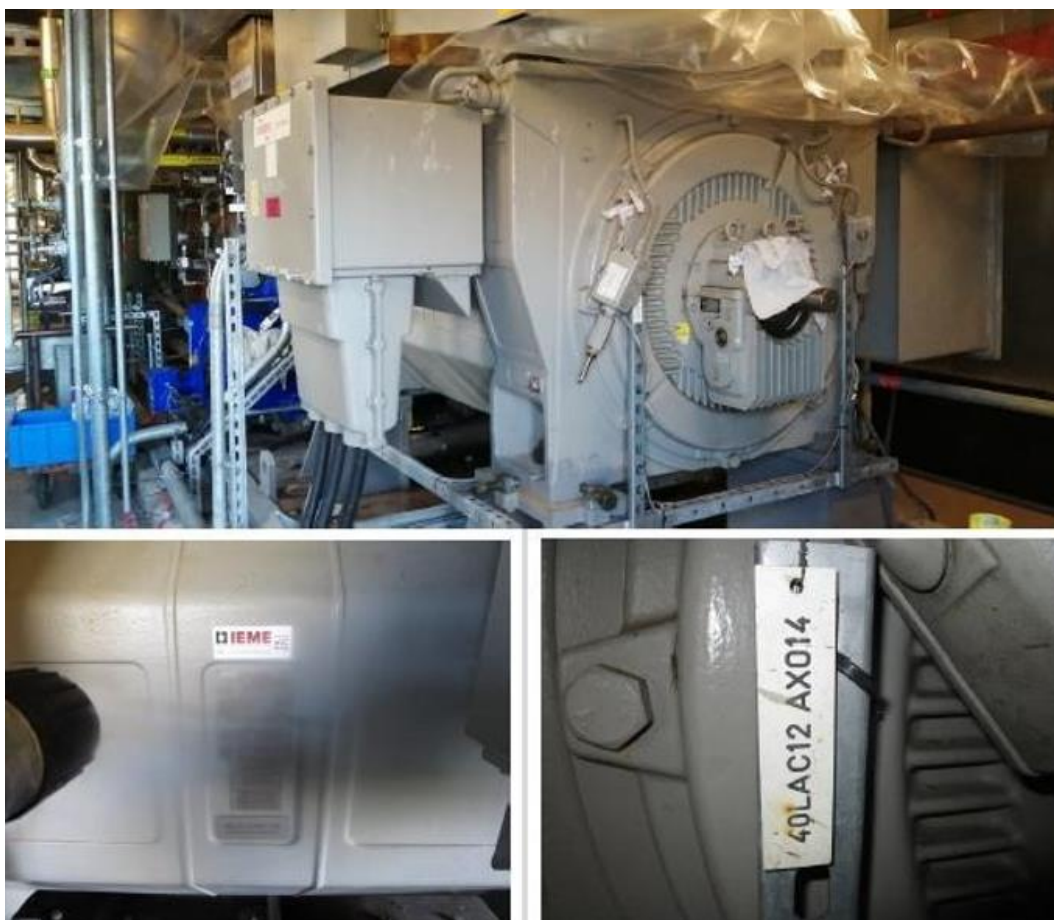
Figura 78 – Inspeção ao motor sem desmontagem.
