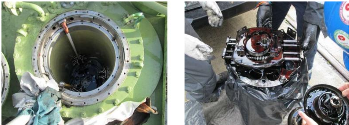
Figura 71 – Trabalhos no ruptor (Fonte própria).
