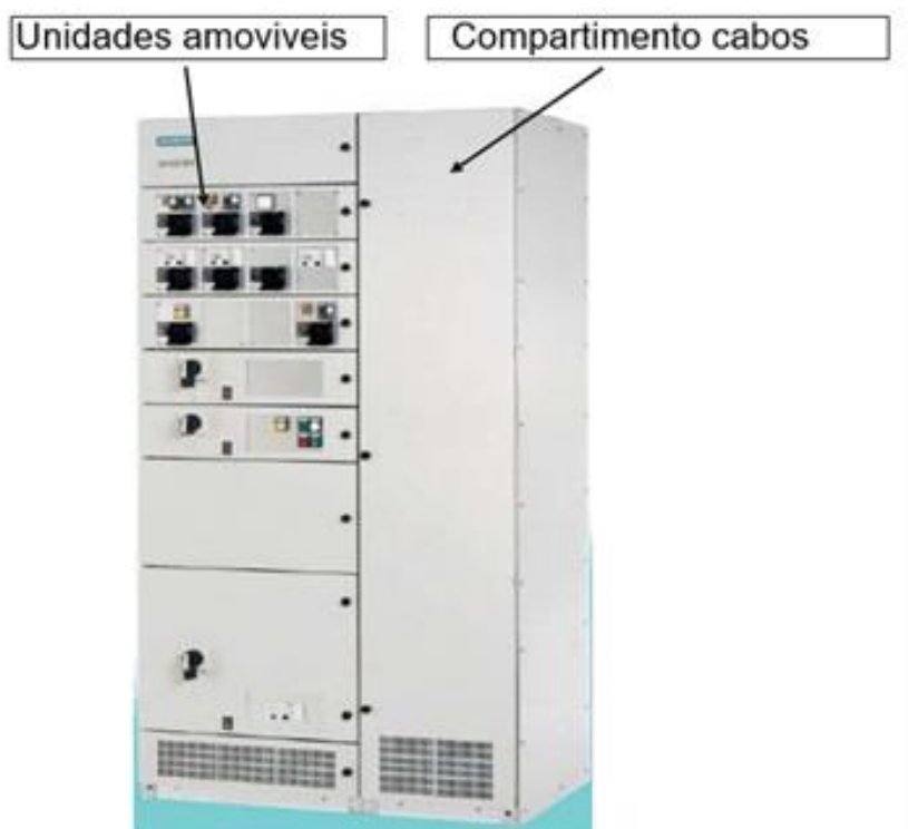
Figura 61 – Constituição quadro BT.
