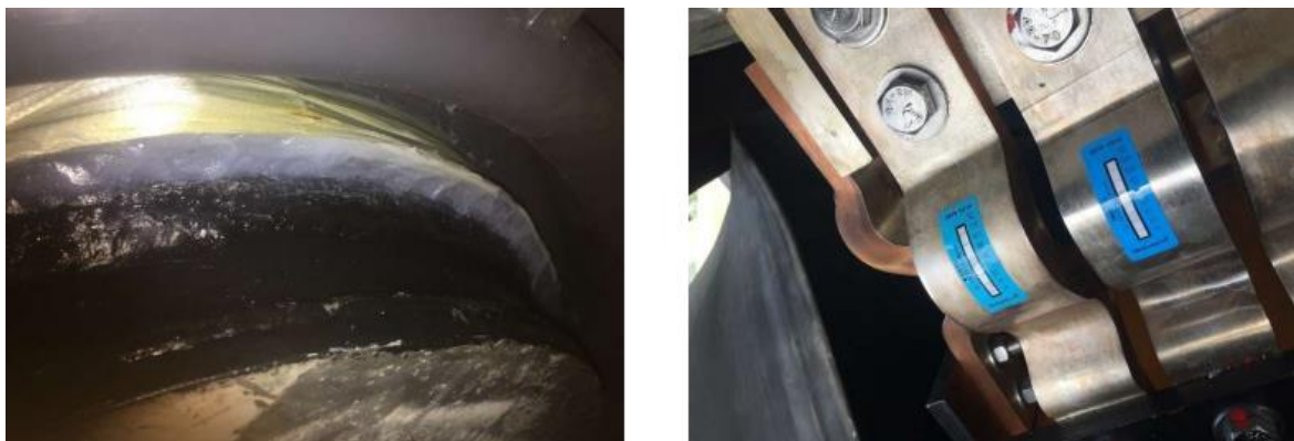
Figura 68 – Vedação com polyglass e silicone e colocação de etiquetas termo sensíveis (Fonte própria).
