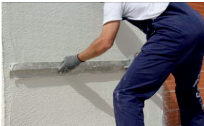
Regularização com régua metálica
