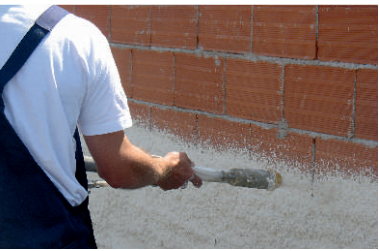
Projecção do reboco ISODUR
