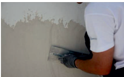
Aplicação de FLEXDUR sobre o suporte de ISODUR
