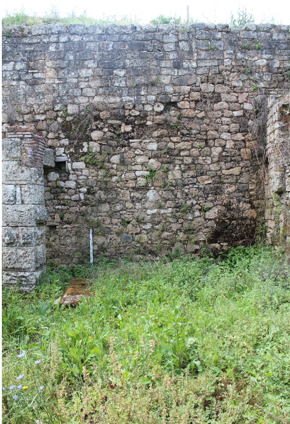
Fig.34 – Vue du mur 1008 (moitié sud-ouest) (F. Ferreira 2021)
