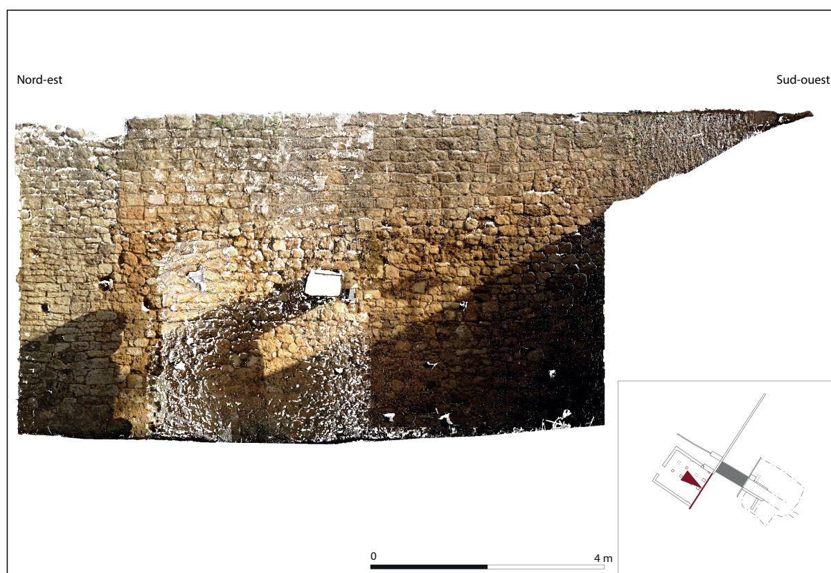
Fig.31 – Mur 1008 – Parement nord-est/sud-ouest (F. Ferreira 2022)
