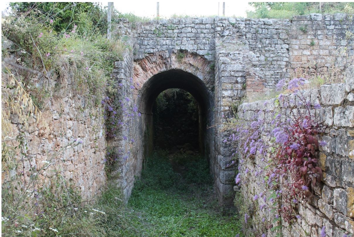
Fig.55 – Débouché du passage sous le viaduc, à gauche vue du mur 1019 faisant face au mur 1009, à droite (F. Ferreira 2021)
