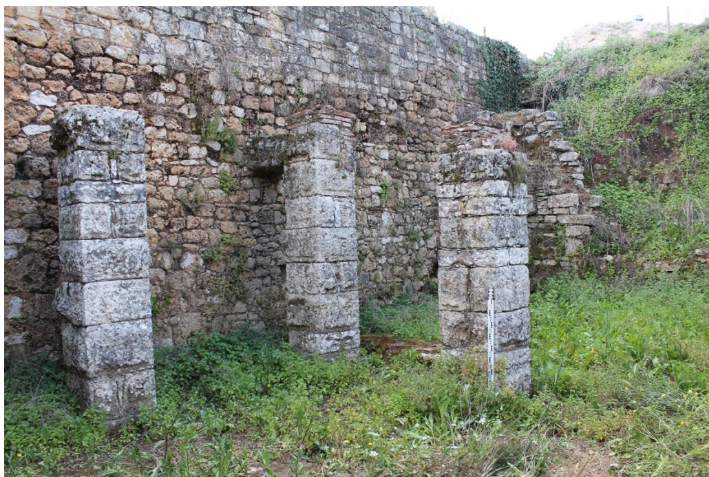
Fig. 50 – Vue de trois des piliers de la deuxième galerie – on remarque que les deux piliers de droite présentent des départs d'arcs différents (F. Ferreira 2021)
