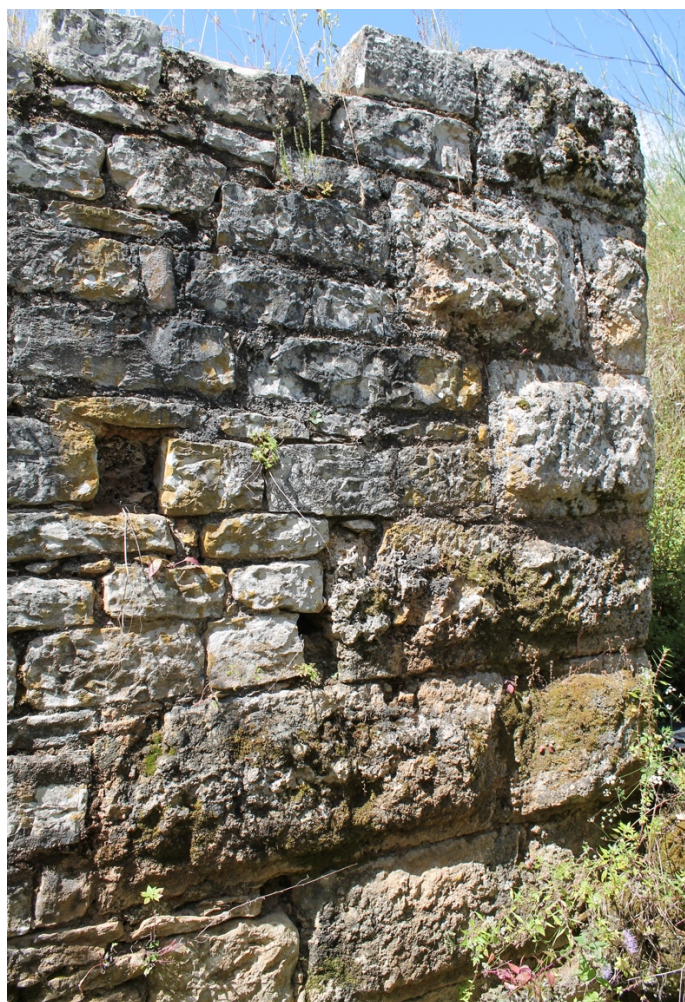
Fig. 36 – Extrémité nord-ouest du mur 1009 – trou de boudin et appareil à bossage (F. Ferreira 2021)
