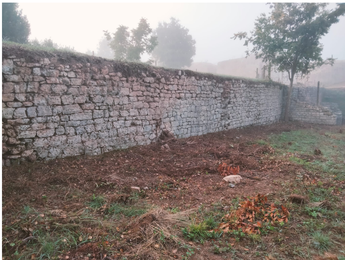
Fig. 58 – Vue du mur 1020 après nettoyage (R. Costeira da Silva 2022)
