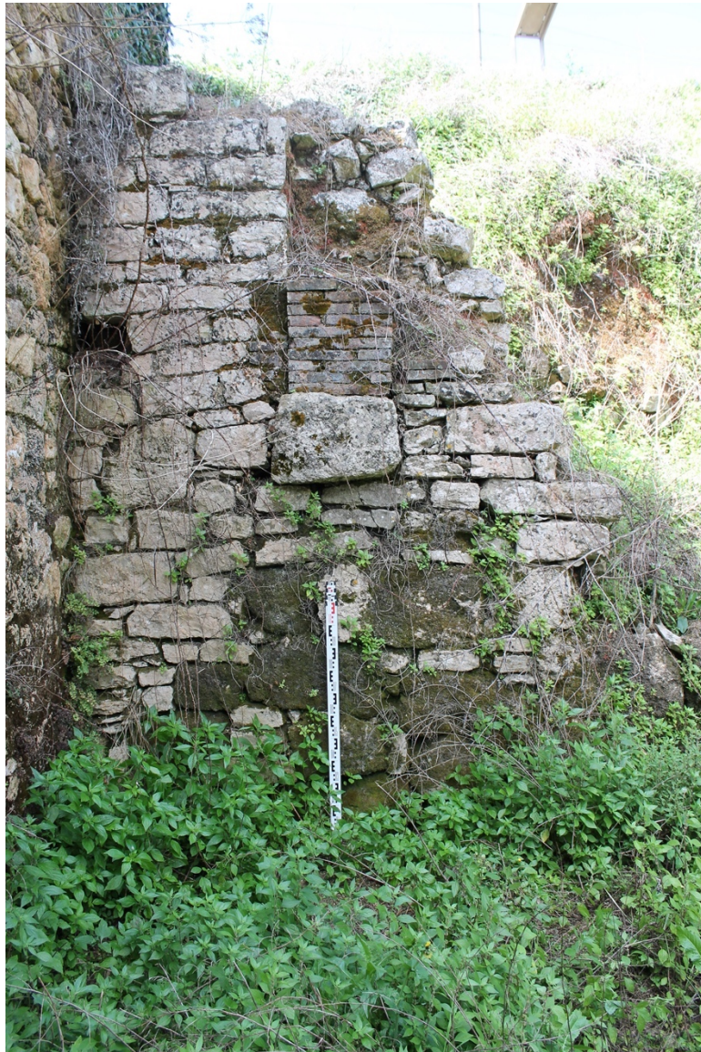
Fig. 54 – Mur 1018 – Bloc (1018-02) et départ d’arc (1018-03) (F. Ferreira 2021)
