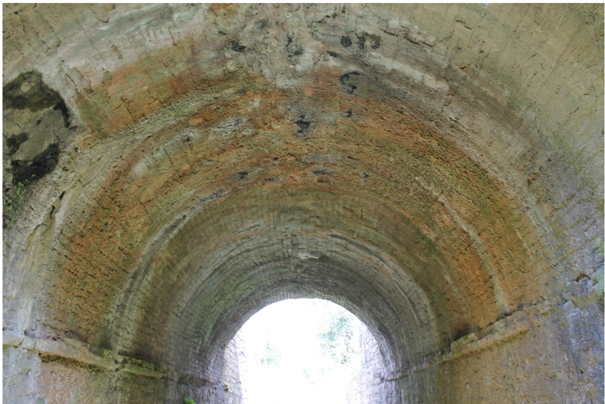
Fig. 26 – Vue du ressaut de briques marquant la naissance de la voûte (F. Ferreira 2021)
