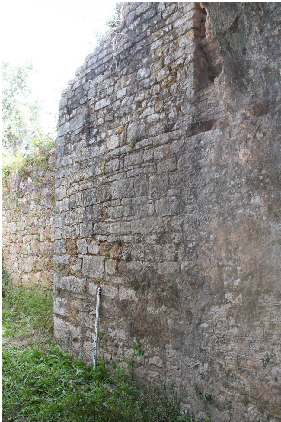
Fig. 59 – Vue du mur 1021 – à droite détail du revêtement et des joints tirés au fer (F. Ferreira 2021)
