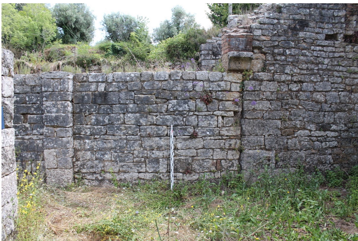
Fig. 42 – Vue du panneau est du mur 1009 (1009-02), du mur de refend (1009-03), du départ d'arc (1009-04), à l'extrême droite, le mur 1022 (F. Ferreira 2021)
