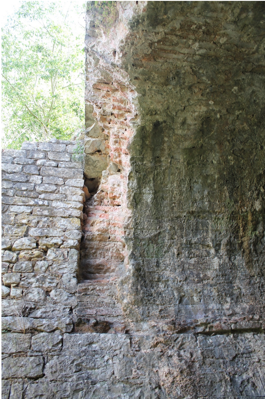
Fig.60 – Détail de la jonction entre le mur 1006 et la voûte du viaduc (à droite) et 1021 (à gauche) (F. Ferreira 2021)
