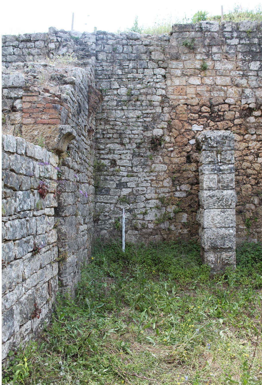
Fig. 35 – Vue de l'angle entre 1022 et 1008 à gauche deux départs d'arcs en plein cintre (F. Ferreira 2021)
