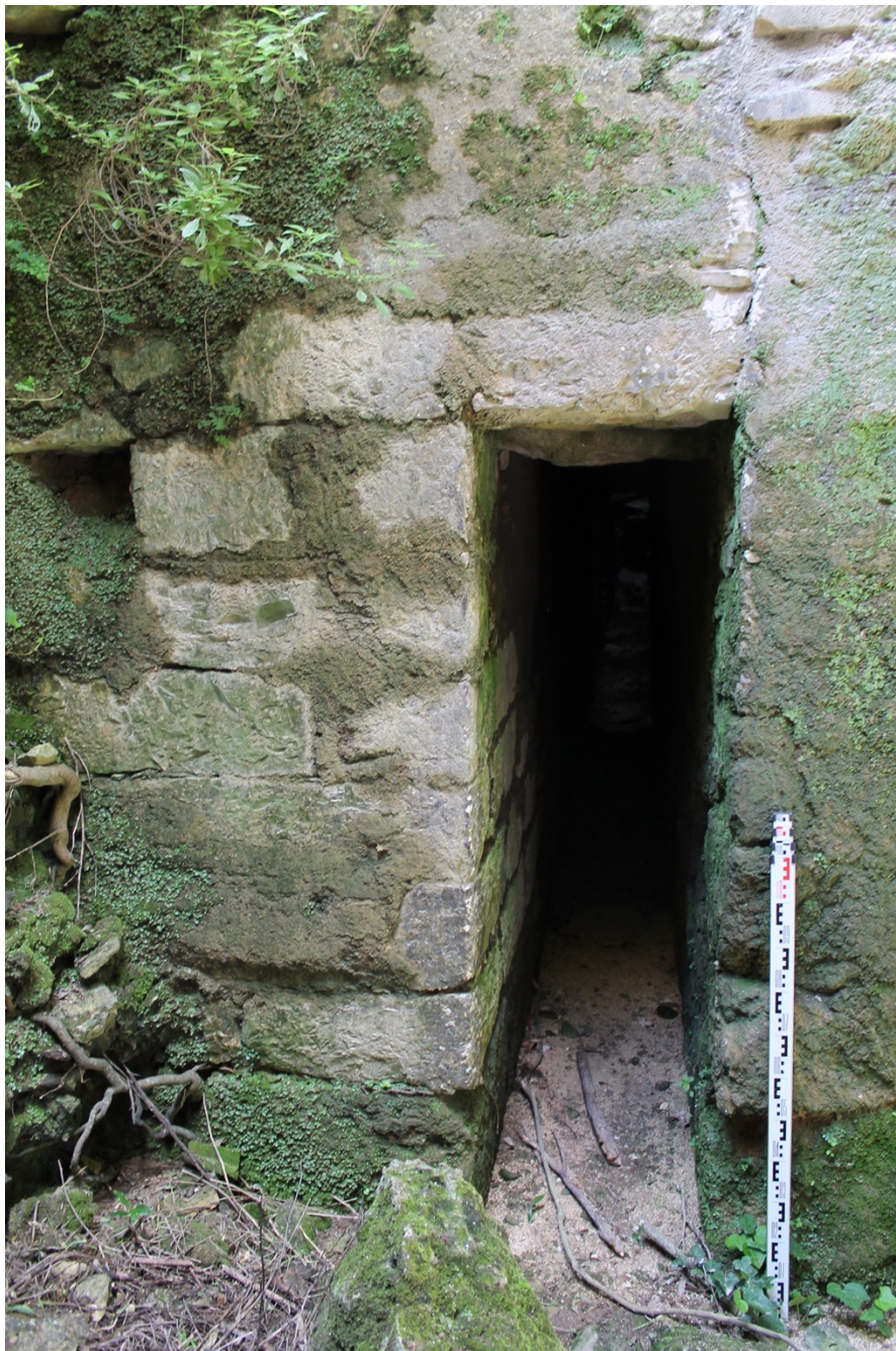
Fig. 18 – Vue de la porte d'accès au moulin hydraulique (1002-04) (F. Ferreira 2021)
