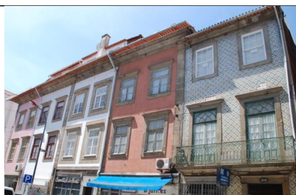
Fig. 46 – Enquadramento da fachada
