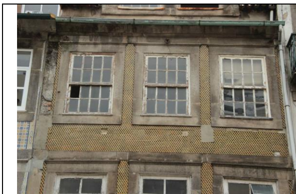
Fig. 28 Fachada antes da intervenção
