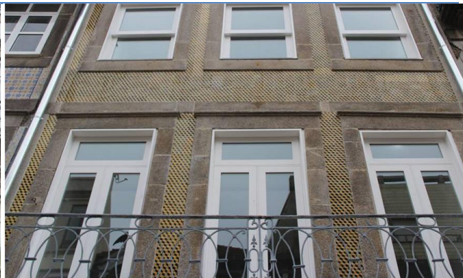
Ilustração 34 Fachada depois da intervenção
