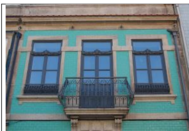
Fig. 5- Fachada depois da intervenção
