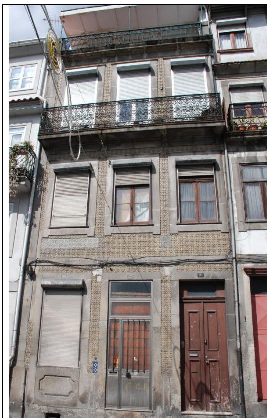
Fig. 39 Vista geral da fachada
