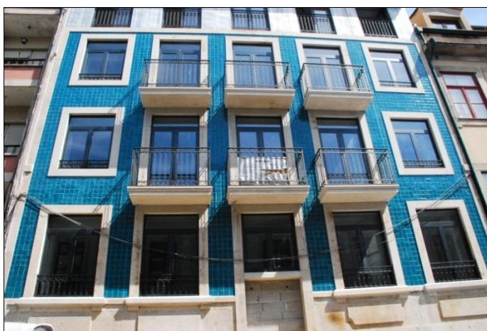
Fig. 17 Fachada depois da intervenção
