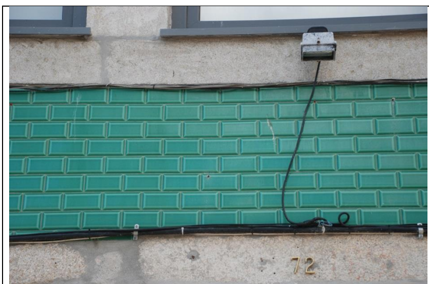
Fig. 53 - Fachada depois da intervenção
