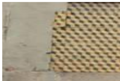
Fig. 29 – Preenchimentos de cimento
