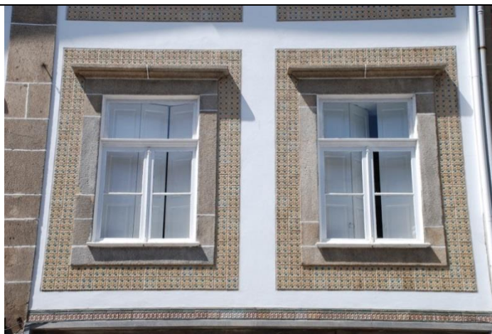
Fig. 44 – Vista de pormenor da fachada depois da intervenção
