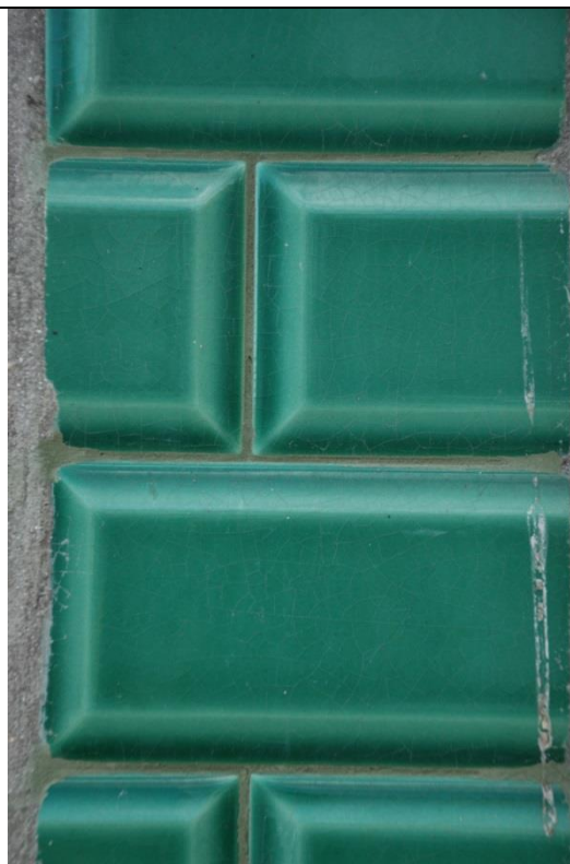
Fig. 52 - Fachada depois da intervenção
