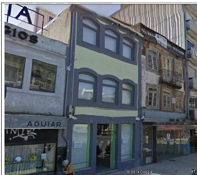
Fig. 50 - Fotografia do edifício antes da intervenção
