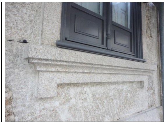
Fig.- 3 Camadas de assentamento removidas
