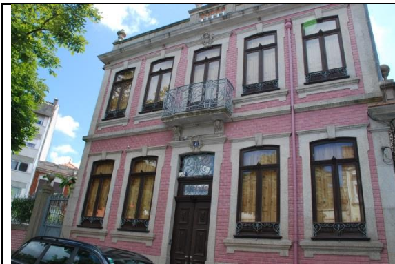
Fig. 46 – Vista geral da fachada
