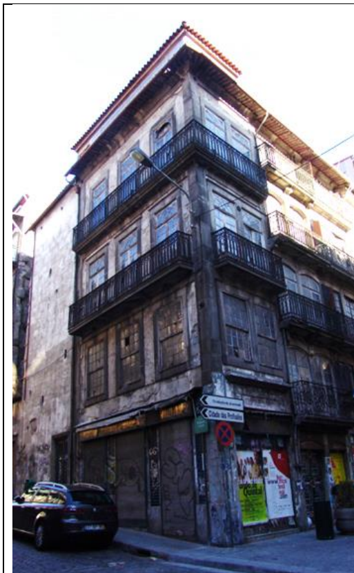
Fig. 7 Fachada antes da intervenção
