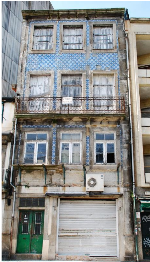
Fig.11- Fachada antes da intervenção
