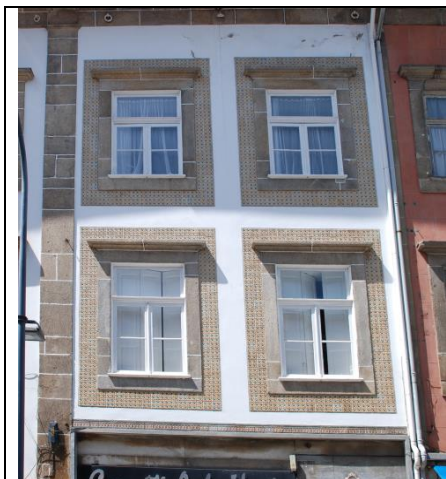
Fig. 43 – Vista geral da fachada depois da intervenção
