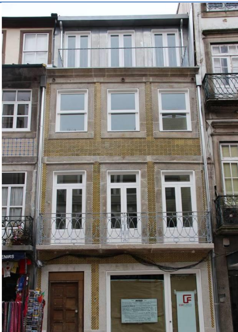
Ilustração 33 Fachada depois da intervenção
