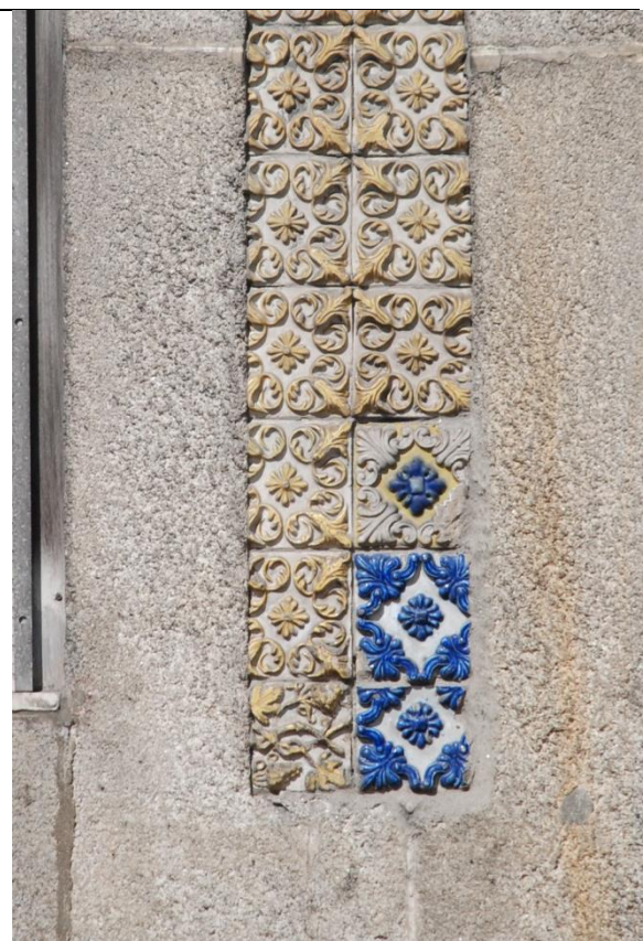
Fig. 40 Vista de pormenor da intervenção realizada.
