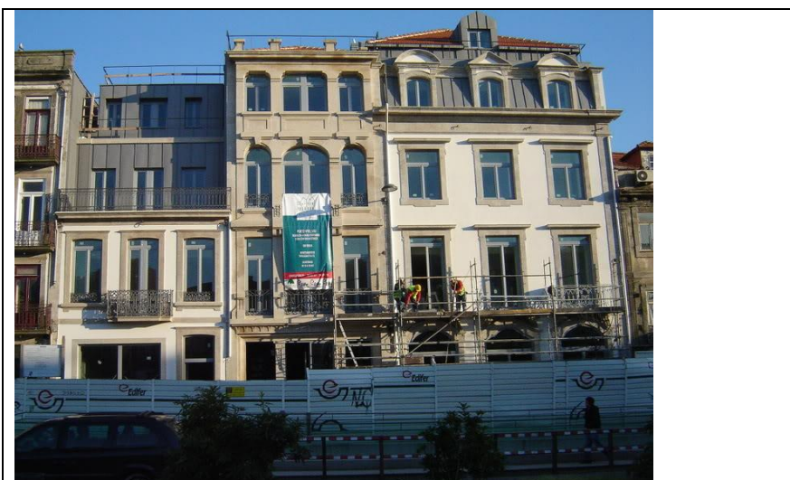
Fig. 49 – Fachada depois da intervenção
