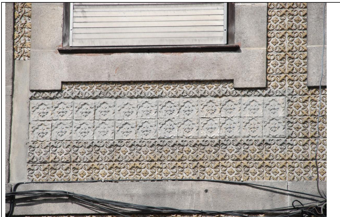
Fig. 41- Vista de pormenor da intervenção
