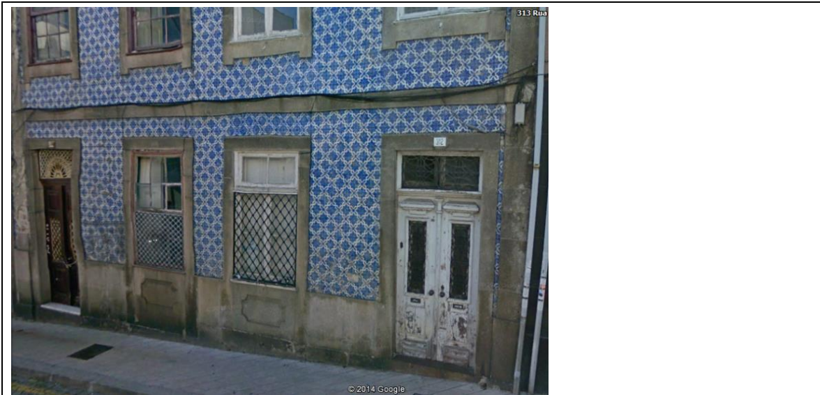
Fig.22 – Fachada antes da intervenção
