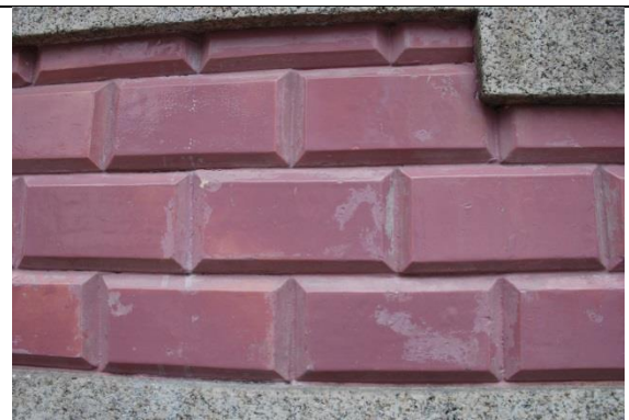
Fig. 47 – Vista de pormenor da intervenção
