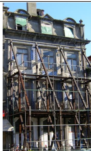
Fig. 48 – Fachada antes da intervenção
