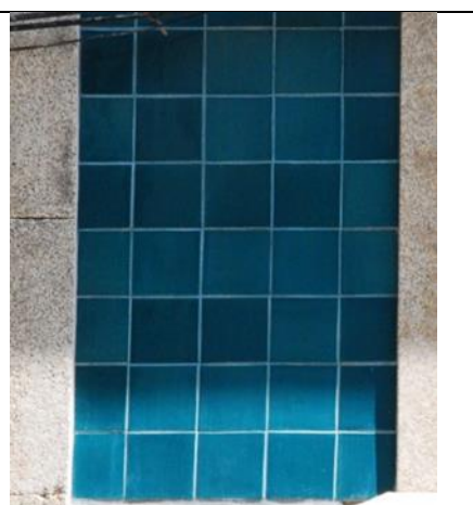
Fig.18 Pormenor azulejos de substituição
