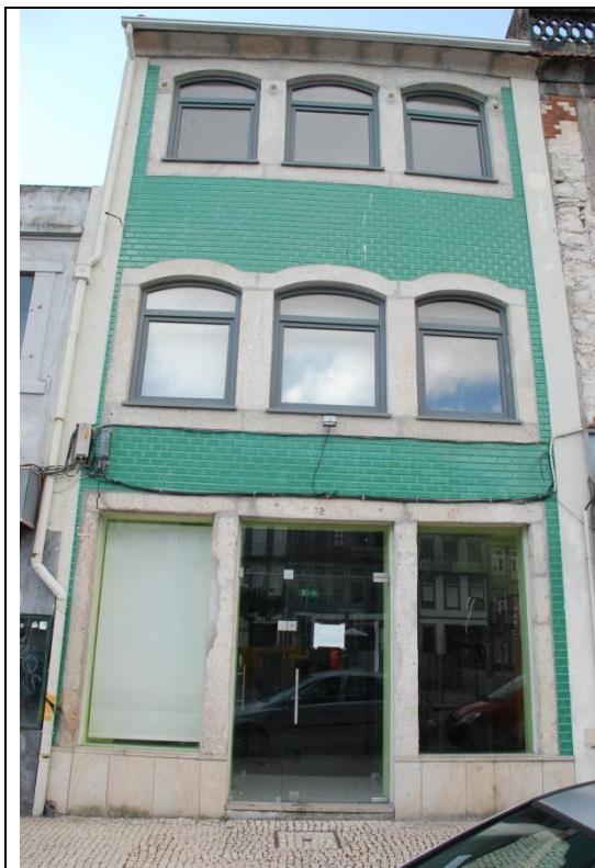
Fig. 51 - Fachada depois da intervenção
