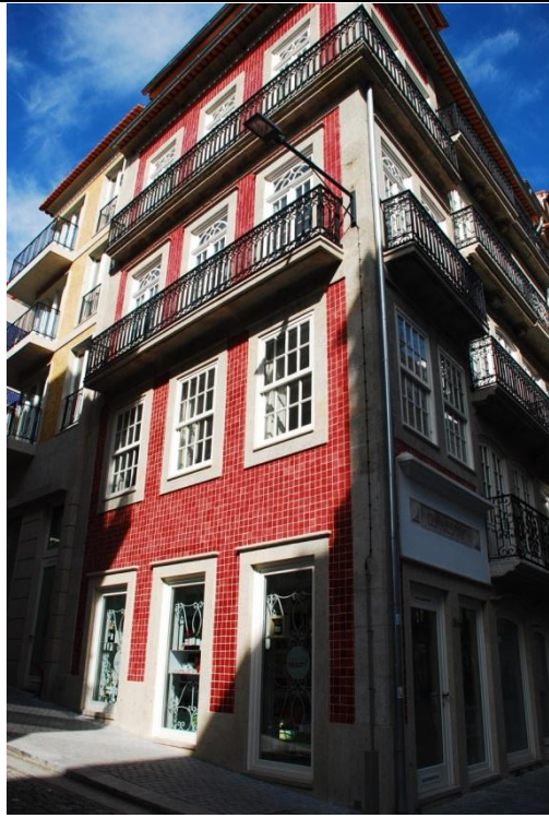
Fig.9 -Fachada depois da intervenção vista geral
