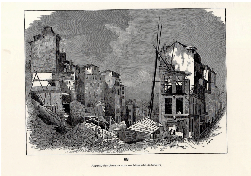
Figura 2: Demolições para construção da Rua Mouzinho da Silveira.
