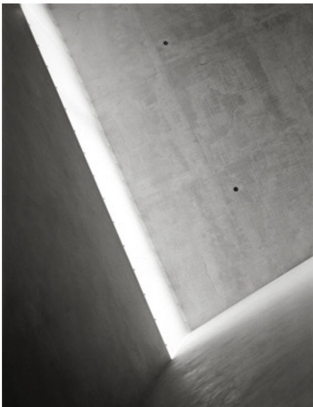
Figura 50: Pormenor da janela de uma das salas torre. Fonte: kolumba.de
