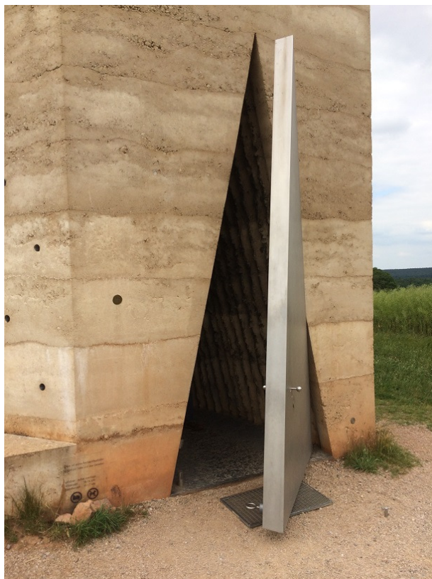
Figura 61: Porta de acesso à capela. Fotografia do autor.
