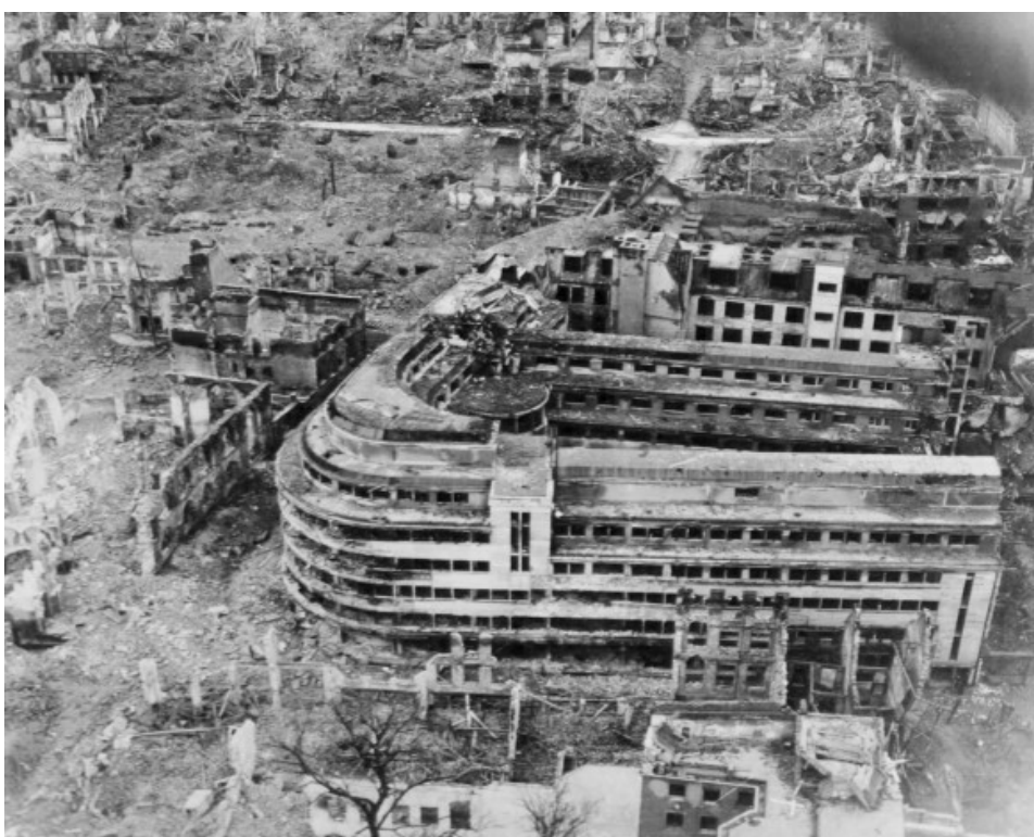
Figura 12: Vista aérea do lote da igreja de Sta. Kolumba após a Segunda Guerra Mundial (do lado esquerdo da fotografia). Fonte: 4.bp.blogspot.com
