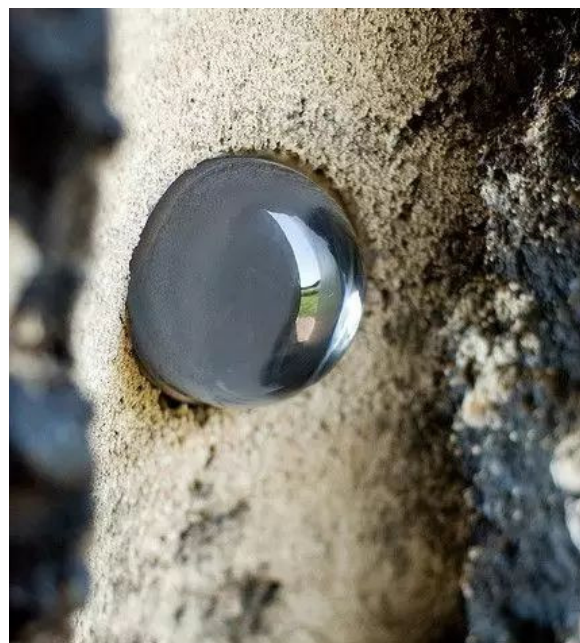
Figura 69: Detalhe das esferas que provocam o efeito luminoso no interior.
