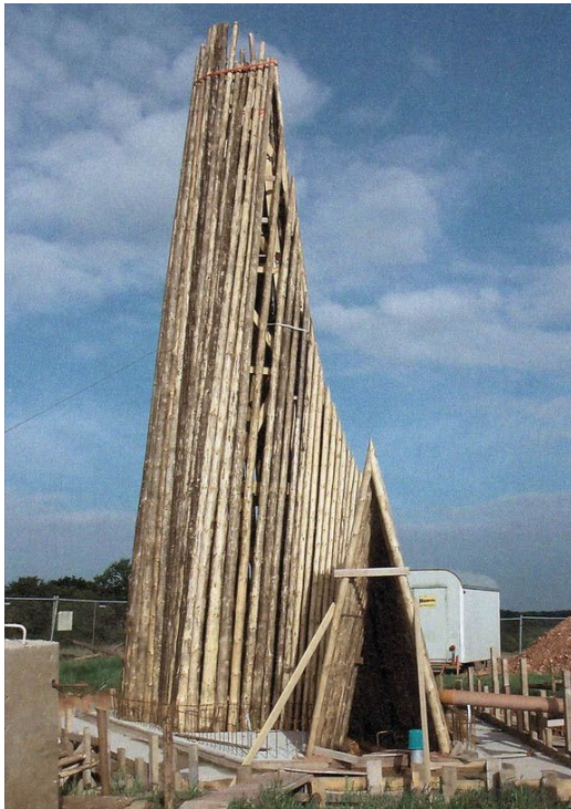
Figura 58: Fase de elaboração da estrutura em troncos.
