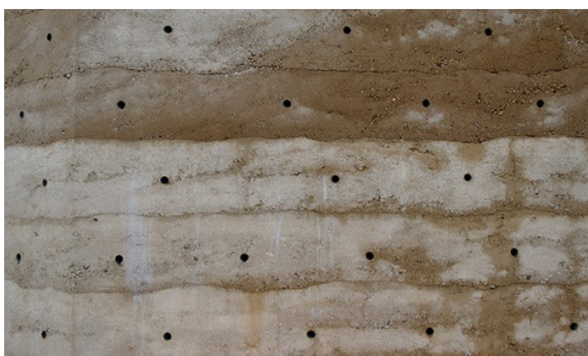
Figura 57: Pormenor da fachada onde podemos perceber a sua textura, a demarcação das diferentes camadas e ainda os tubos em metal nela embutidos. Autor: Thom McKenzie.
