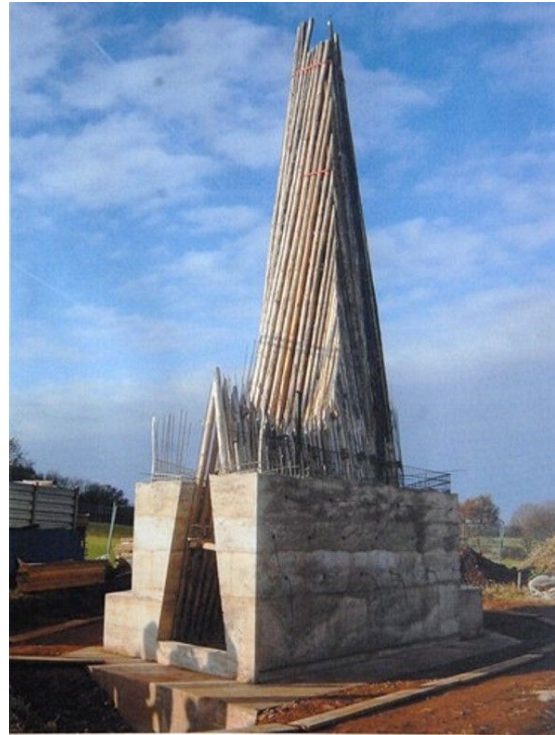
Figura 59: Fase de lançamento de betão.
