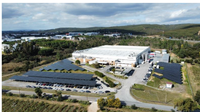
Figura 4 - Vista aérea da fábrica Tupperware em Montalvo [4]
