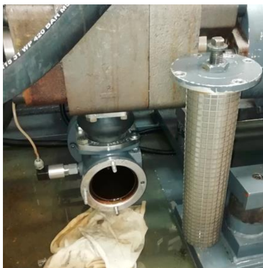
Figura 63 - Substituição do filtro de óleo
