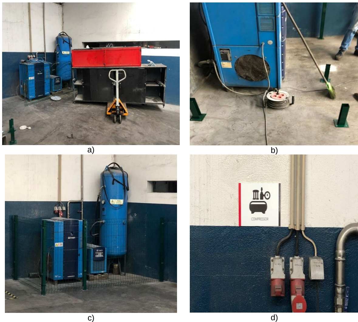
Figura 4.19. a) Separação e Organização dos Equipamentos; b) Instalação da Vedação; c) Vedação Concluída; d) Placa Identificadora.
