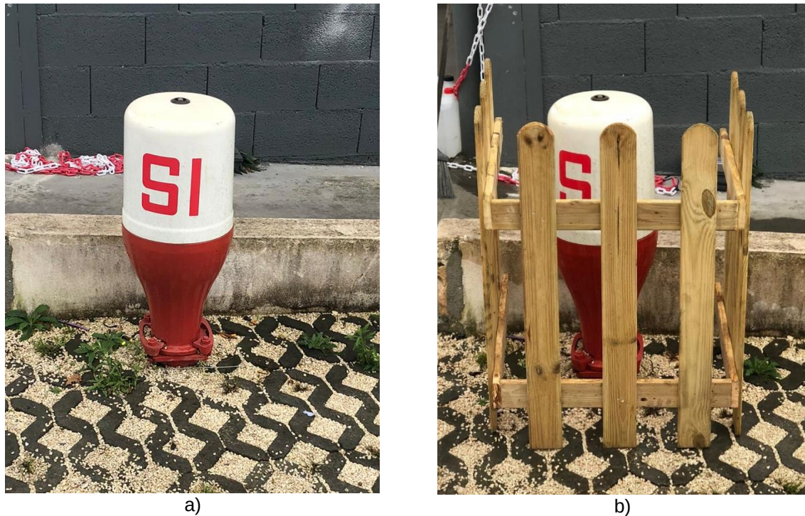
Figura 4.17. Boca de incêndio a) Antes da Intervenção; b) Depois da Intervenção.
