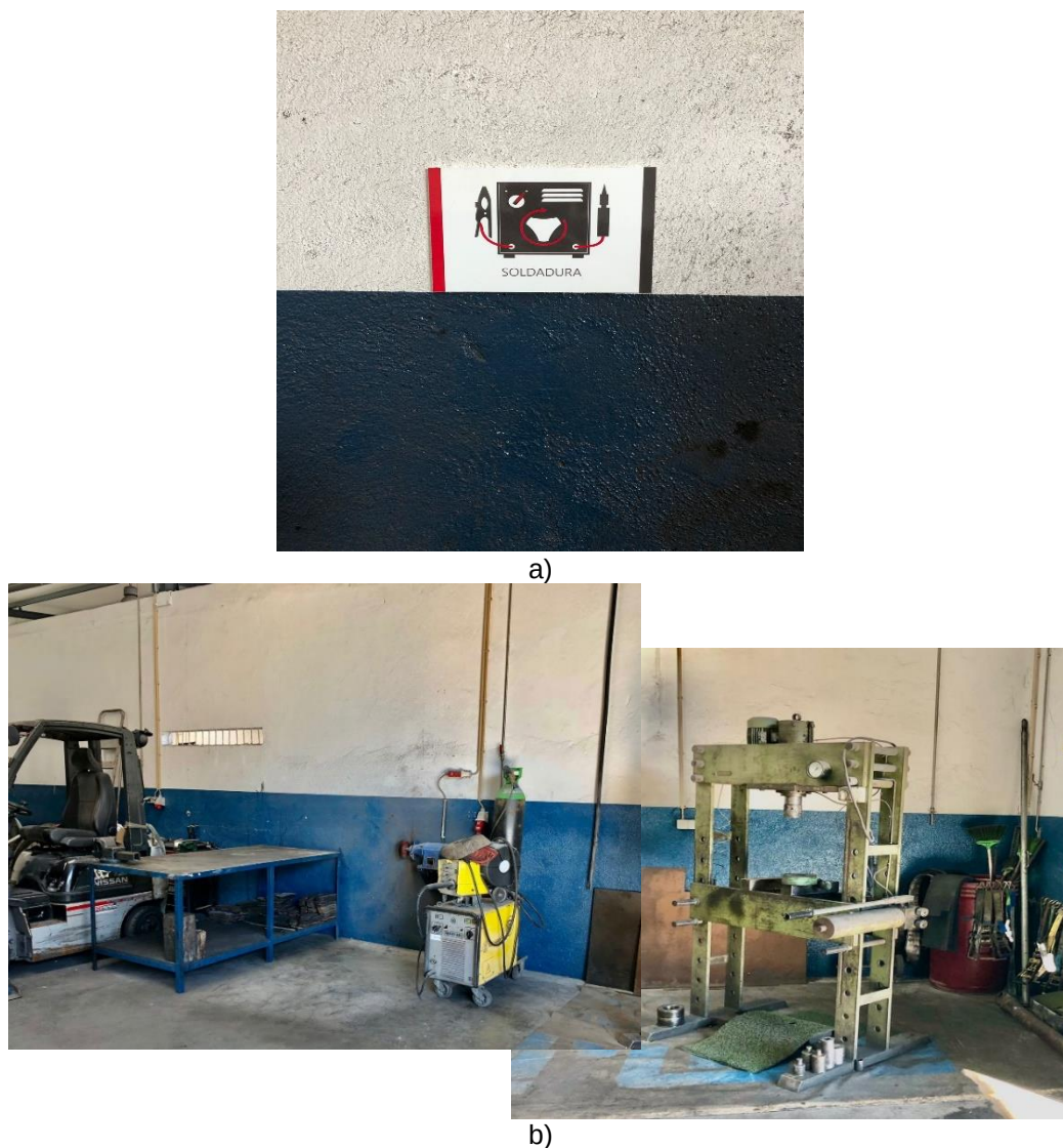
Figura 4.13. a) Placa Identificadora; b) Zona de Soldadura Pós Intervenção.
