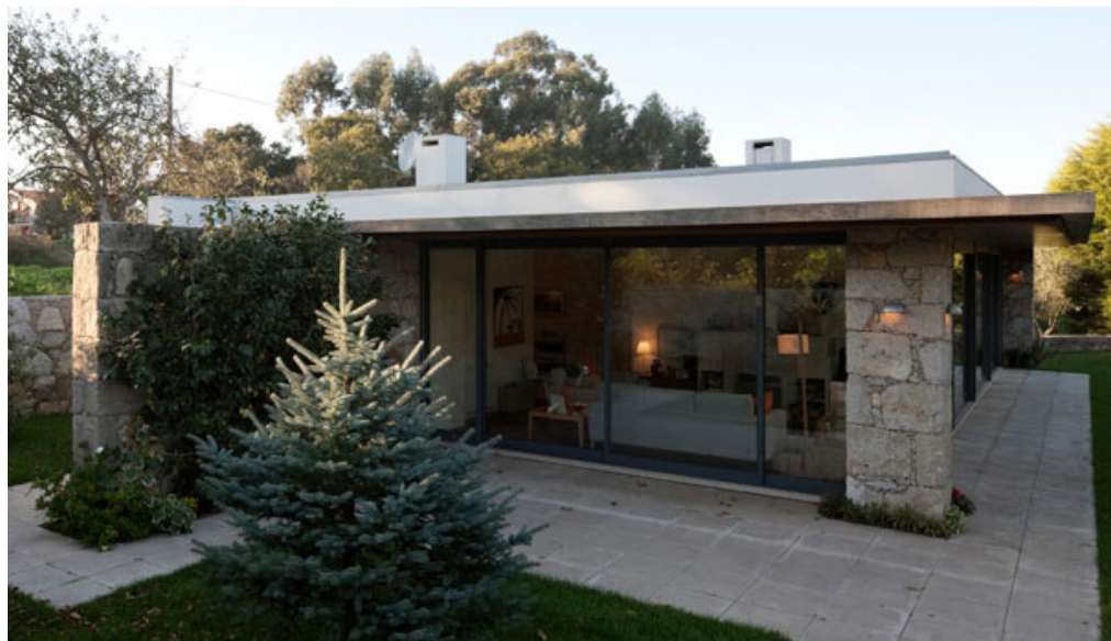
Imagem 34 | Fachada Frontal Pré-existência Casa de Férias em Moledo
