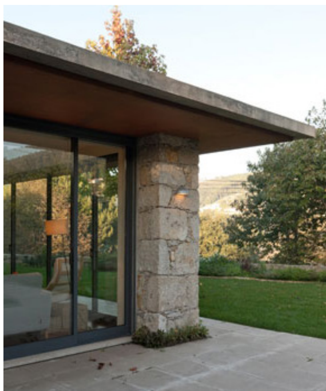
Imagem 35 | Pormenor de Fachada Frontal Pré-existência Casa de Férias em Moledo
