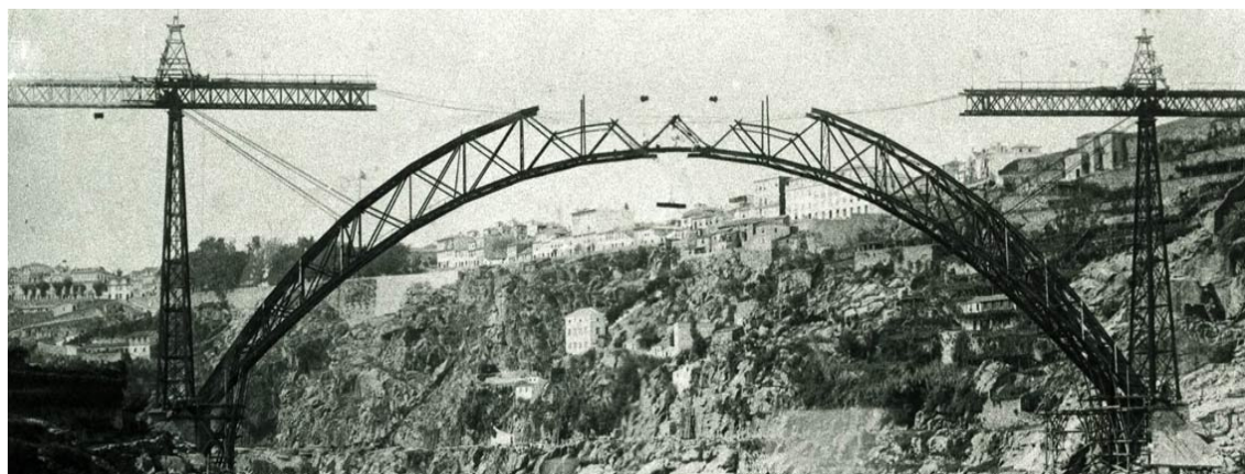
Figura 31: Construção da Ponte Maria Pia (século XIX)
