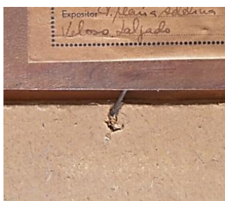
Figura 57 | Lacunas no reverso de uma pintura sobre cartão originadas por prego da moldura
