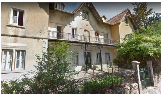
Figura 27 | Fachada da casa na Estrada Nova da Rainha, Colares. Google ©. Imagem captada em agosto de 2018.
