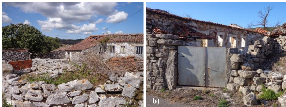
Figura 89 - Casa pátio: a) Covão do Sabugueiro; b) Casais dos Vales
