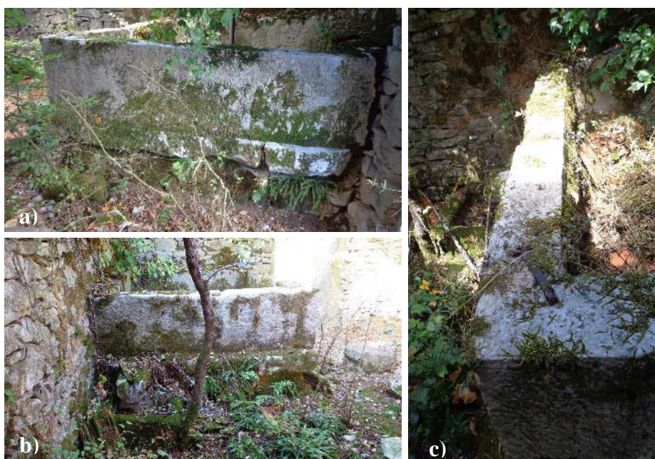
Figura 221 - Lagar: a) Pia de esmagamento com embasamento em pedra, b) Bica e pia de receção do vinho antes da armazenagem c) Lajes da pia de esmagamento chumbadas com gatos
