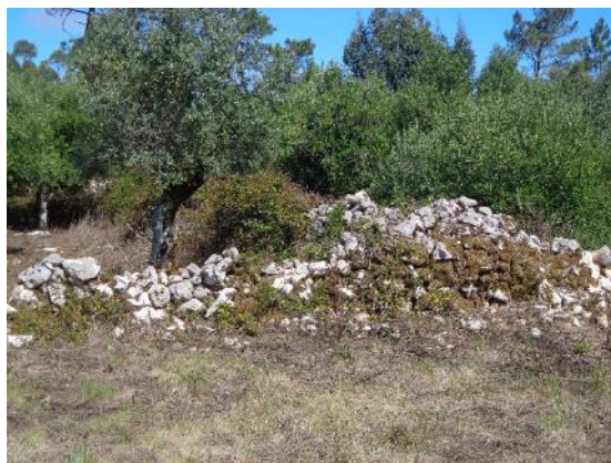
Figura 370 – Colapso e colonização biológica de muros devido ao abandono em choiso;
