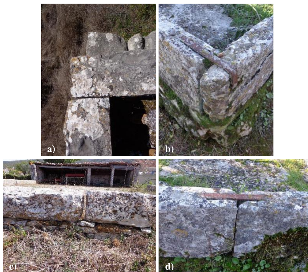
Figura 212 - Ligação entre elementos de cantaria: a) De esquadria, simples; b) de esquadria, com gato; c) sem ligação; d) em alinhamento, com gato;
