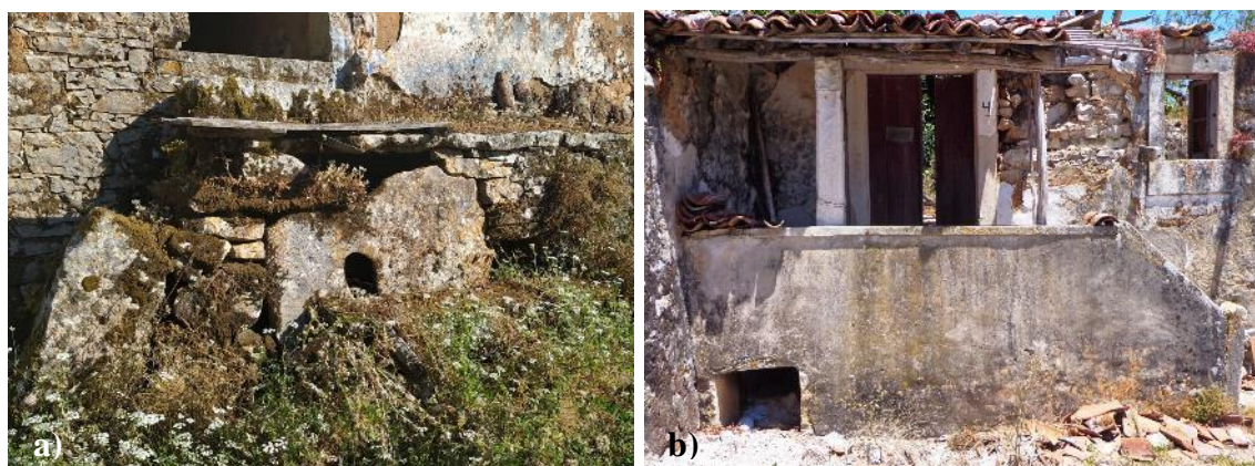
Figura 264 - a) Balcão com abertura para galinheiro; b) Balcão com abertura para galinheiro e alpendre
