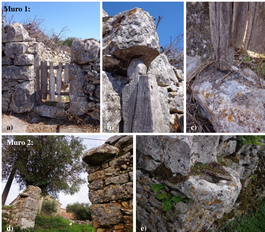
Figura 133 – Muro 1: a) Vista geral do portal; b) Detalhe do eixo do portal; c) Detalhe do eixo do portal – Soleira; Muro 2: d) e e) Pedras furadas encastradas em muro para rotação da cancela
