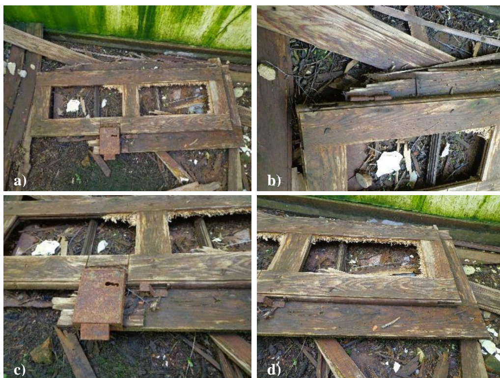
Figura 333 - a) Portada de janela com aro de gola; b) Pormenor da dobradiça; c) Pormenor da fechadura; d) Pormenor do caixilho
