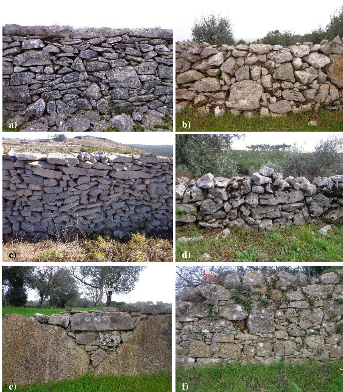
Figura 102 – Muro de pedra seca misto, quanto à forma e dimensão das pedras: a), b), c), d), e) e f)
