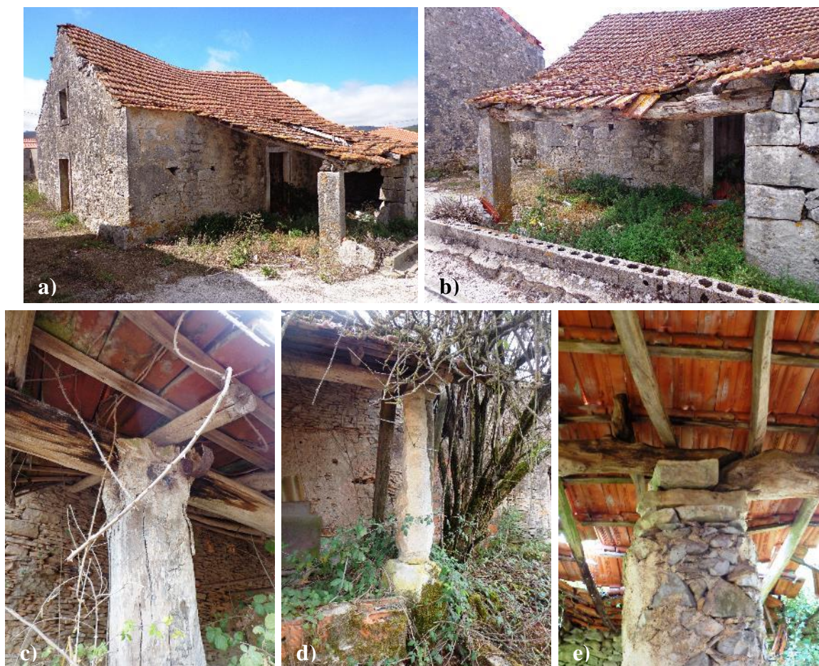
Figura 352 – a) Habitação com prolongamento de telhado para alpendre; b) Pormenor do apoio do vigamento na parede resistente; c) Suporte de telhado com raiz de madeira; d) Suporte de telhado com coluna e capitel; e) Suporte de telhado com coluna em alvenaria – Ligação entre vigas
