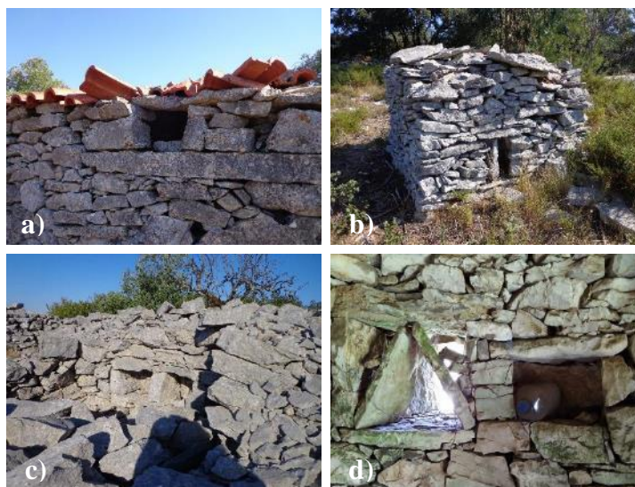
Figura 167 - Postigos: a) de ventilação; b) de vigia; c) de acomodação; d) de vigia e acomodação
