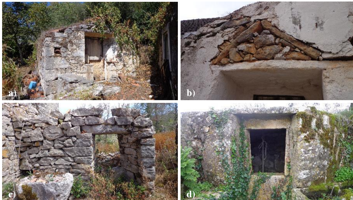
Figura 197 – Frontal – Cisternas: a) Com conversadeiras laterais; b) Com portal ressalvado por arco triangular; c) Com portal ressalvado por padieira em cantaria toscamente aparelhada; d) Coberta com laje de telhado
