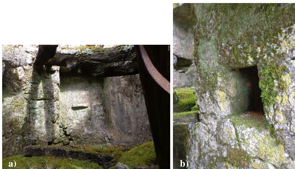
Figura 239 – a) Nicho do borrarho ou da fogariça; b) Nicho para colocação de chaves (entrada da porta)
