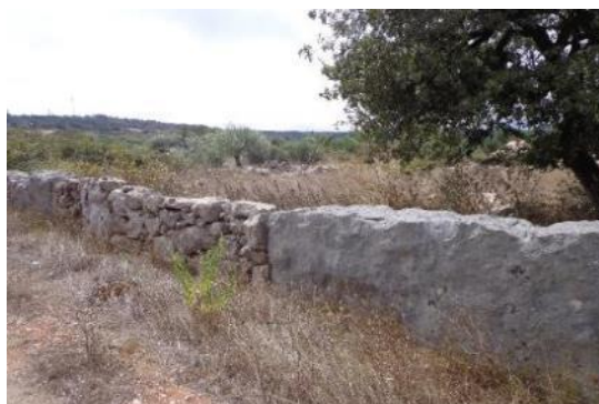
Figura 123 - Muros de pedra seca mistos (pedra de pequena dimensão/ grande dimensão)
