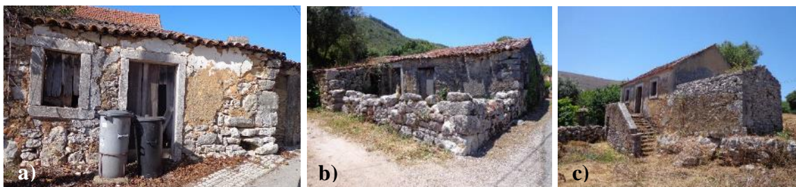
Figura 5 - Habitações vernaculares do P.N.S.A.C.: a) Habitação simples; b) Habitação com dependências e anexos; c) Habitação de sobrado
