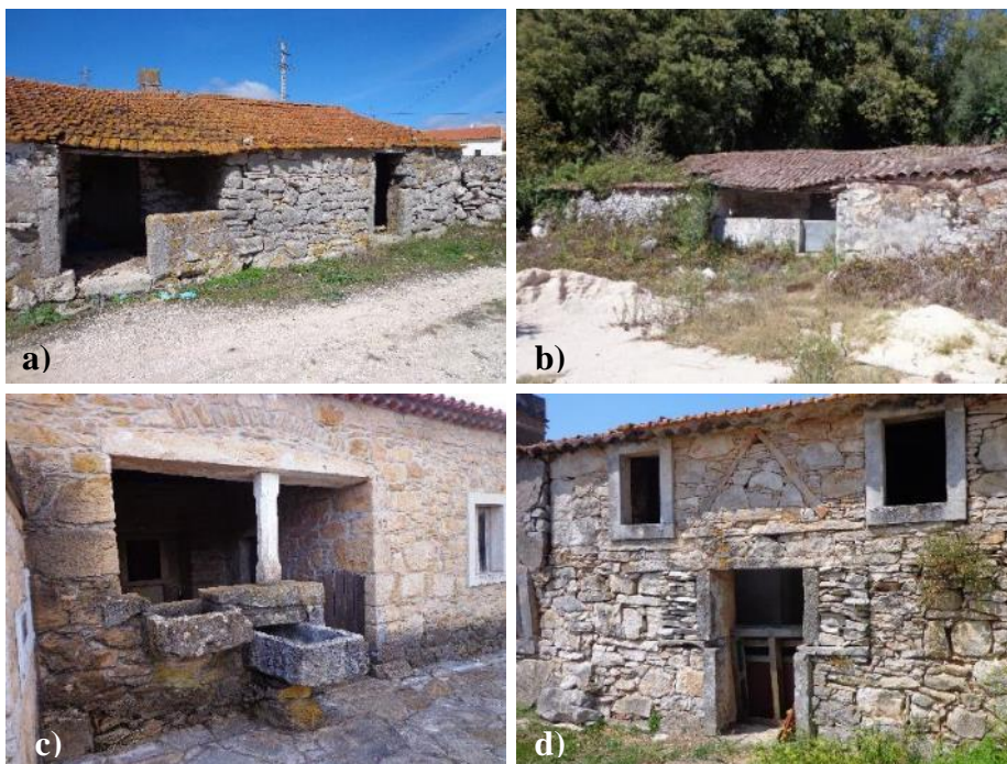
Figura 256 - Casas com alpendre: a) e b) Alpendre de pial em L; c) Alpendre com arco de ressalva e pias para dessedentar o gado; d) Alpendre de pial em T, posteriormente colmatado;
