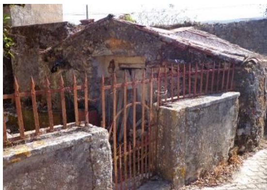
Figura 131 - Cancela em ferro forjado
