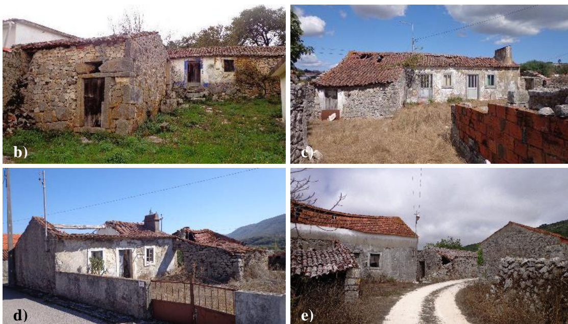
Figura 260 – a) Ampliação da tipologia tipo nas construções de rés do chão do P.N.S.A.C. em forma de L; b), c) e d) Proteção da incidência do vento de norte e noroeste; c) Com proteção da incidência solar na vertente sul;
