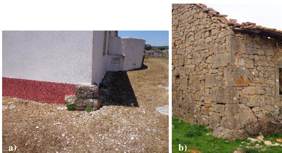
Figura 278 – a) e b) Alargamento da base da fundação na zona do cunhal para proteção e reforço de parede e cunhal
