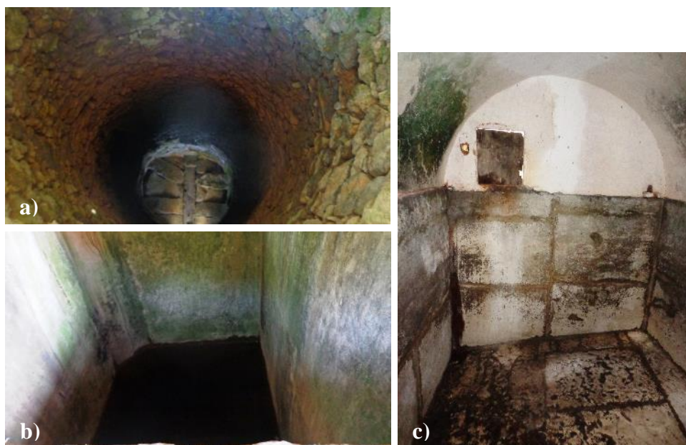
Figura 192 – Reservatórios: a) Redondo, com pedra à vista; b) Quadrilátero, rebocado; c) Cisterna com lajes
