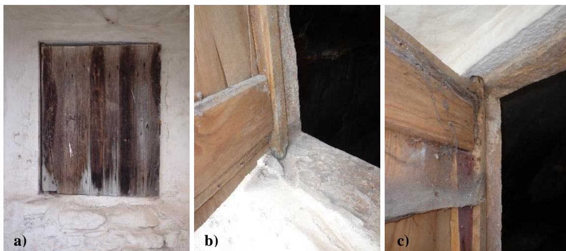
Figura 199 - Portinhola de acesso a cisterna: a) Alçado; b) Entalhe no peitoril para encaixe do eixo da porta; c) Entalhe na padieira para rotação do eixo da porta
