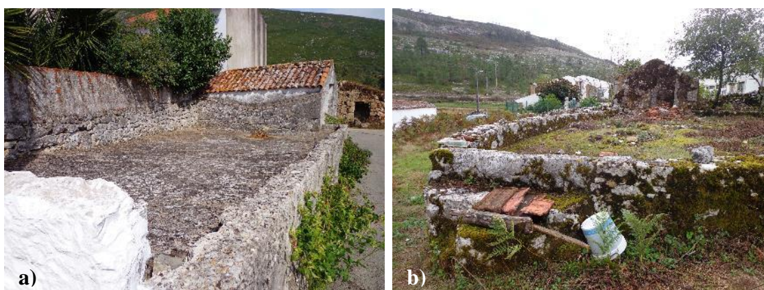
Figura 204 - Eira de sequeiro e recolha de água: a) Com cisterna; b) Com poço
