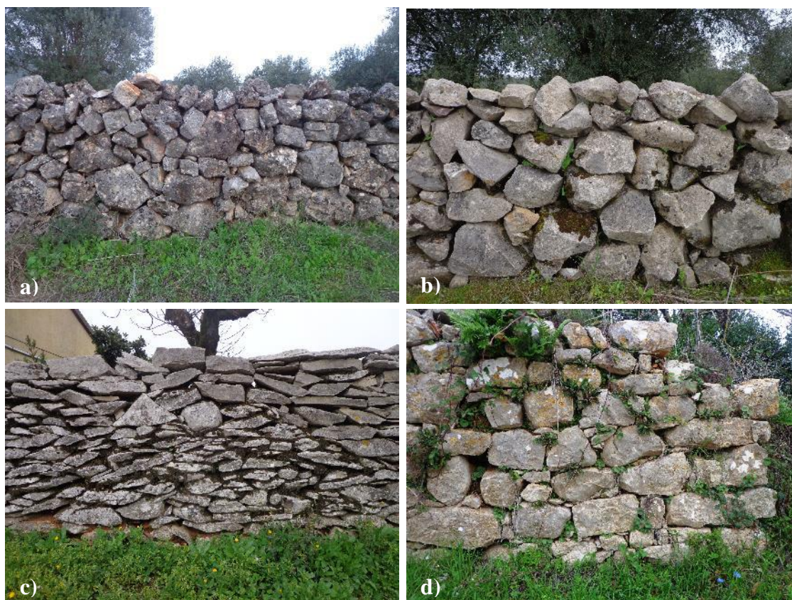
Figura 101 - Dimensão distinta dos elementos constituintes: a), b) e d) Elementos maiores na base do muro; c) Espaço temporal distinto na aplicação;
