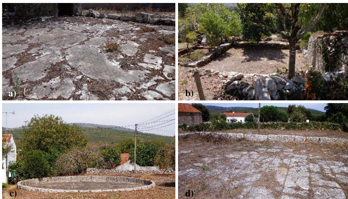
Figura 207 - Pavimento das eiras: a) Pedra tosca, não aparelhada; b) Terra batida; c) Argamassa; d) Cantaria lajeada
