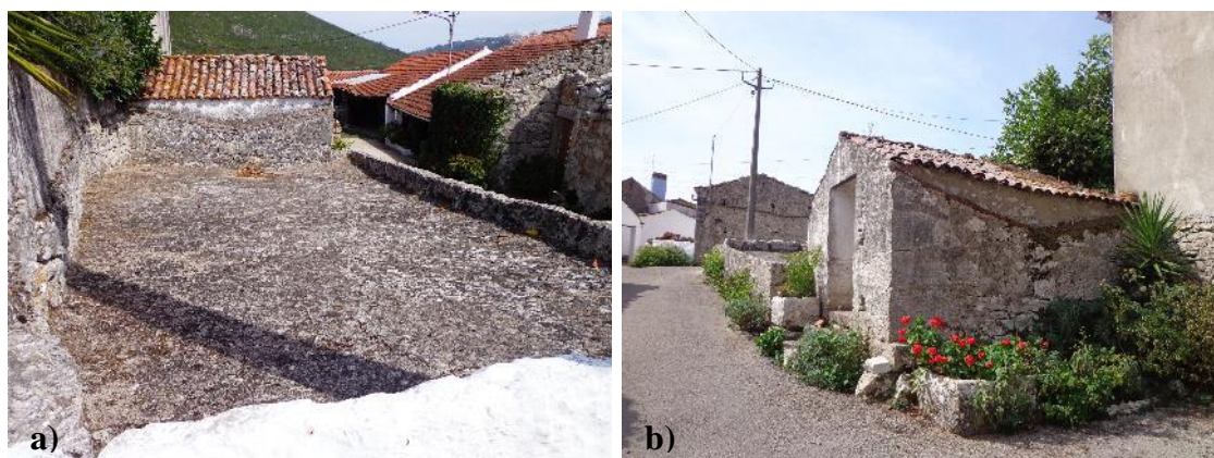
Figura 181 – a) Eira em declive de receção e condução de água; b) Vista geral do sistema eira/cisterna
