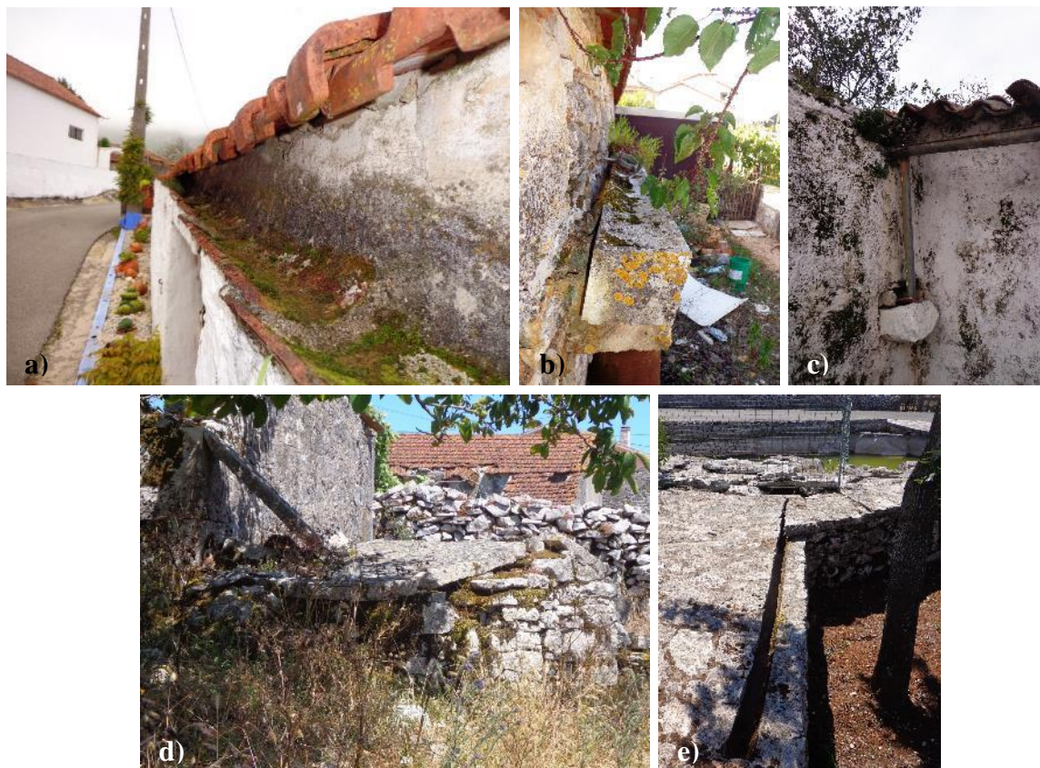
Figura 172 - a) Caleiras em telha de canudo; b) Caleiras em pedra; c) Caleira e tubo de queda em zinco; d) Recolha e transporte por canaleta em pedra; e) Canaleta, por sulco em pedra
