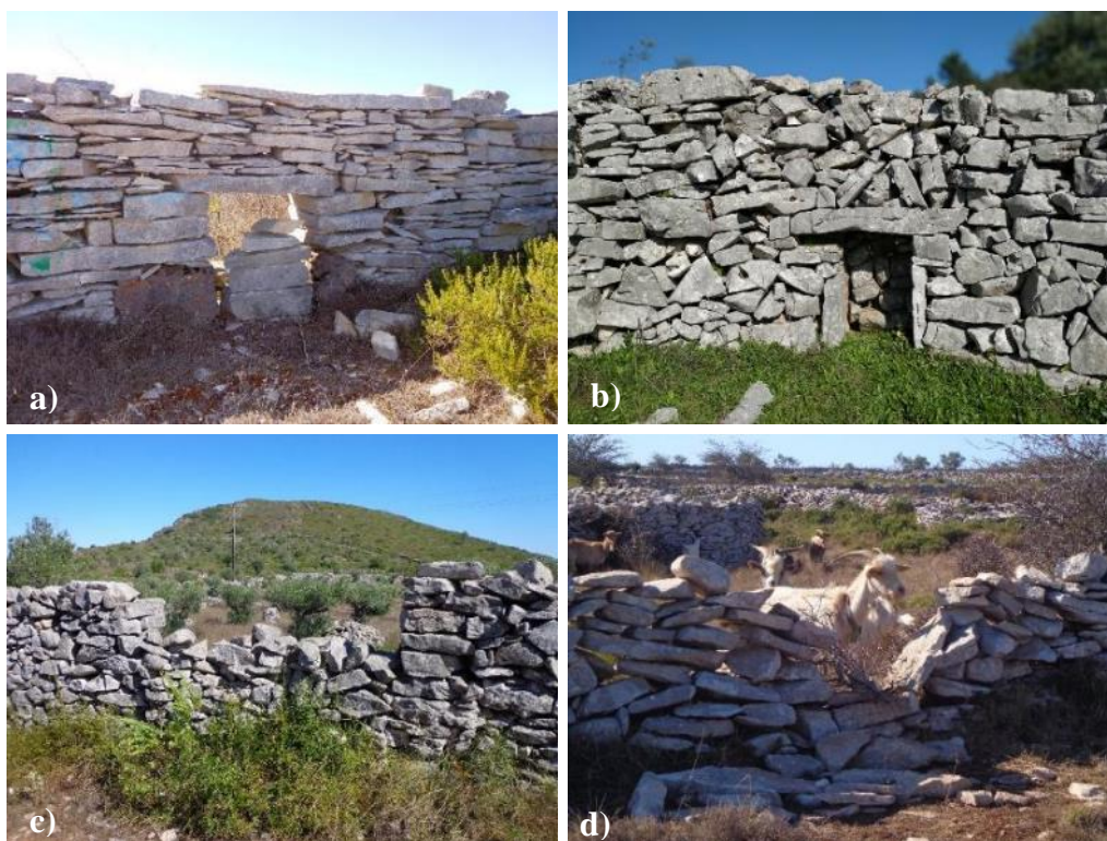
Figura 122 – Passagens entre chousos: a) Buraca; b) Buraca com arco de ressalva; c) e d) Desmantelaamento de partes de muro para passagem de animais
