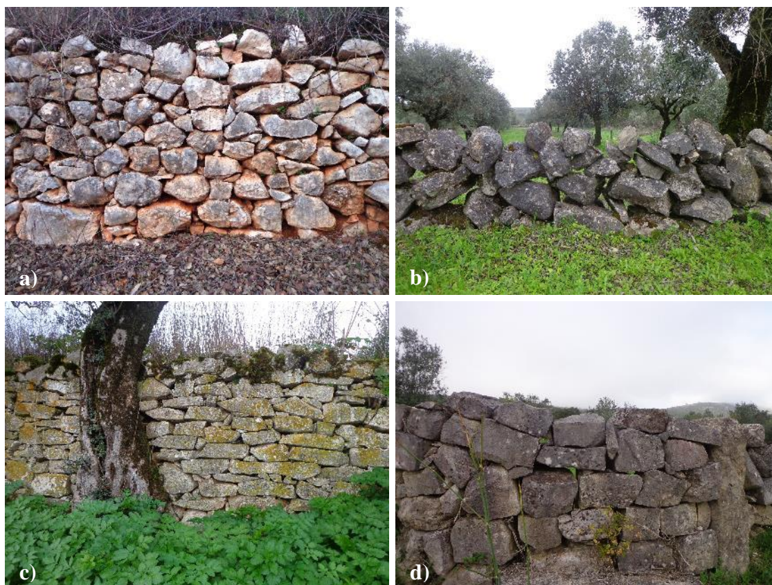
Figura 100 – Tipologia quanto às formas da pedra: a) Arredondada; b) Angular; c) Paralelepípedica (retangular ou planar); d) Paralelepípedica (Quadrangular)
