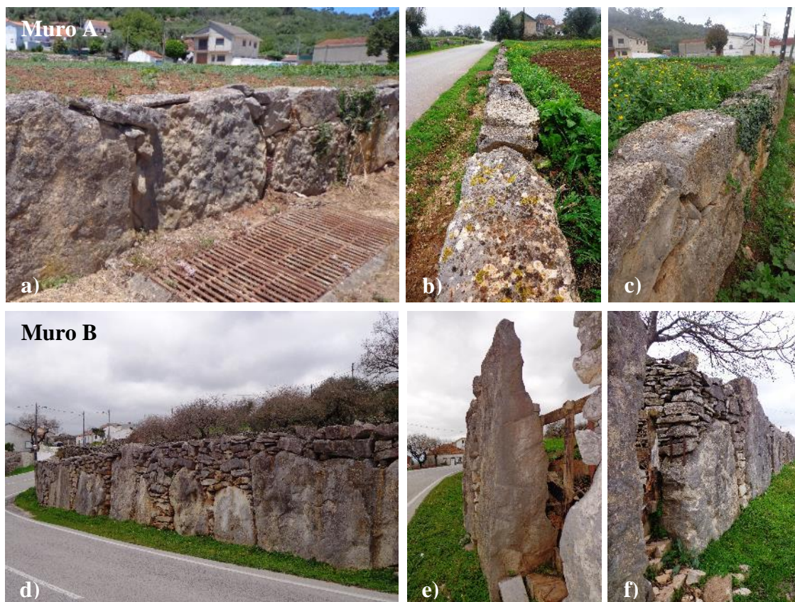
Figura 137 – Socalcos com utilização de grandes blocos pétreos - Muro A: a) Vista frontal; b) Vista de cima; c) Perspectiva/ Muro B: d) Vista frontal; e) Vista lateral; e) Perspectiva
