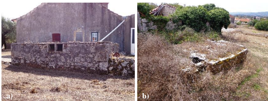
Figura 185 - Cisterna de lajes sobrepostas a muretes de pedra: a) Cisterna dupla;
