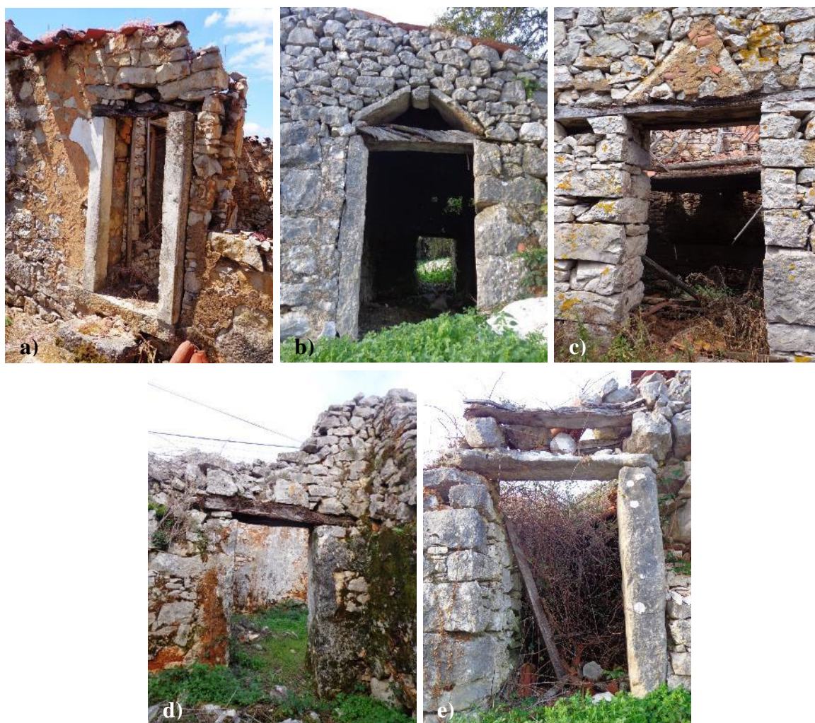
Figura 310 - Padieira em madeira com ressalvas horizontais em pedra, dispostas em pirâmide; b) Padieira em madeira com ressalva triangular e pedra de fecho; c) Padieira em madeira com ressalva de pedra em ângulo; d) Padieira simples em madeira; e) Padieira em pedra com ressalva horizontal em madeira;
