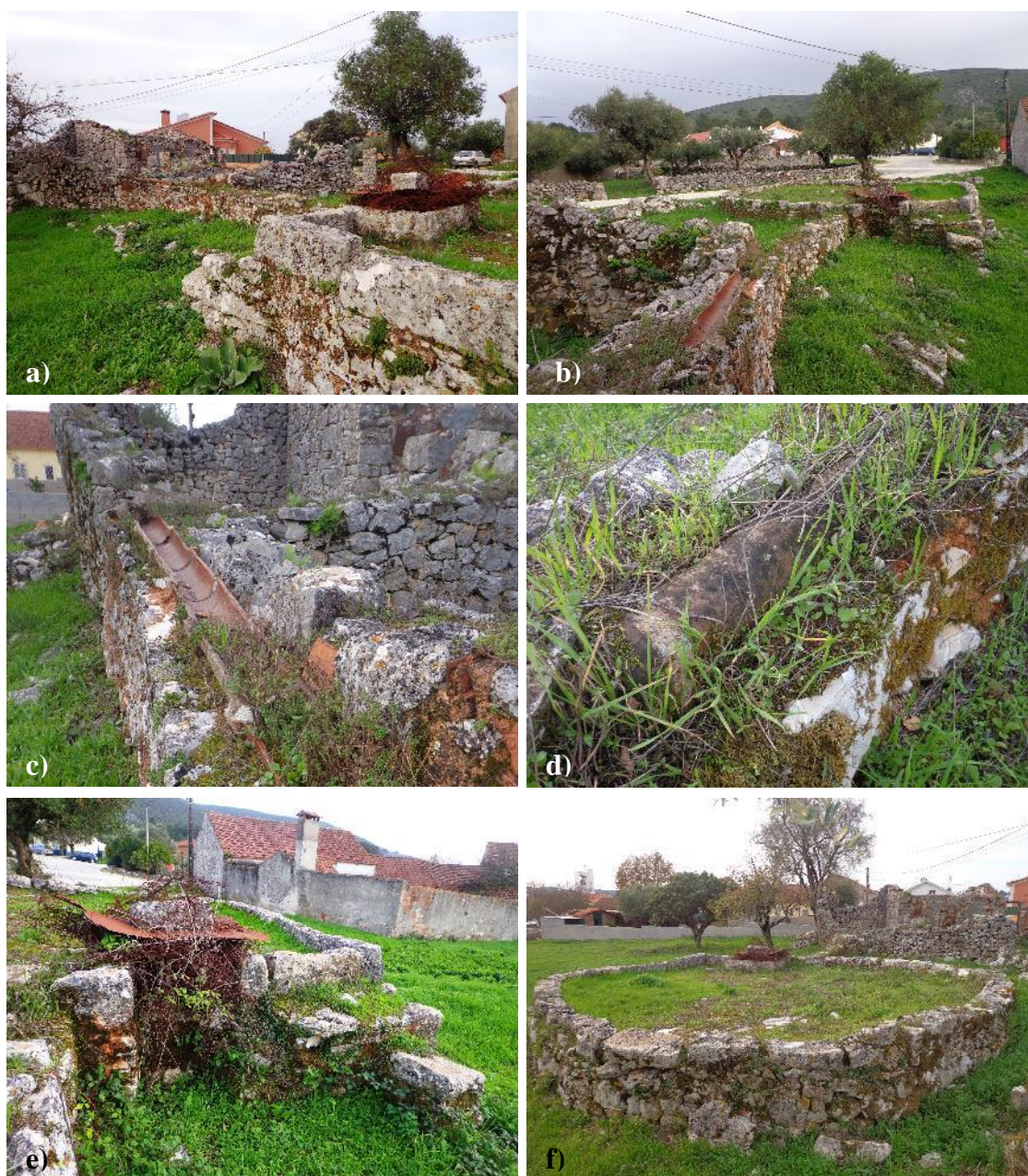
Figura 179 – a) Sistema misto de condução de águas pluviais: Vista geral; b) Dreno e eira de poço; c) Tubulação em terracota na condução das águas do telhado; d) Dreno tubular embutido em muro; e) Boca de eira de poço; f) Eira de poço
