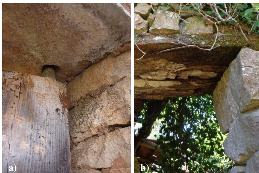
Figura 314 - Cavidades para rotação de couceiras: a) Em padieira de pedra; b) Em padieira de madeira
