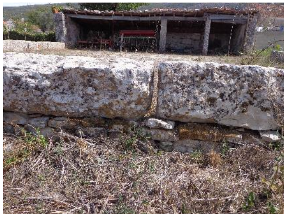
Figura 208 - Embasamento da eira em pedra seca;
