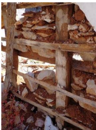
Figura 340 – Enxaimel com pedras e juntas com argamassa de cal e areia vermelha;
