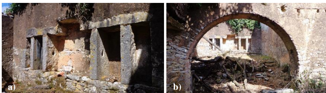
Figura 219 – Lagar de azeite: a) Agulheiras de apoio do sistema de prensagem por vara; b) Vista geral
