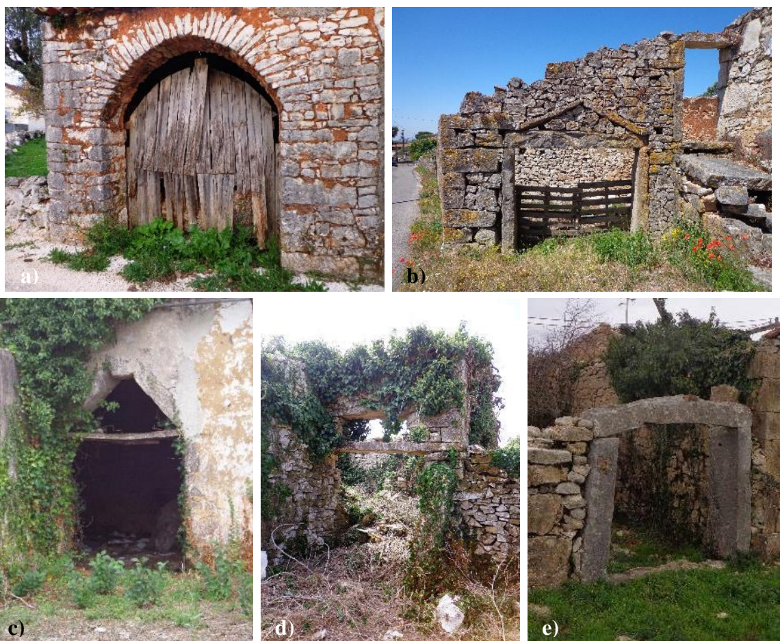
Figura 312 – a) Portal em arco de volta perfeita; b) Portal com padieira ressalvada em ângulo; c) Portal com padieira em madeira e ressalva em angulo com pedra de fecho; e) Portal com padieira em cantaria tosca segundo arco abatido.
