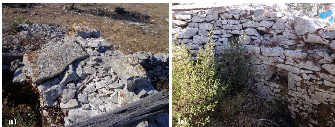
Figura 231 – a) e b) Tições e sogas em parede de moinho
