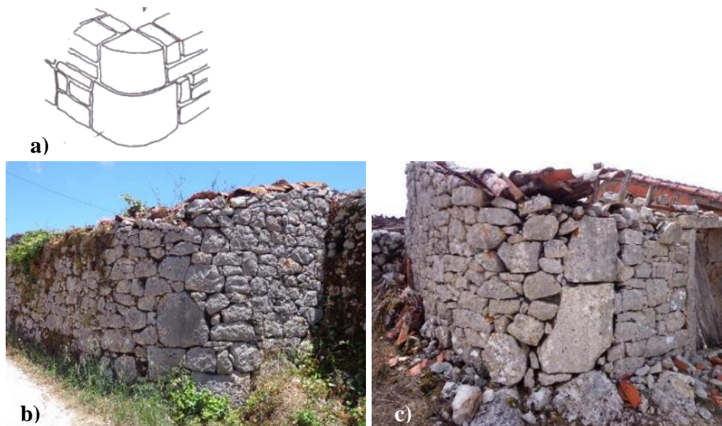
Figura 297 - a) Reforço de cunhais redondos: com pedras de cantaria; b) Reforço em cunhal redondo de forma escalonada com pedras maiores em baixo e menores em cima; c) Reforço de cunhais redondos com elementos com função de pilares
