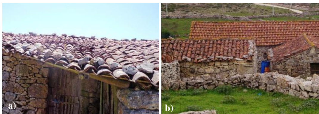
Figura 252 - Proteção do telhado com pedras evitando os ventos fortes: a) Portela de Vale Espinho; b) Vale de Ventos
