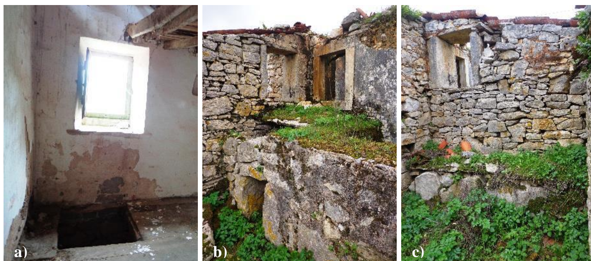
Figura 268 - a) Alçapão interior para alimento do gado; c) Galinheiro e janelas para atirar os restos para o gado (Vista da rua); d) Janela por onde eram atirados os restos para o gado e manjedoura (Interior do curral)
