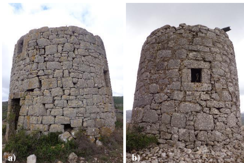
Figura 230 – a) e b) Embasamento com elementos pétreos maiores na base do moinho
