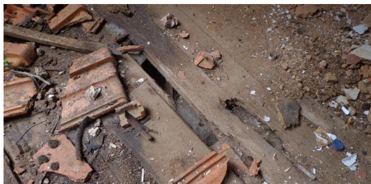
Figura 343 - Réguas de soalho dispostas à meia vez
