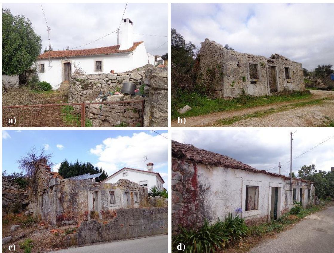
Figura 250 – Fachada-tipo janela-porta-janela da habitação de rés-do-chão do P.N.S.A.C: a), c) e d) Com reboco; b) Sem reboco
