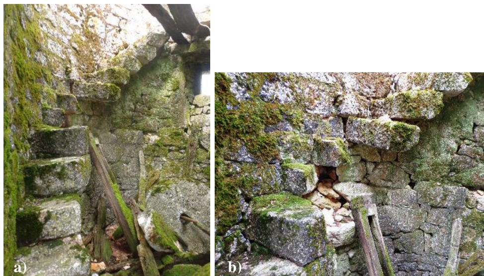
Figura 237 – Escada: a) Ligação da escada com a soleira e com o sobrado; b) Encastre dos degraus da escada na parede
