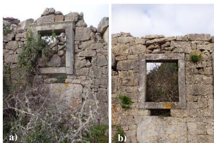
Figura 305 - a) Padieira sem ressalva em cantaria talhada; b) Padieira com ressalva horizontal;
