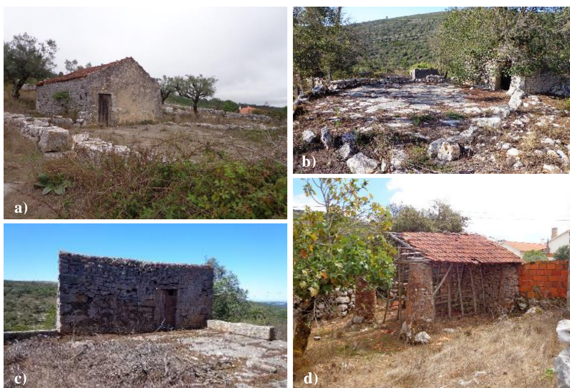
Figura 214 – Estruturas de sequeiro: a), b) e c) Casa da eira; b) Espigueiro
