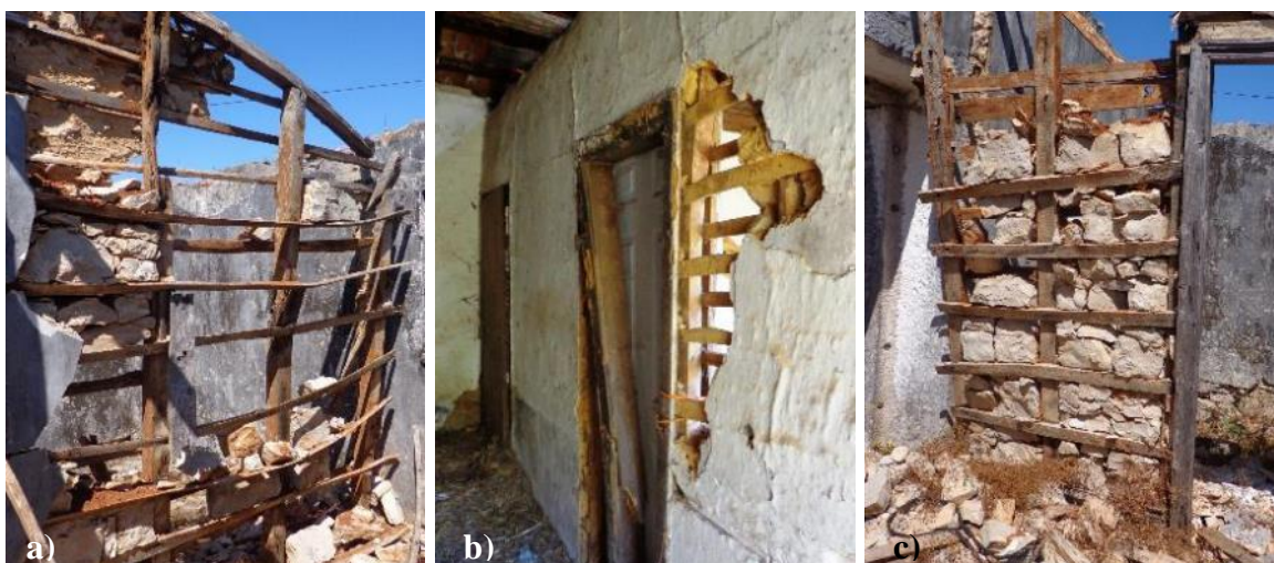
Figura 339 - Enxaimel: a) Estrutura de madeira (Barrotes verticais; Fasquios; Frechais); b) Pormenor de enxaimel com reboco e fasquios; c) Pormenor de encaixe das pedras
