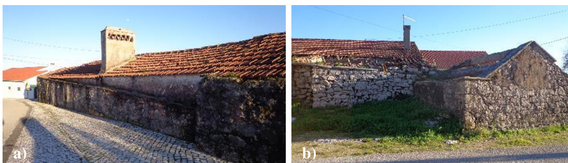
Figura 355 - Sistemas de recolha de água pluvial para cisterna: a) Segundo canais em telha de canudo; b) Segundo canaleta em pedra lavrada
