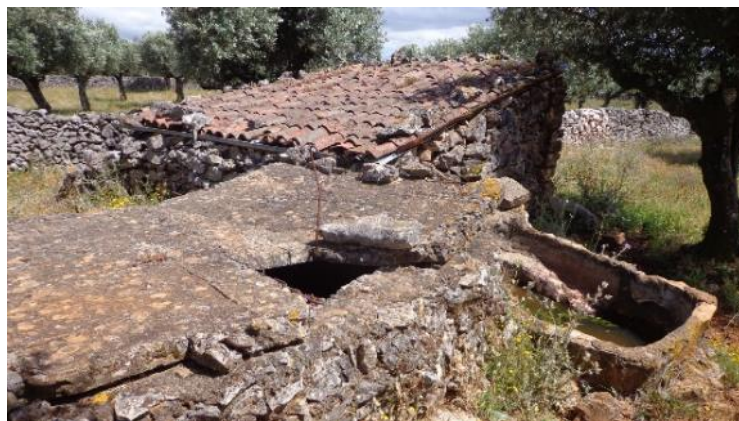
Figura 161 - Casina: Telhado de uma água com ripado de madeira e telha de canudo
