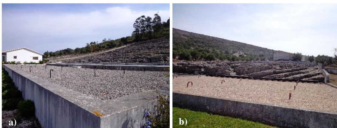
Figura 188 - Telhados de água: a) Serro Ventoso; b) Mendiga
