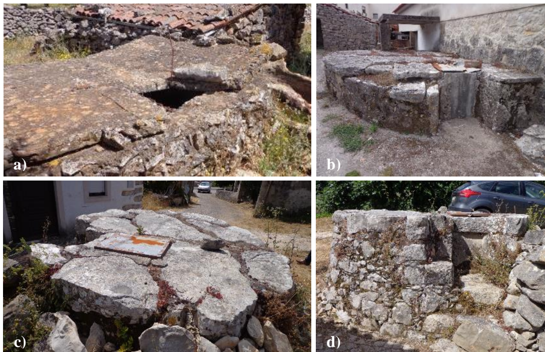
Figura 183 – Poços com cobertura de lajes: a) Sobrelevado com acesso por ausência de pedra; b) Sobrelevado com acesso por postigo metálico; c) Cobertura com laje sem talhamento e acesso por postigo metálico; d) Sobrelevado, com escada e com poial para cântaro
