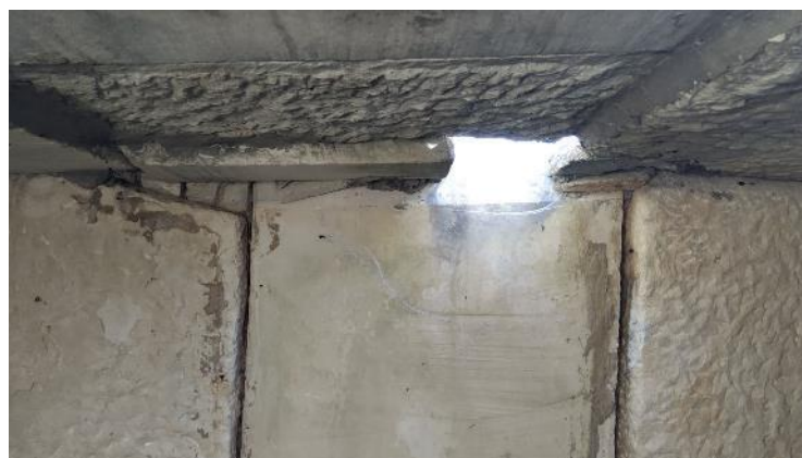
Figura 202 - Orifício de ventilação de cisterna
