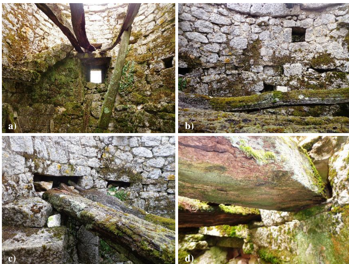
Figura 238 - Sobrado: a) Vigamento de madeira; b) Nichos de encastramento com ressalto das paredes do rés do chão; c) Apoio da viga acima do vão suportado por padieira; Encastre simples da viga de madeira
