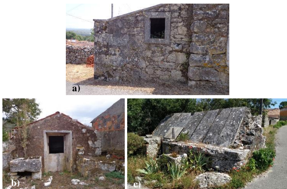
Figura 187 – Cisternas: a) de uma água, coberta com laje de pedra; b) de duas águas, com telhado; c) de duas águas, coberta com lajes de pedra
