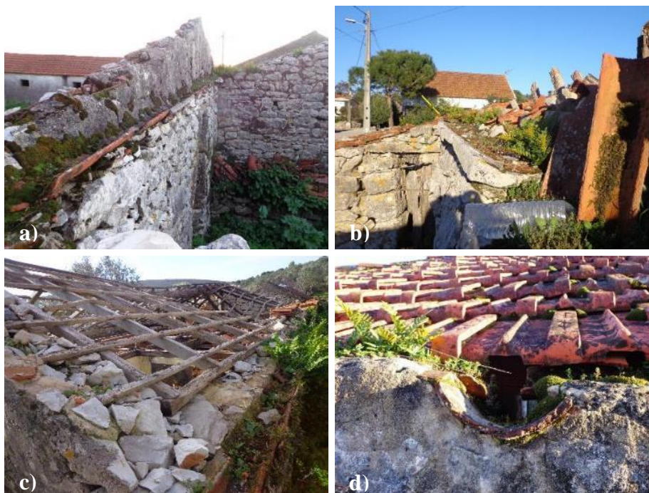
Figura 356 – a) Remate de cobertura com calceira na ligação entre paredes; b) Calceira de condução de água em pedra calcária c) Calceira vulgar em telha cerâmica de escoamento de águas pluviais para cisterna; d) Ladrão de escoamento de águas pluviais em telhado
