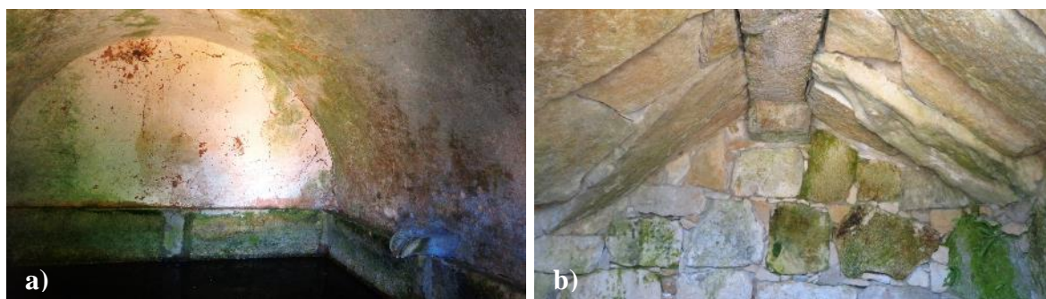
Figura 194 – Cisterna: a) Cobertura em abóbada; b) Cobertura em duas águas
