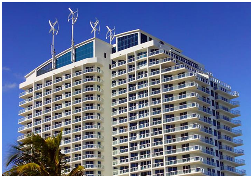
Ilustração 14 - Turbinas eólicas no hotel Hilton Fort Lauderdale (Inhabitat, 2014)
