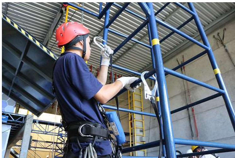
Figura 5 - Trabalhos em altura com corda em Y/duplo chicote (Conect 2021)
