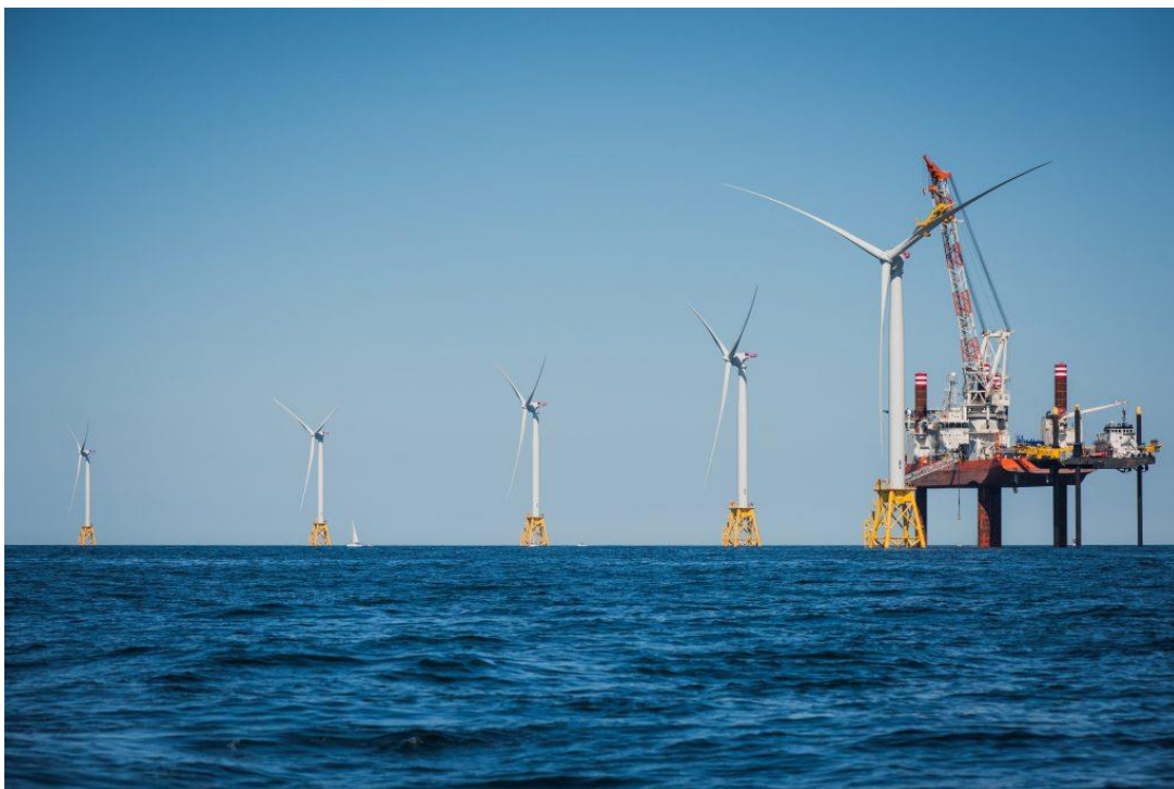
Figura 129 - Instalação do último aerogerador BIWF5 [99]
