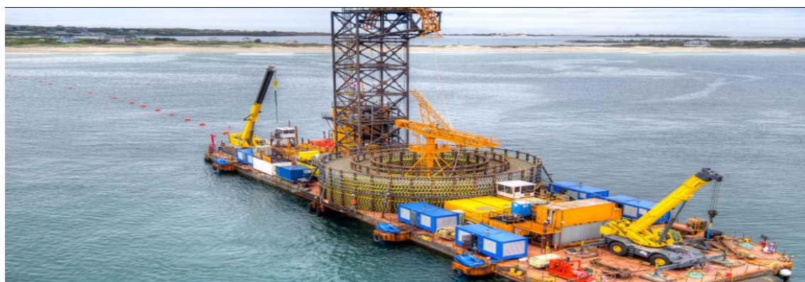
Figura 128 - Barco de instalação dos cabos elétricos [106]
