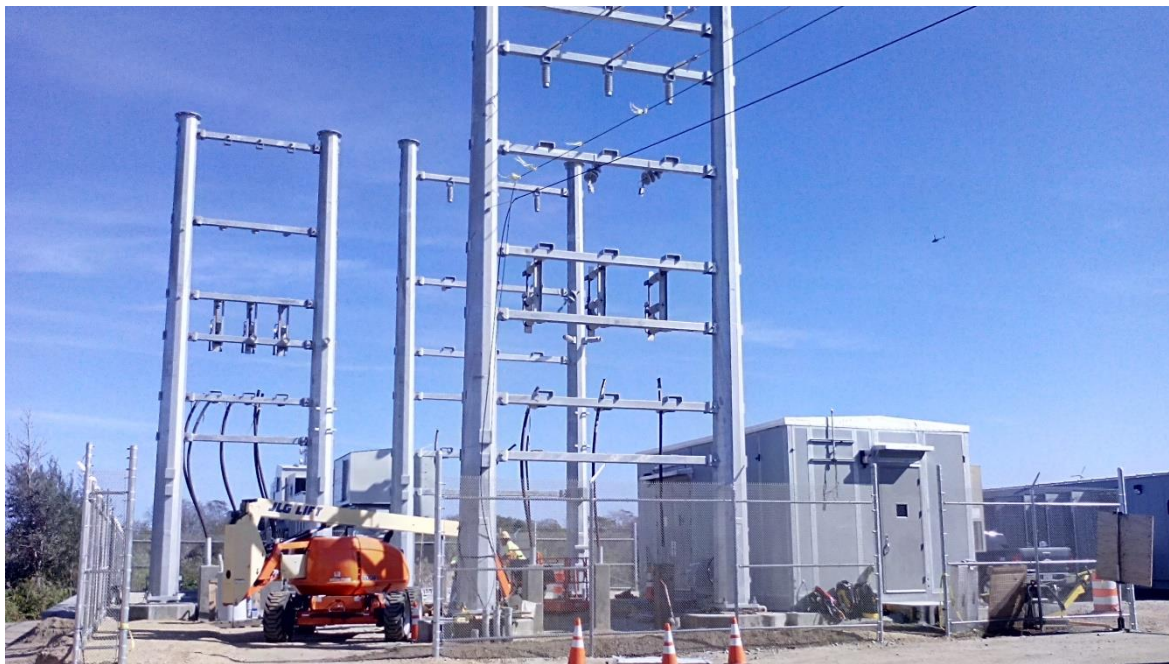
Figura 124 - Subestação em fase de construção (foto obtida pelo discente em 17/09/2016)
