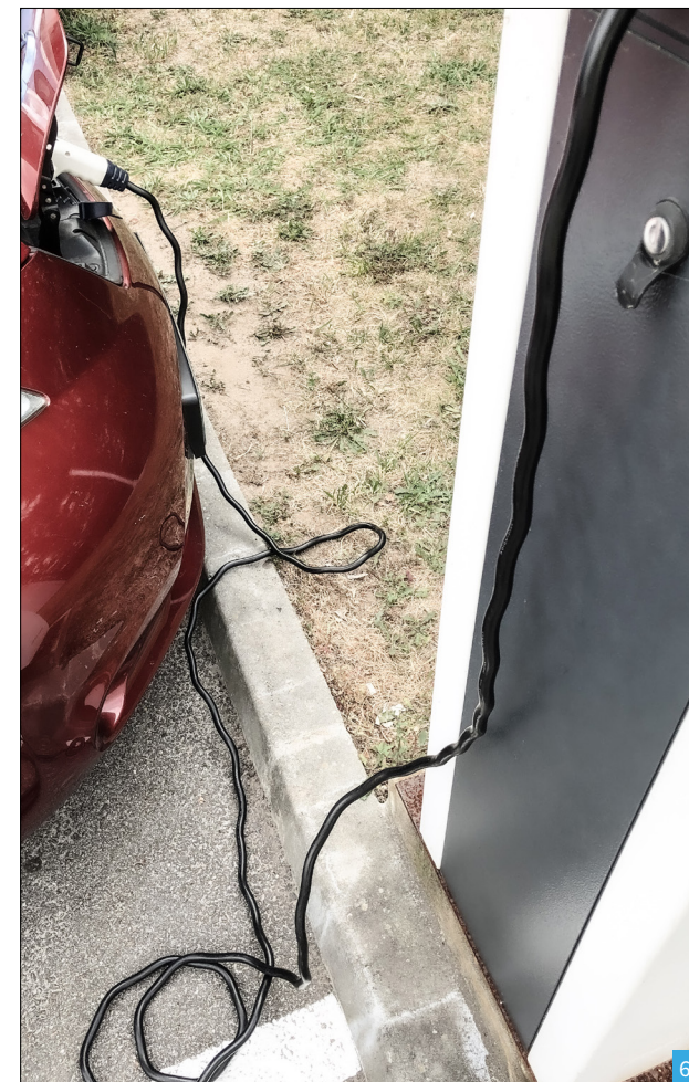
[66] Cabo elétrico de diâmetro pequeno, já danificada pela utilização
