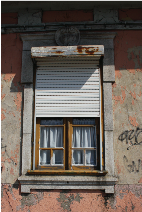
Fig. 7 - janela central da fachada sul
