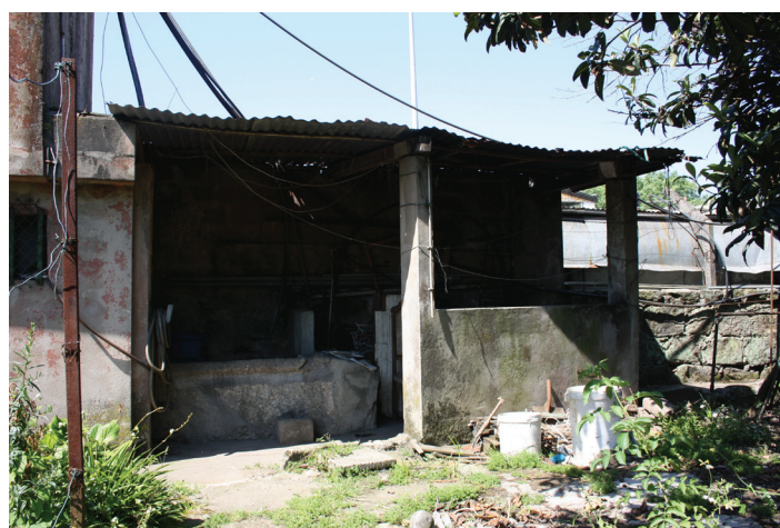
Fig. 17 - tanque e roda de extracção de água
