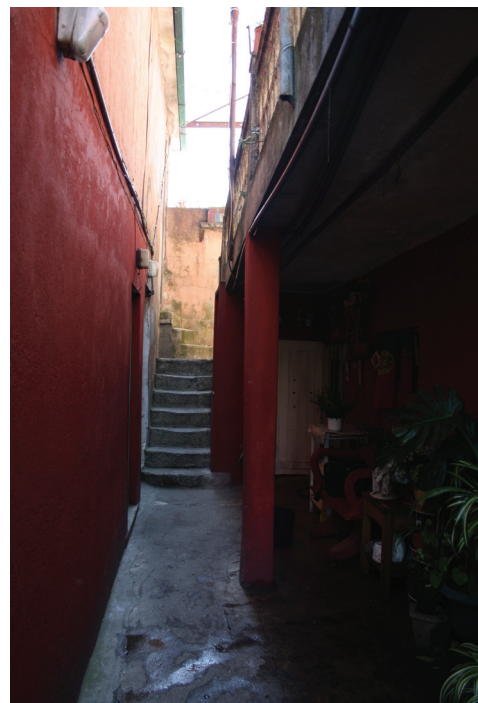
Fig. 14 - acesso ao piso inferior
