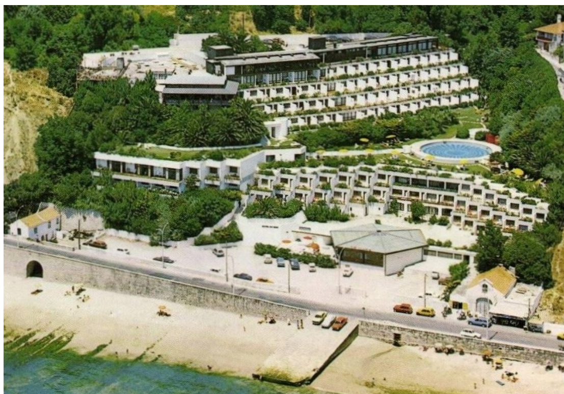
Fig. 61 Vista aérea do hotel, colocando em evidência a ampliação levada a cabo durante a 2. a fase de construção; Hotel do Mar, Sesimbra, ca. 2013.
