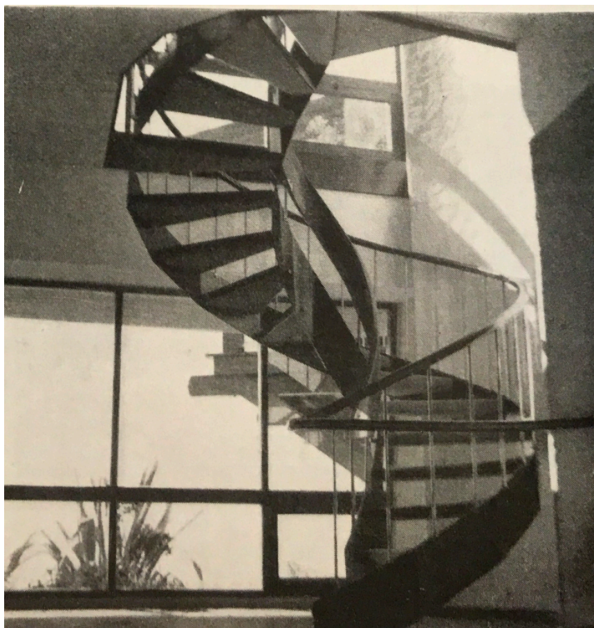
Fig. 42 Fotografia das escadas espiraladas no interior; Hotel do Mar, Sesimbra, ca. 1963. © Arquitectura , n.º 80, Dezembro de 1963, 22-27.
