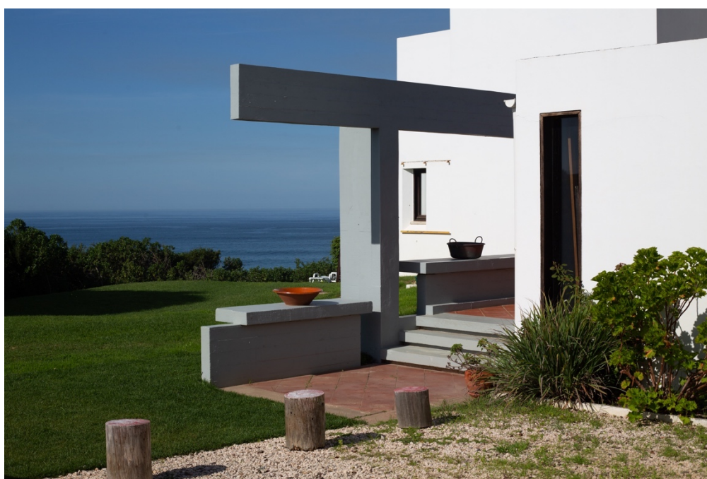
Fig. 115 Entrada da Herdade do Brejão – Fundação Amália Rodrigues, 2022. © Alexandre Melo da Cunha
