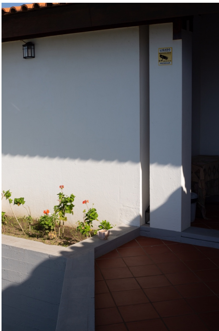
Fig. 118 Posicionamento intencional do pilar junto à parede, colocando-o ao mesmo nível da fachada. Reforça, através do espaço negativo resultante (entre a parede e o pilar), a continuidade da gramática rectilínea através do aparente vazamento no volume. Por este motivo, e por subtilmente gerar diferentes gradações de luz, poderá ser um pormenor que escape à percepção consciente do observador.
