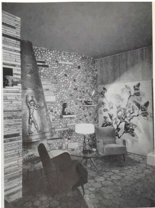
Fig. 17 Secção 'rústica' da loja Rampa. Observe-se a utilização do calhau serrado na parede e a aplicação de madeira serrada e polida no pavimento. © Atrium , n.º 1, Setembro-Outubro de 1959, 34-41.
