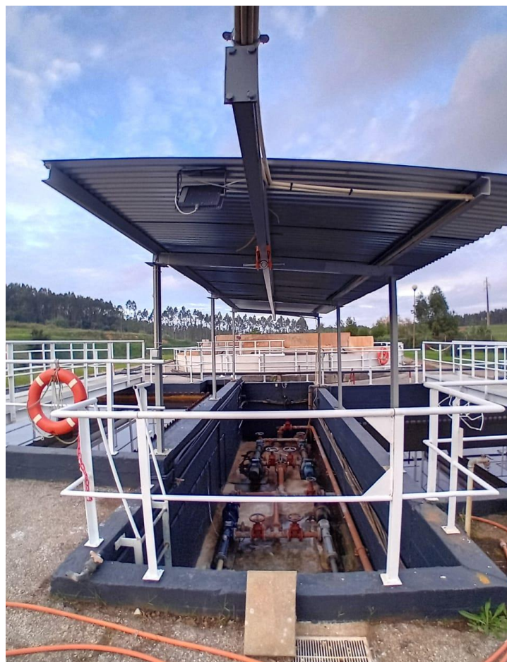
Figura 5.14 – Telheiro entre decantadores restaurado
