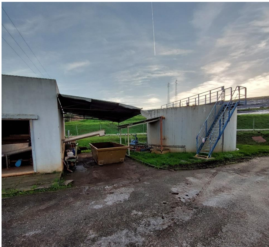
Figura 5.9 – À esquerda edifício de desidratação de lamas, à direita espessador de lamas e entre estes dois a construção de um telheiro a uni-los
