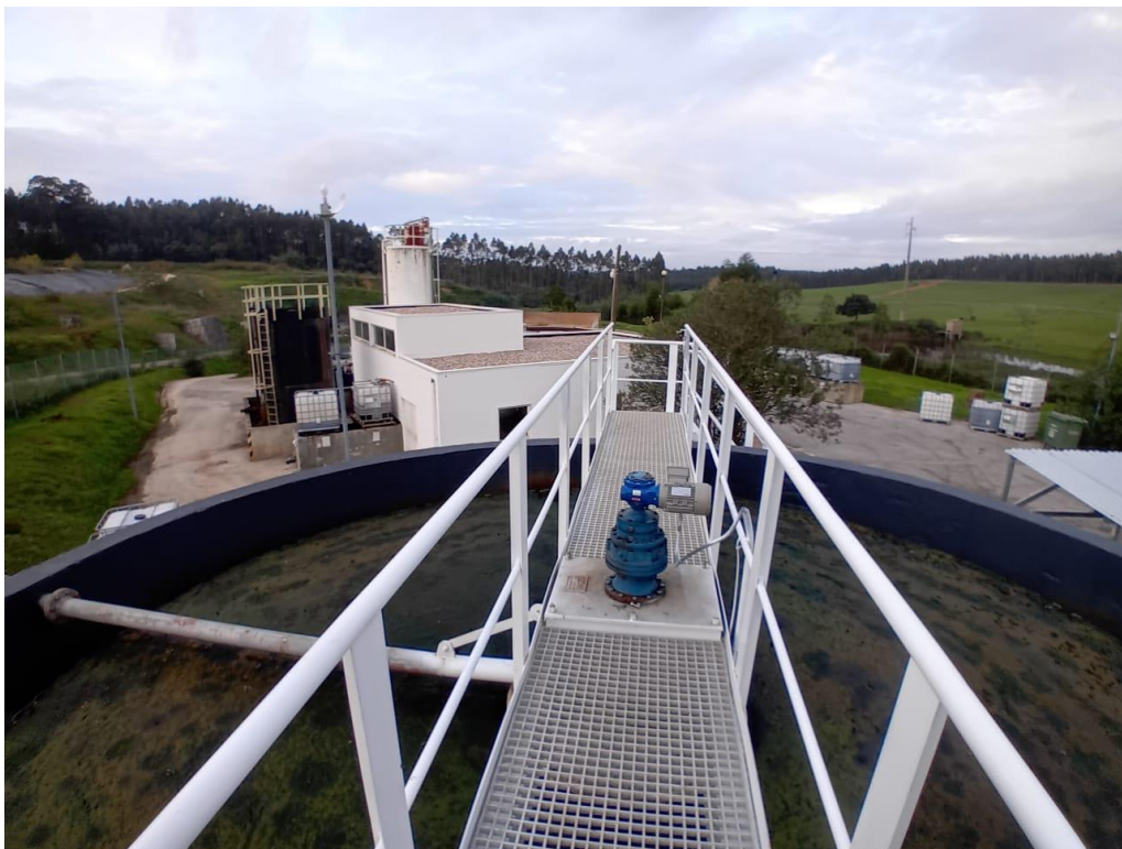
Figura 5.16 – Espessador de lamas restaurado
