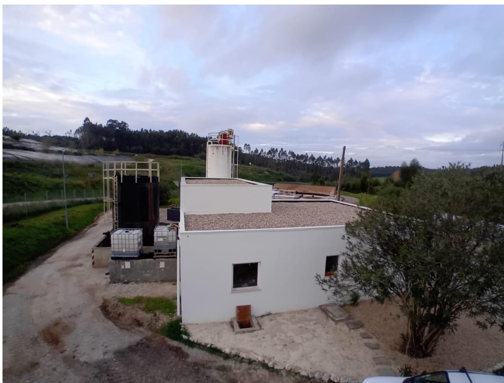
Figura 5.17 – Vista de cima do espessador de lamas, para o edifício de exploração restaurado
