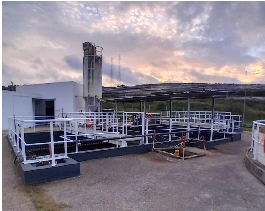
Figura 5.13 – Decantador biológico, decantador físico químico e telheiro restaurados
