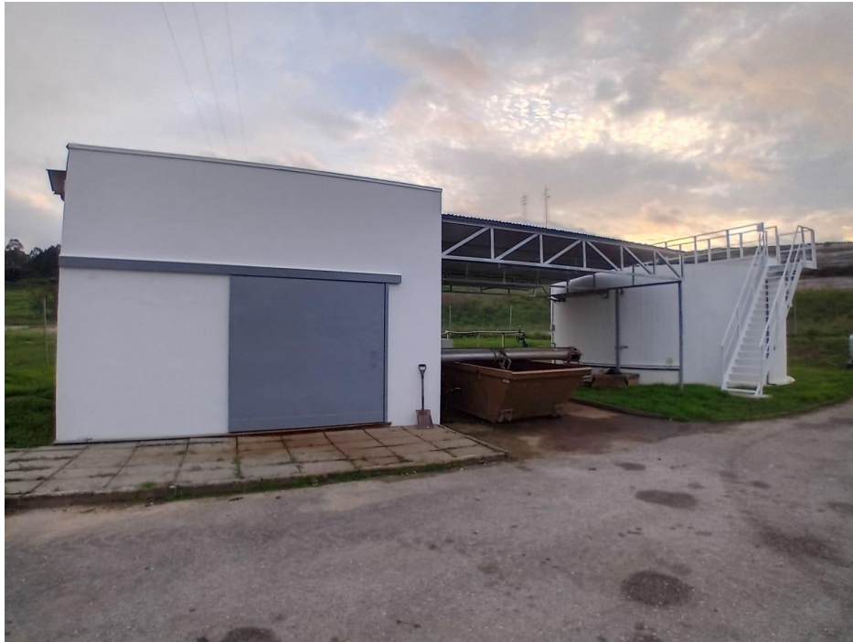
Figura 5.15 – Edifício de desidratação de lamas e espessador de lamas restaurado e telheiro novo entre ambos
