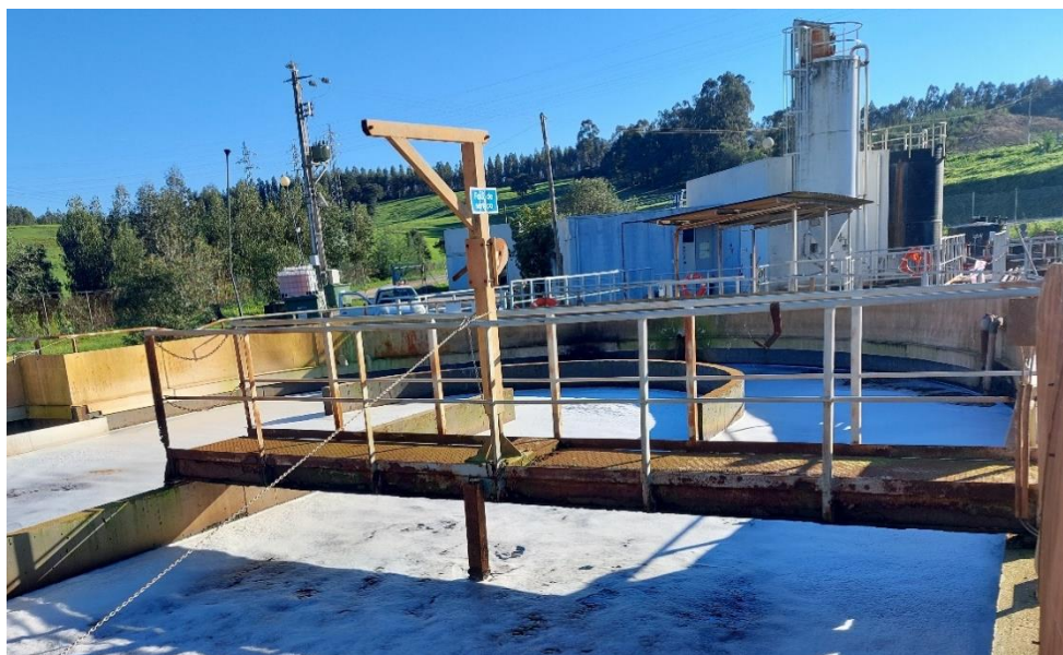
Figura 5.3 – Passadiço da vala de oxidação
