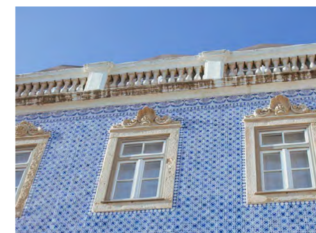
91 FACHADA DE EDIFÍCIO REVESTIDA COM AZULEJOS
