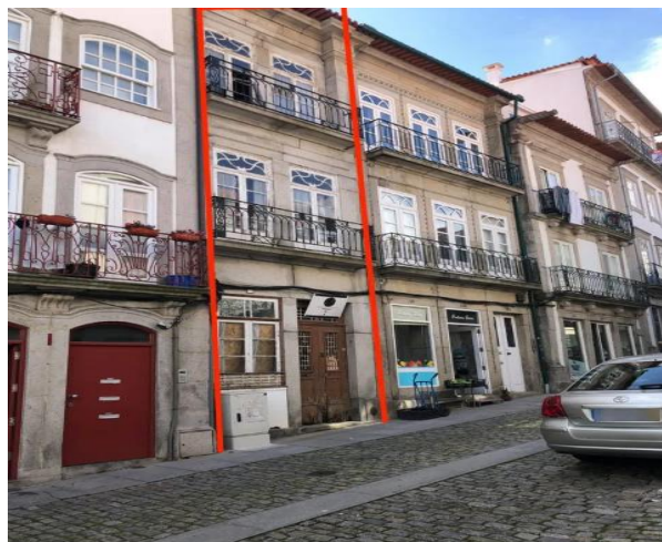
Figura 2: Paredes de empena comuns a dois edifícios.
