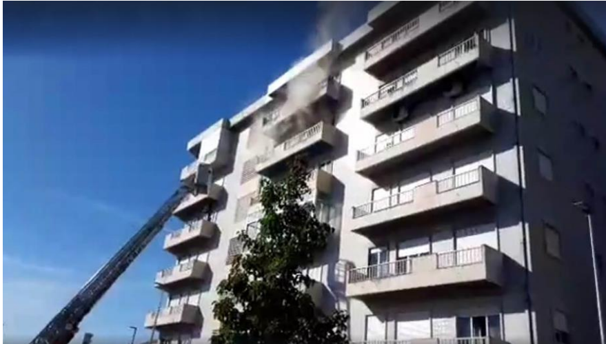
Figura 39: Incêndio na Avenida Afonso III, junho de 2017.
