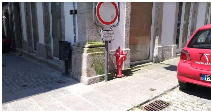
Figura 30: Marco de Incêndio- Rua Sacadura Cabral.
