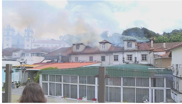
Figura 22: Incêndio no centro Histórico de Santa Maria da Feira.
