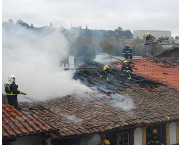
Figura 20: Incêndio no Centro Histórico de Guimarães. Fonte: (Bombeiros Voluntários de Guimarães, 2009).
