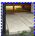
1 - lajetas de betão
