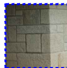
6- parede em pedra
