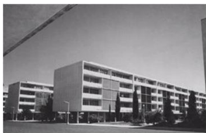
Fig. 48 Ruy Athougua e Sebastião Formosinho Sanches com o Bairro das Estacas (1949-55)
