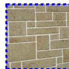
6 - parede em pedra
