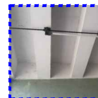
4 - tetos, estrutura tratada
