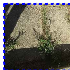
1- lajetas de betão
