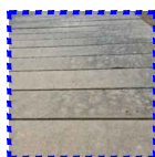
1 - lajetas de betão
