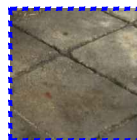
1- lajetas de betão
