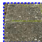
1- lajetas de betão
