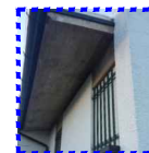
6 - paramentos em betão
