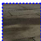
1- lajetas de betão
