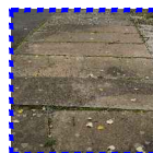
1- lajetas de betão
