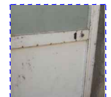
6 - caixilhos em ferro
