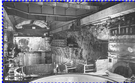
construção da central
