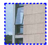
6 - caixilhos em alumínio
