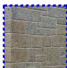
2 - parede em pedra
