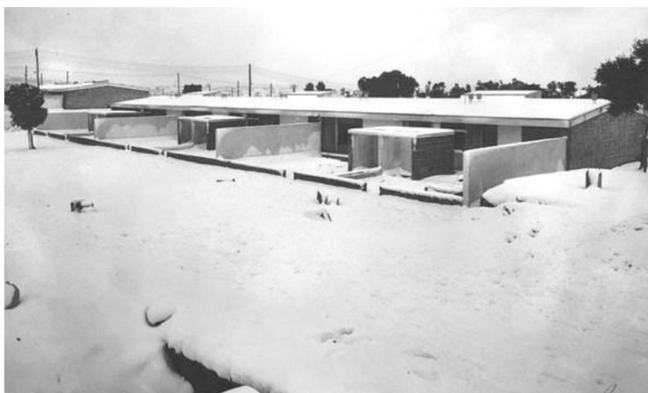
Fig. 88 Aspetos das coberturas das casas PE de Barrocal do Douro
