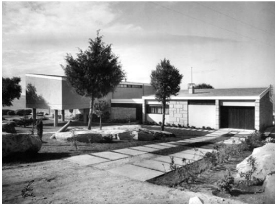
Fig. 78 Exterior das casas PD de Barrocal do Douro
