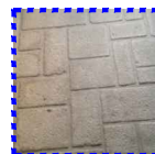
3 - pavimento em pedra
