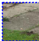
1- lajetas de betão
