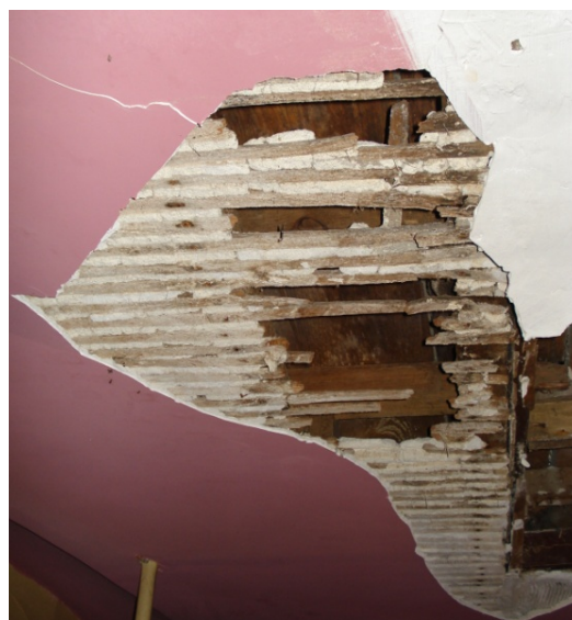
Tecto em Tabique – Fig 128
