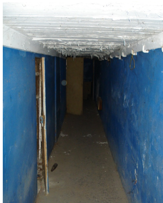
Corredor, (alvenaria de granito rebocado) e no lado esquerdo, a parede interior (tabique)
