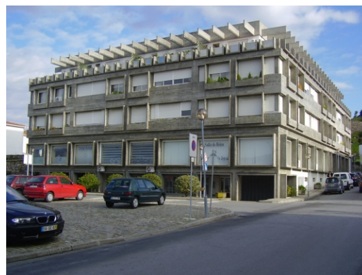
Edifício de comércio e habitação – Fig 88
