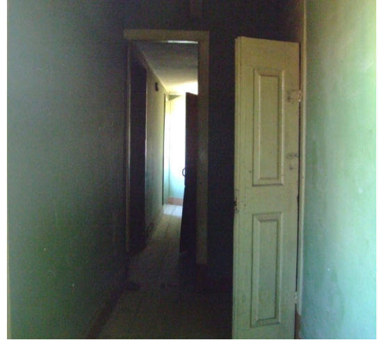
Paredes interiores – Fig 131
