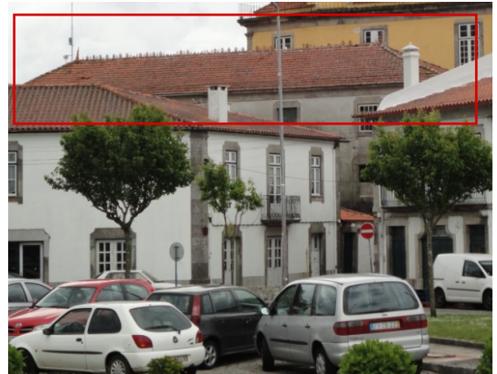
Teatro Valadares – Cobertura – Fig 124
