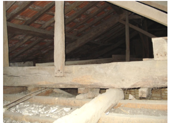
Estrutura de madeira_Cobertura – Fig 133
