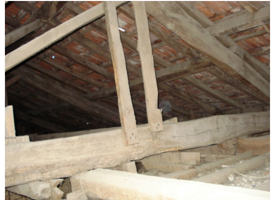
Estrutura da cobertura_Asna – Fig 132
