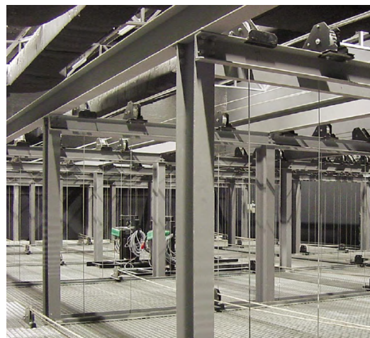
Estrutura da Caixa Cénica – Teatro de Vila Real Fig 34
