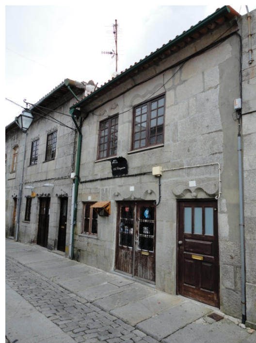
"Edifícios de Habitação/ Bar - Rua Ricardo Joaquim de Sousa " – Fig 98
