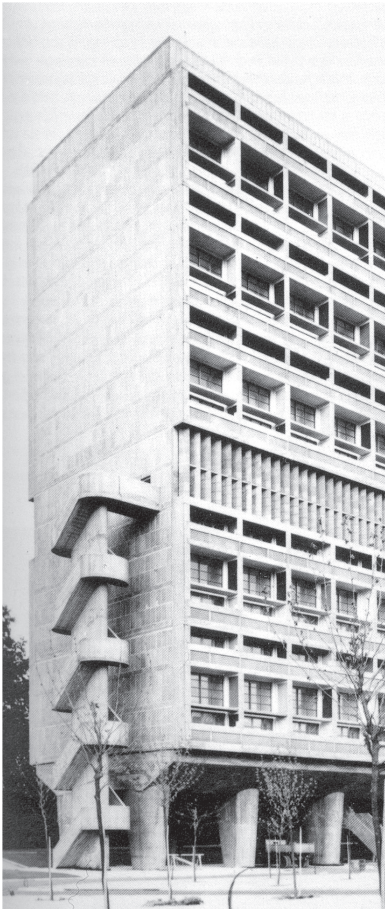
3.3.3 fig. 2 Imagem das escadas exteriores da fachada norte da Unidade de Habitação.
