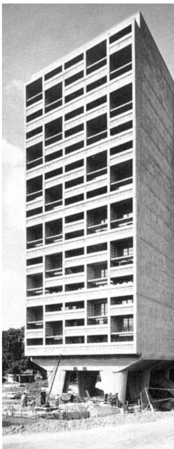
3.3.3 fig. 3 Imagem da fachada sul da Unidade de Habitação.
