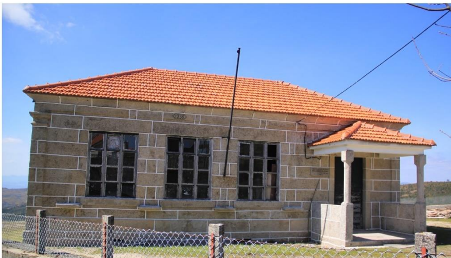
FOTOGRAFIA DA FACHADA
