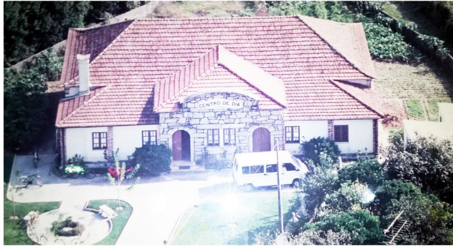
FOTOGRAFIA DA FACHADA PRINCIPAL EM 1998
