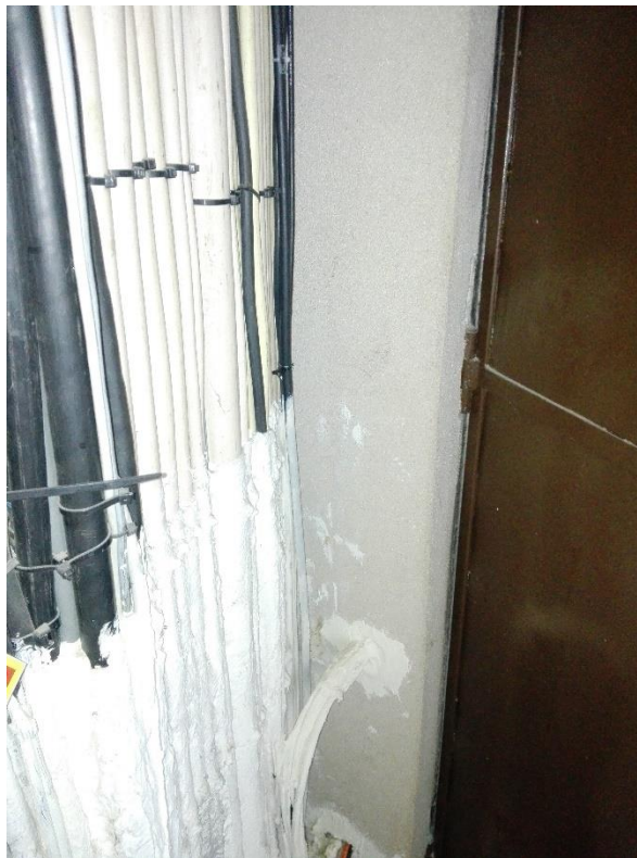
Figura 55-Entrada dos cabos para a casa das máquinas.
