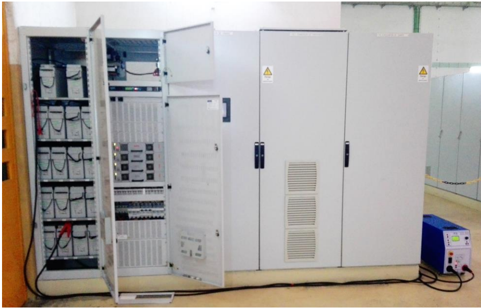
Figura 47-Ligação da carga resistiva BTS 200 à bateria.
