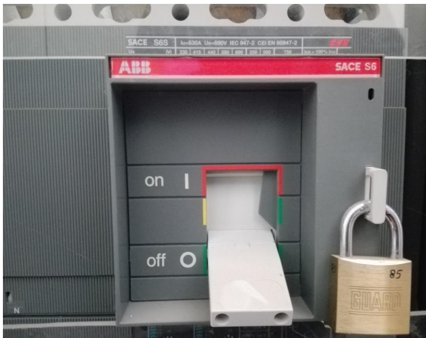
Figura 61- Disjuntor Magnetotérmico apto para seccionamento ABB S6S 630 PR211/ I_n = 630 \text{ A} tetrapolar (4p) F F.
