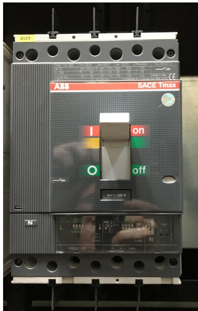
Figura 62- Disjuntor Magnetotérmico apto para seccionamento ABB T4N 320 PR221DS-LS/I I_n = 320 \text{ A} tetrapolar (4p) F F.
