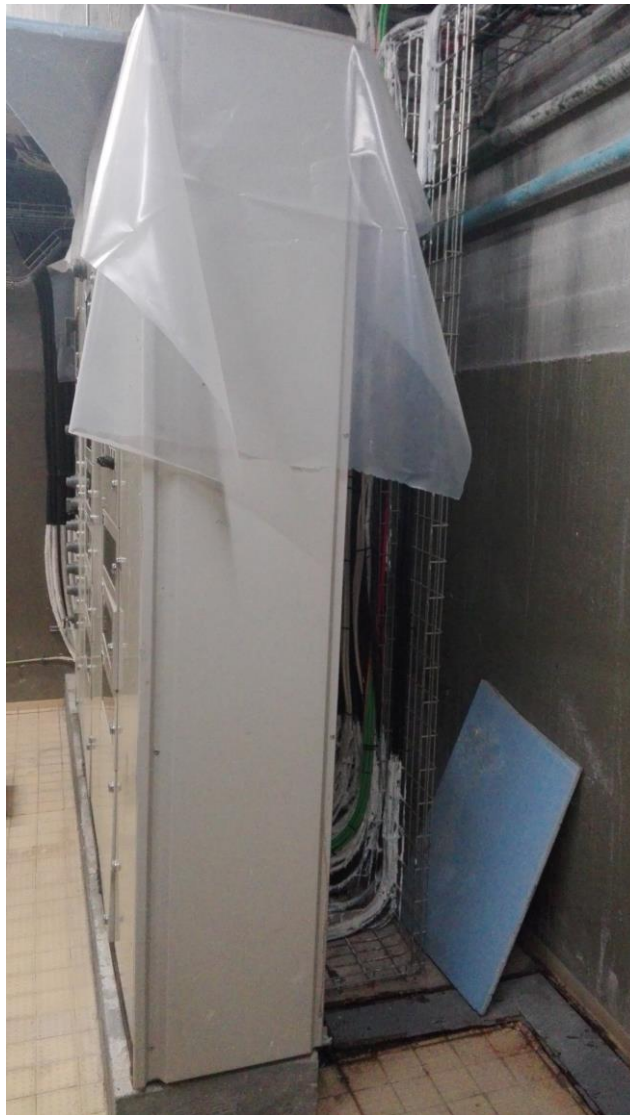
Figura 66-Painel QSAE3 e parte de trás onde irão ser instalados os cabos de alimentação em caminho de cabos.
