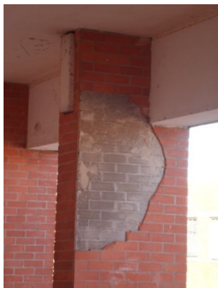
Figura 172 – Destacamento em tijolo face-à-vista
