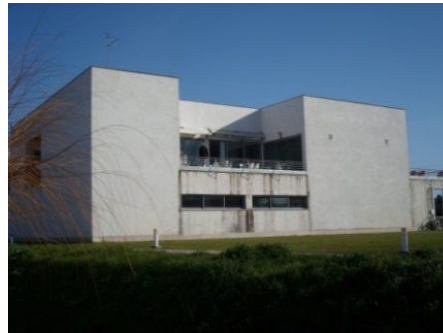
Figura 95 – Reboco projetado aplicado em parte do edifício da cantina
