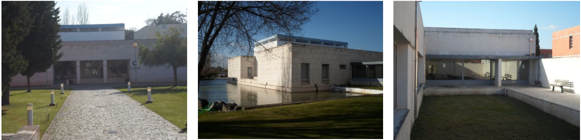
Figura 101 – Placas de pedra colada aplicadas na biblioteca
