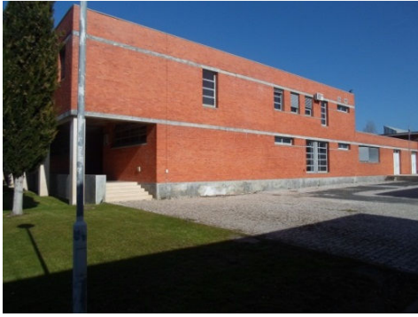
Figura 72 – Fachada do bloco L
