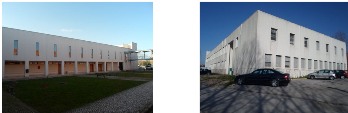
Figura 17 – Edifícios do bloco O
