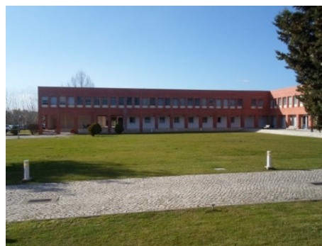
Figura 69 – Fachadas do bloco B
