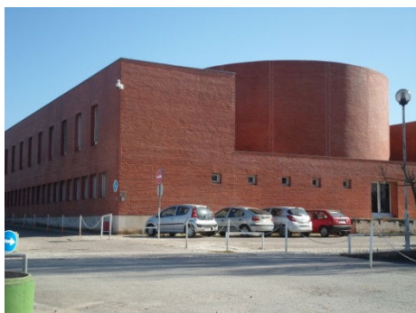
Figura 68 – Fachadas do bloco A
