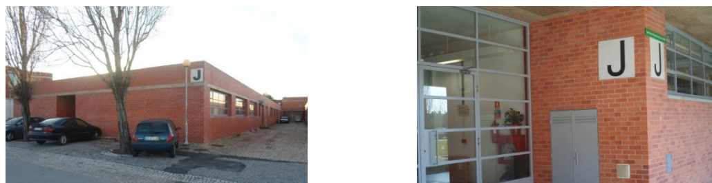
Figura 13 – Edifício do bloco J
