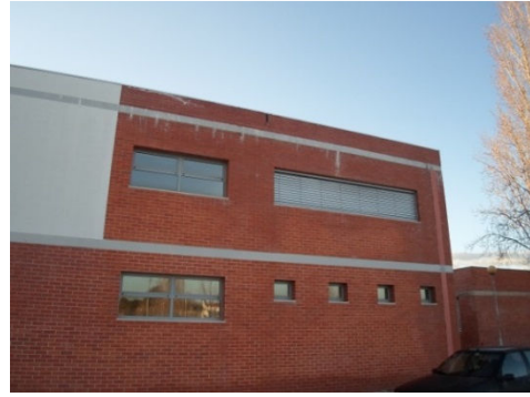
Figura 73 – Fachada do bloco Q
