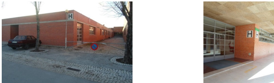
Figura 11 – Edifício do bloco H
