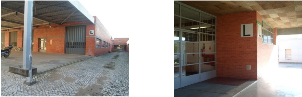
Figura 14 – Edifício do bloco L
