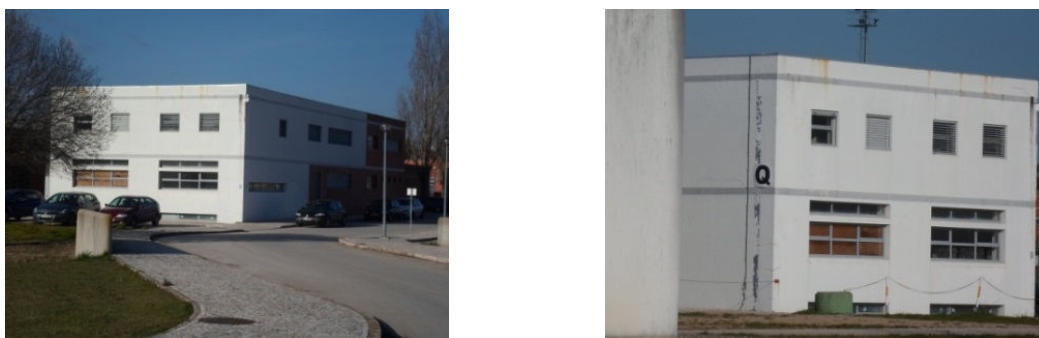
Figura 93 – Reboco tradicional aplicado no edifício Q
