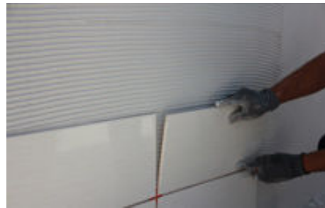
Figura 99 – Colocação do revestimento [24]
