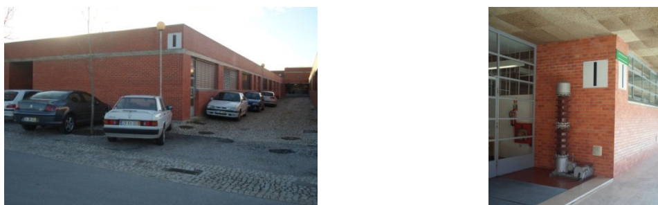
Figura 12 – Edifício do bloco I
