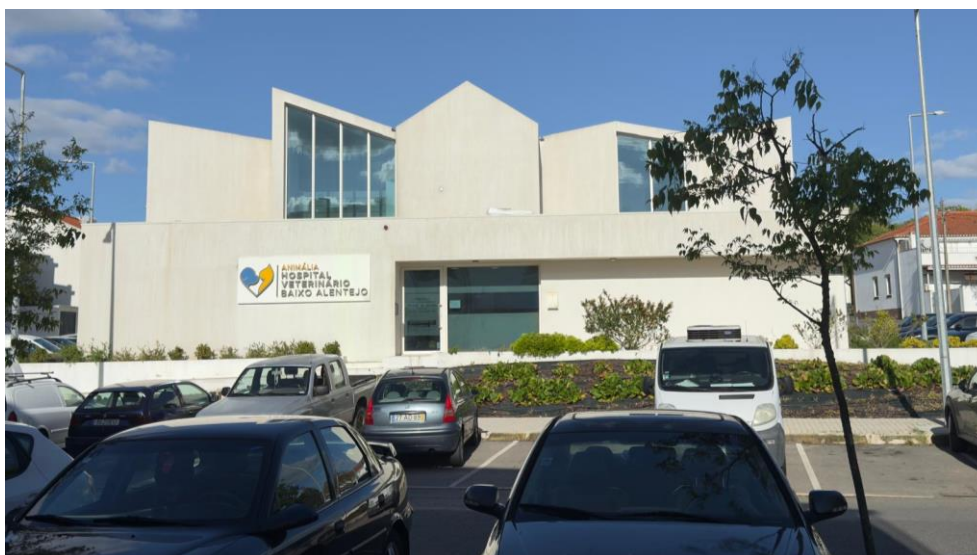
FIGURA 6 - INSTALAÇÕES DO HVBA
