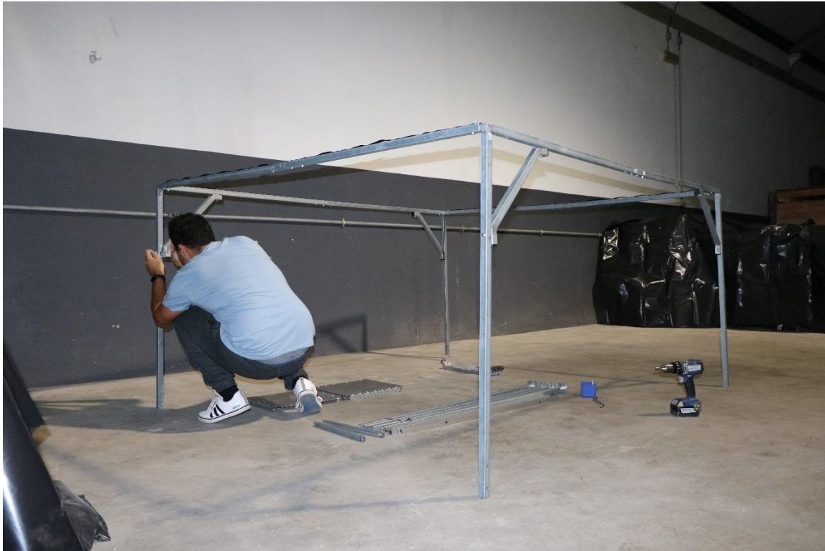
Figura 59 - Montagem da instalação - 5
