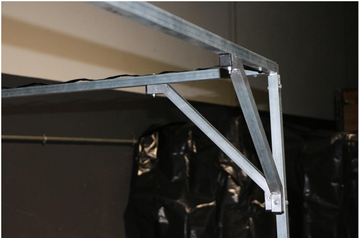
Figura 58 - Montagem da instalação - 4
