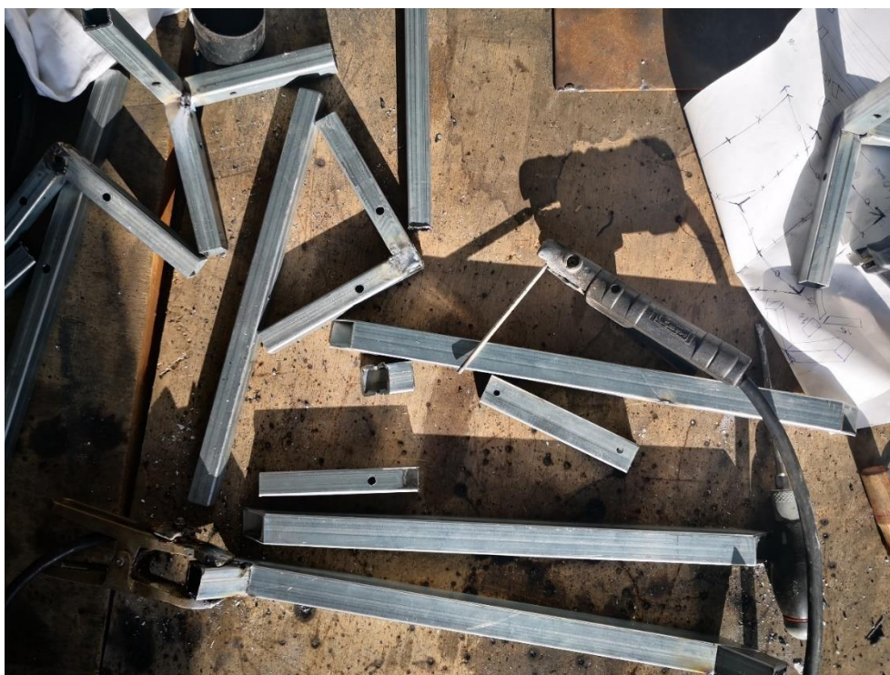
Figura 51 - Construção da instalação - 3
