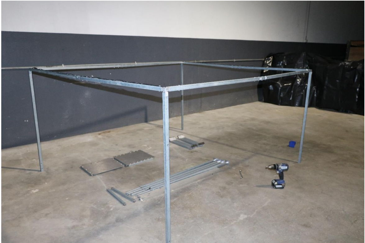
Figura 57 - Montagem da instalação - 3
