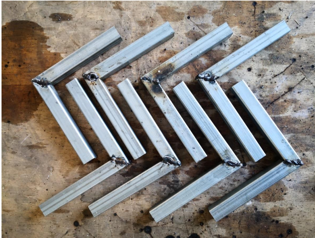
Figura 52 - Construção da instalação - 4
