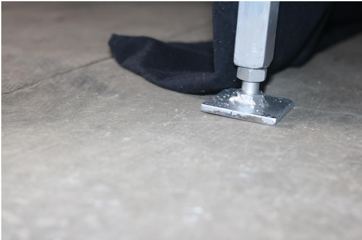
Figura 64 - Montagem da instalação - 10
