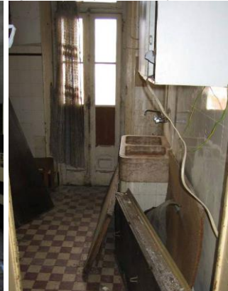
Fig.175- Cozinha revestimento em mosaico
