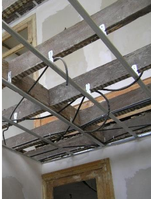
Fig. 109- Estrutura de madeira dos pisos
