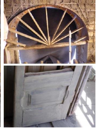
Fig.185- Reforço e restauro dos vãos
