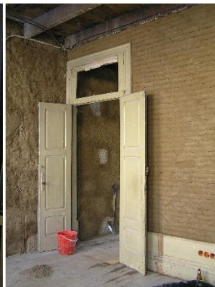
Fig.108- Aplicação de reboco nas paredes
