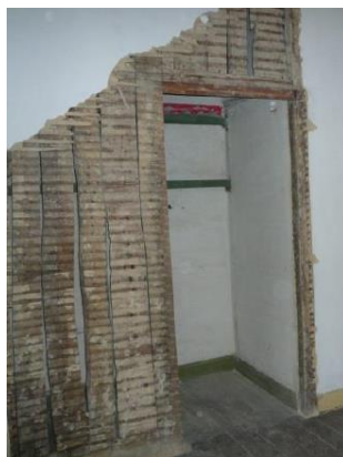
Fig.159- Remoção dos rebocos danificados
