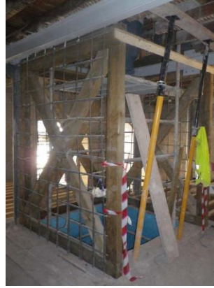
Fig.184- Execução de elevador
