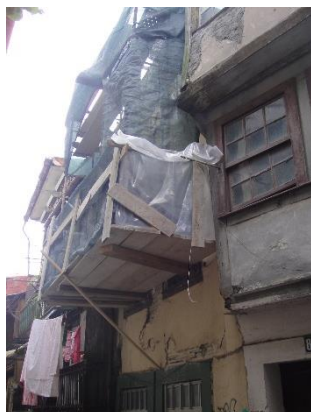
Fig.132- Recuperação da fachada da rua
