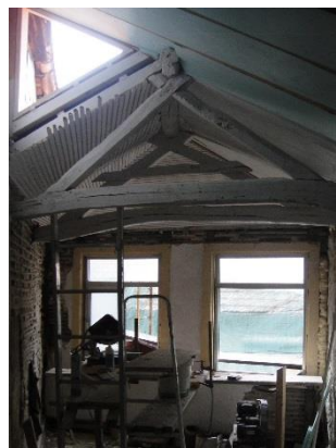
Fig.136- Execução do ripado (piso 2)
