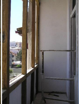
Fig.111- Execução da fachada tardoz
