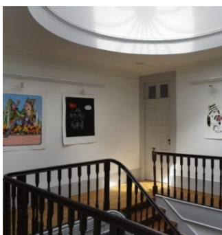
Fig.16- Caixa de escadas e claraboia
