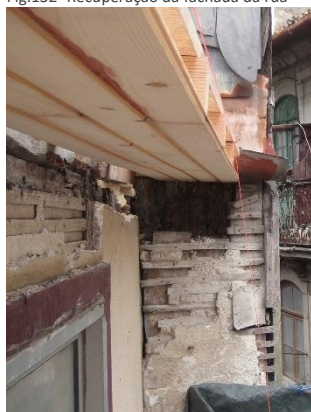
Fig.134- Recuperação da fachada
