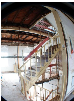
Fig. 82- Demolições e soalho (piso 1)
