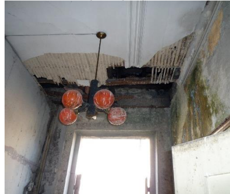
Fig.98- Degradação da cobertura e excesso de compartimentação
