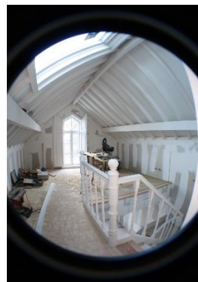
Fig.84- Gesso cartonado e cob. (piso 2)
