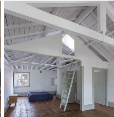
Fig.167- Quarto/sala do recuado (piso 3)
