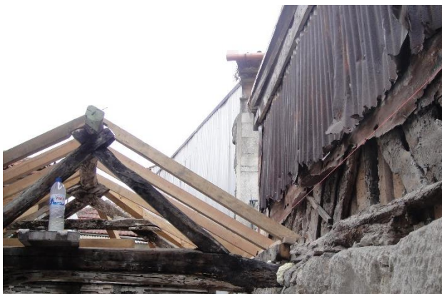
Fig.133- Substituição de vigas da cobertura
