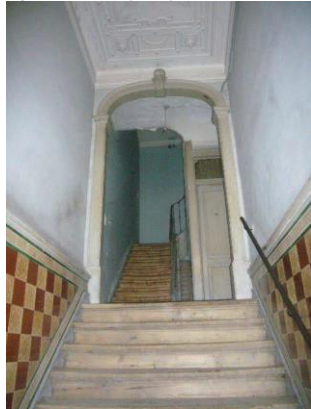
Fig.173- Entrada e caixa de escadas
