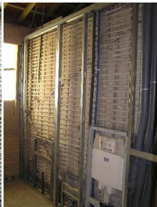
Fig.107- Execução parede gesso cartonado
