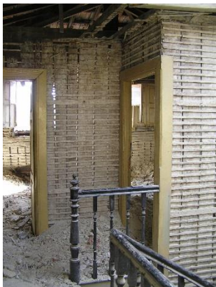
Fig.106- Remoção dos rebocos (piso 2)
