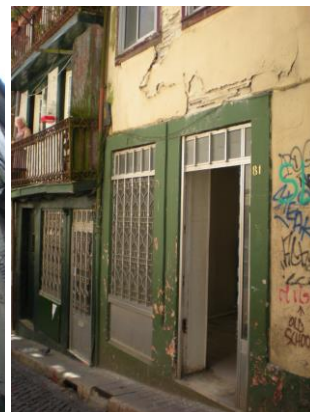
Fig.122- Caixilhariias de alumínio da fachada
