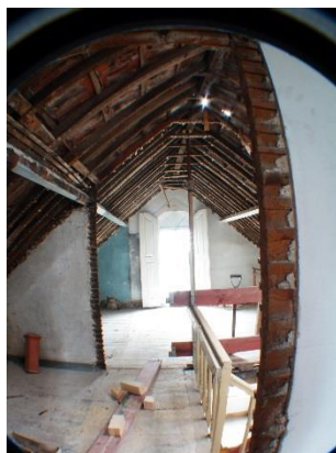
Fig.83- Recuperação cobertura (piso 2)
